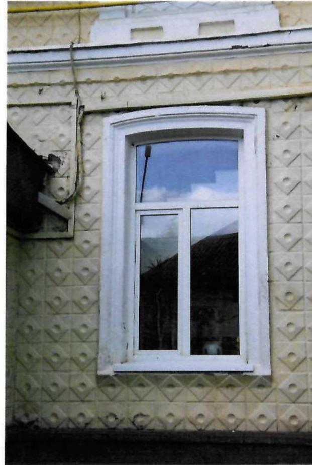
2.3.4.2. Месторасположение, форма и габариты 2-х оконных проемов с лучковыми перемычками и профилированными наличниками на втором этаже на 1870 год. Тип 4;
