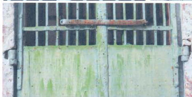
Фурнитура и крепежные элементы ставней-решеток
