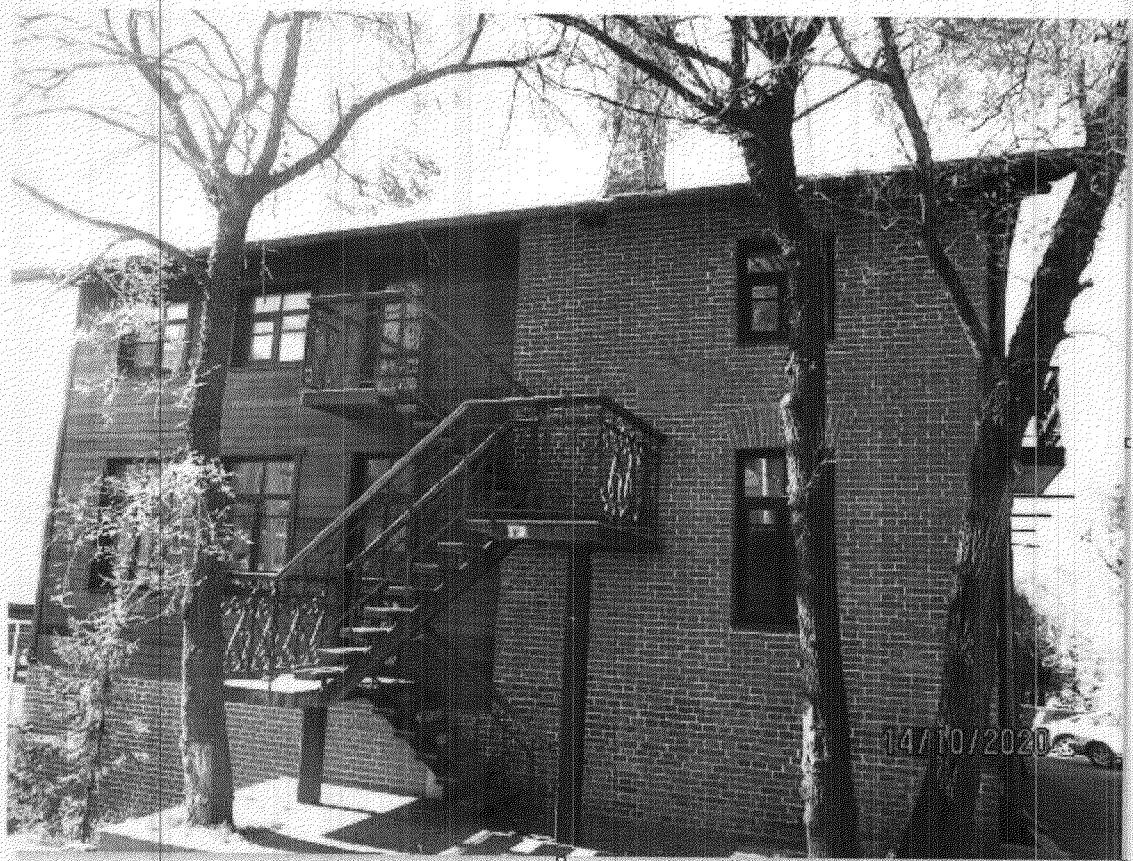
Асимметричное композиционное решение сформировано сочетанием одноосной правой части кирпичной кладки фасада и трехосной левой части фасада в уровне второго и третьего этажей, обшитой горизонтальным тесом, визуально объединенных открытой лестницей.
