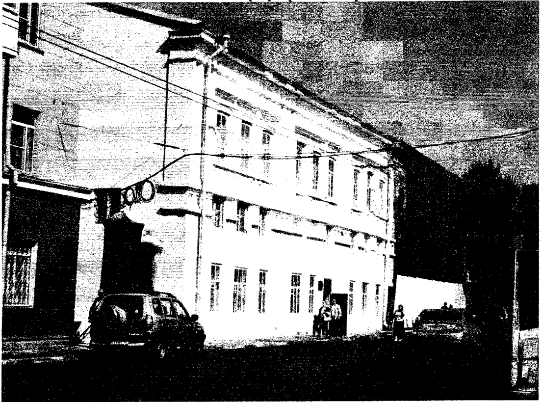
2. Фасад по ул. Желябова (юго-восточный)
