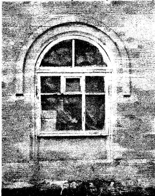
14. Оформление окна первого этажа фасада по пер.Гусарова
