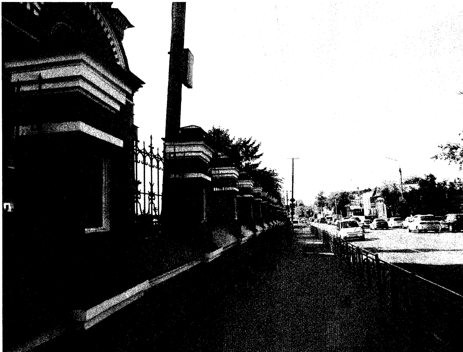
Фото 3 - Кирпичное ограждение со стороны ул. Баррикад
