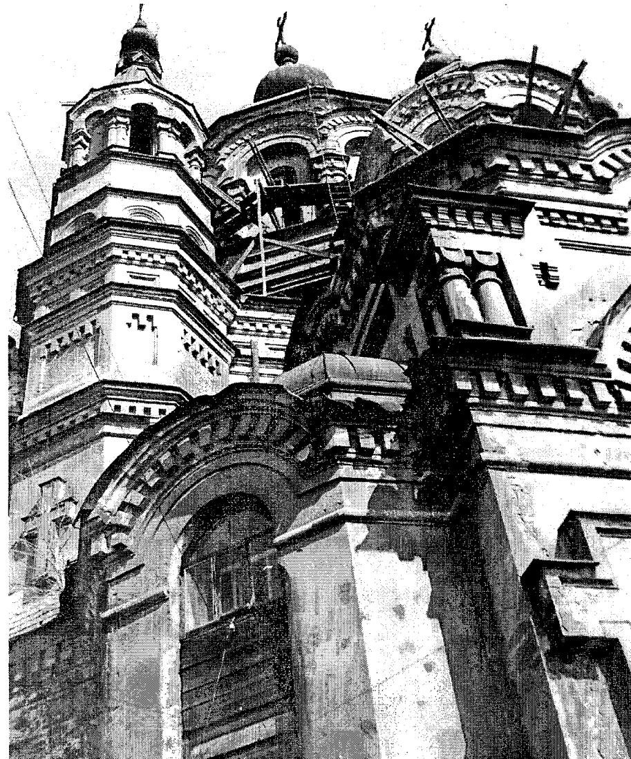
Фото 21 - Вид на завершение храма от стены юго-западного фасада (фото Барановского Е.Ю. от 1979г.)
