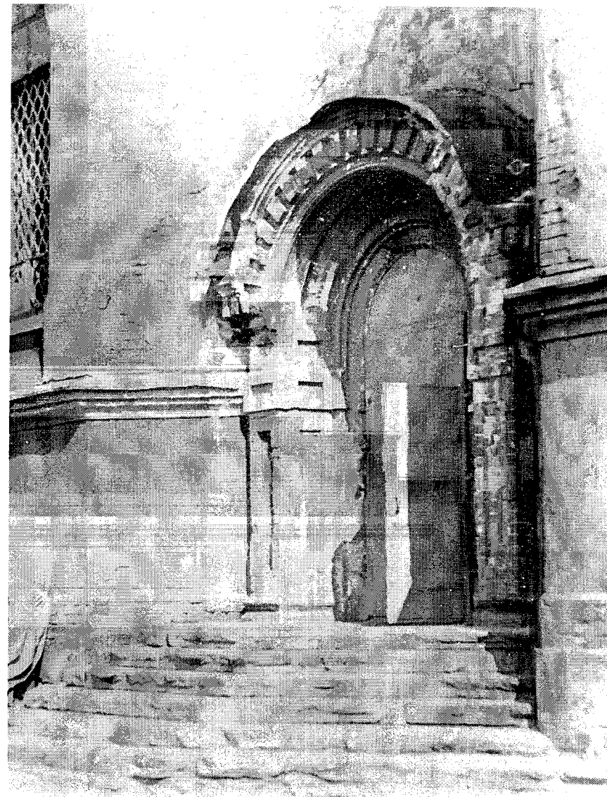
Фото 29 - Портал бокового входа в придел, западная башня (фото Барановского Е.Ю. от 1979г.)
