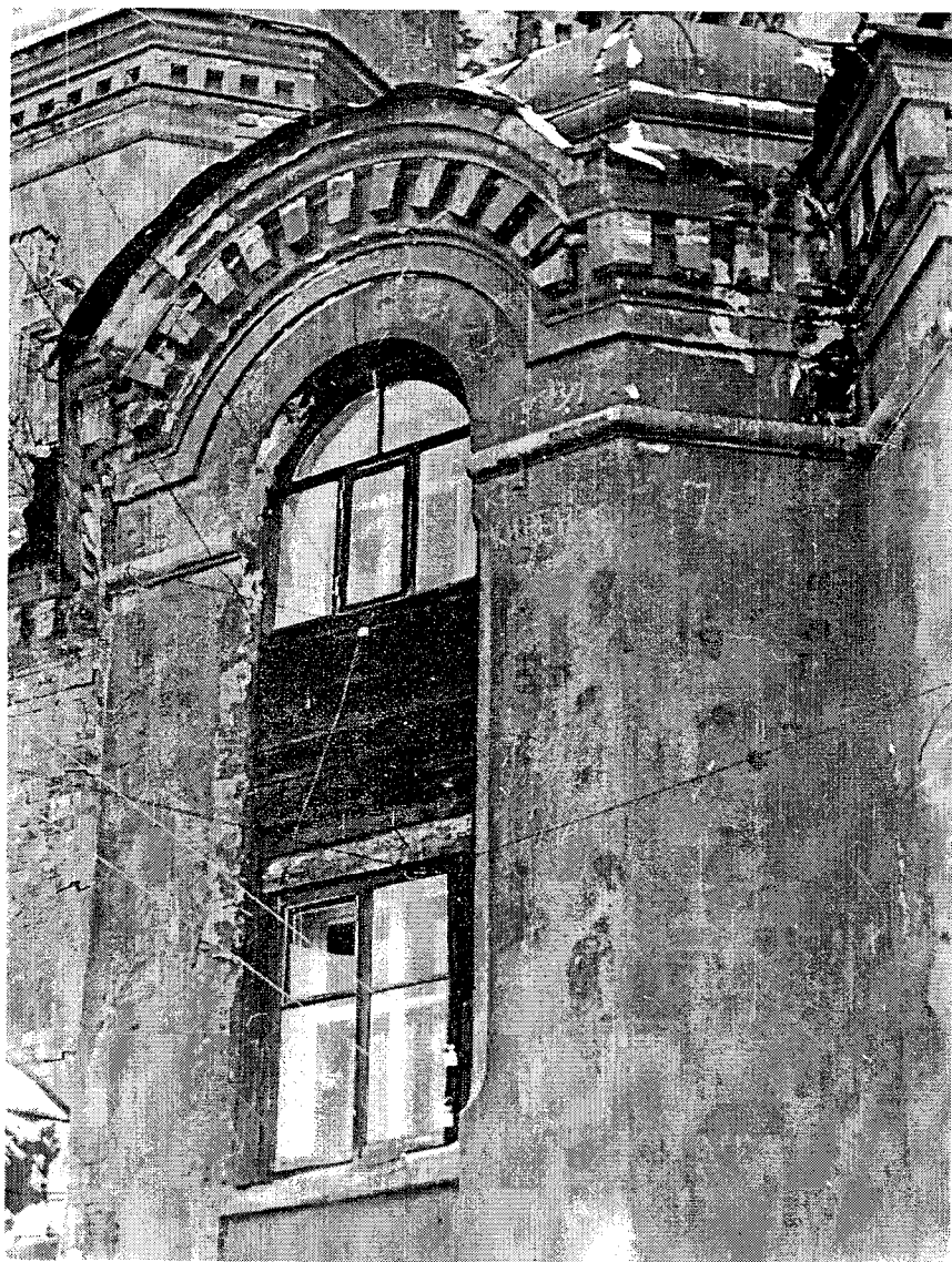
Фото 22 - Окно юго-западного притвора (фото Барановского Е.Ю. от 1979г.)
