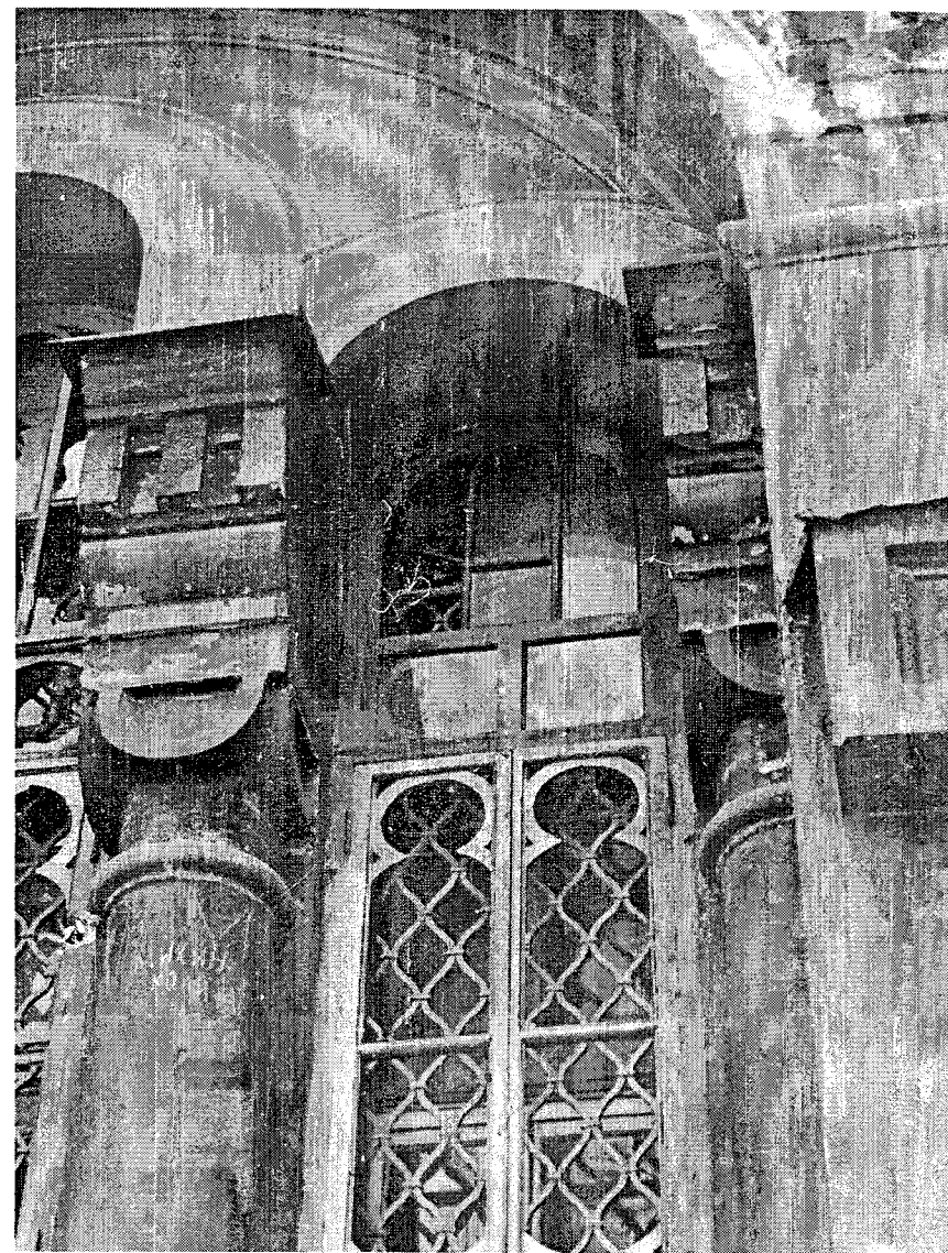
Фото 25 - Портал с тройным окном в стене юго-западного придела (фото Барановского Е.Ю. от 1979г.)
