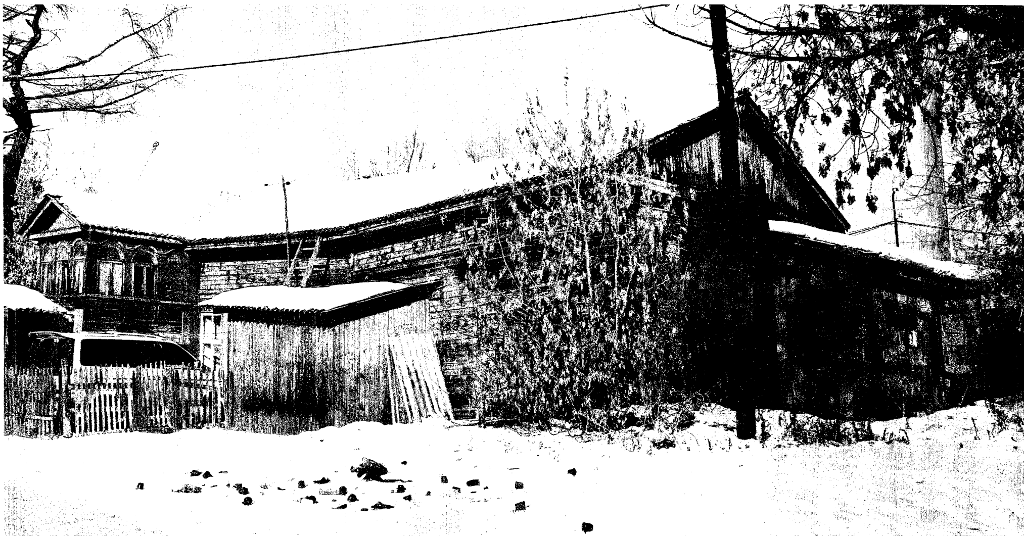
Фото 11 - Общий вид дома с южного угла.
