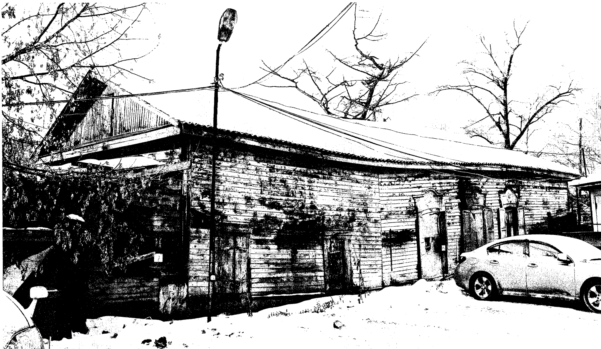
Фото 9 - Общий вид дома с восточного угла
