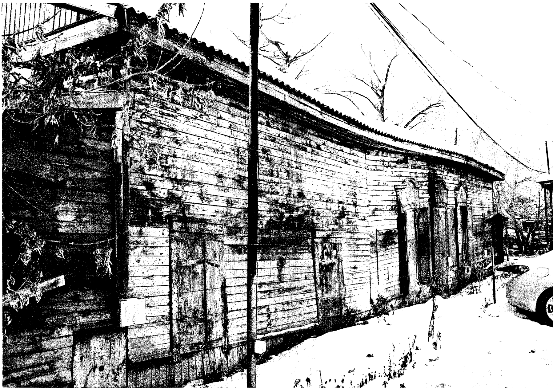
Фото 8 - Северо-восточный фасад. Вид с восточного угла
