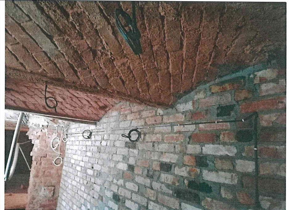
Рисунок 21. Подвал. Перекрытия, своды «Монье».
