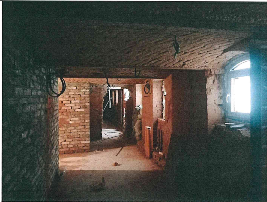
Рисунок 20. Подвал. Перекрытия, своды «Монье».
