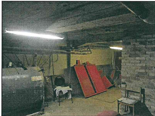
Фото 80. Подвал. Южная часть объекта. Конструкции стен, перекрытий.
