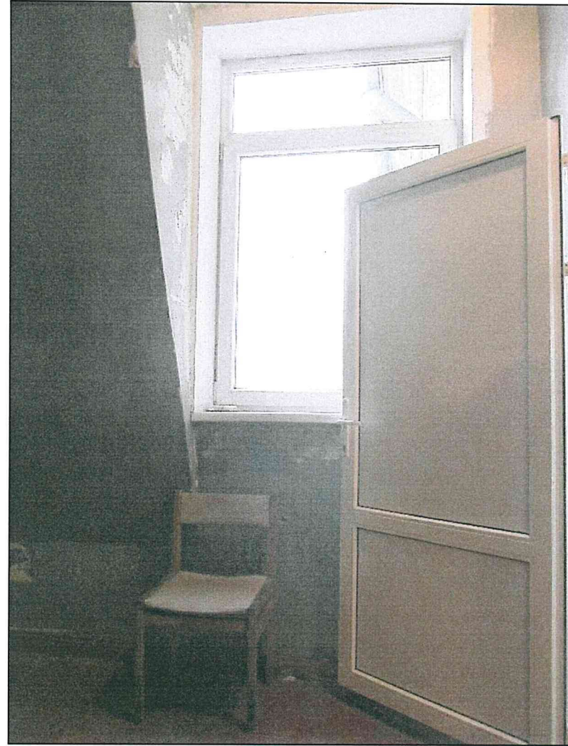
Фото 134. Третий этаж - мансарда южной части объекта. Конструкции стен. Конструкции стропильной системы крыши.
