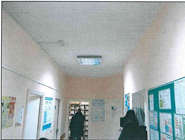
Фото 125. Третий этаж - мансарда северной части объекта. Конструкции стен, перекрытий.
