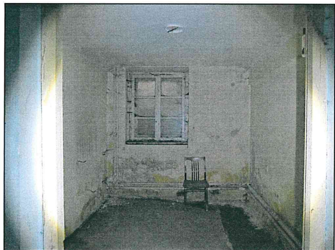
Фото 92. Подвал. Южная часть объекта. Конструкции стен, перекрытий. Конструкции оконных проемов.
