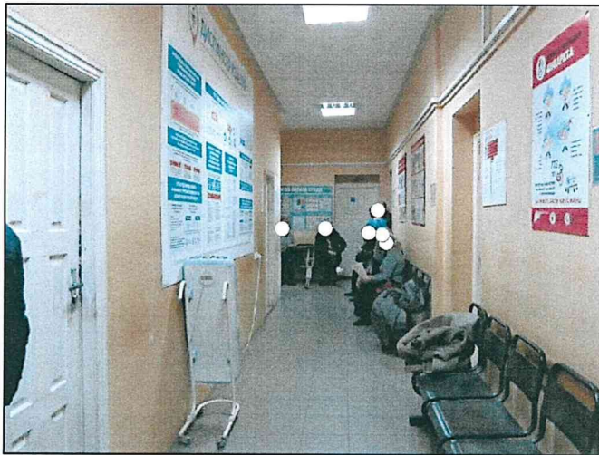
Фото 119. Второй этаж южной части объекта. Конструкции стен.
