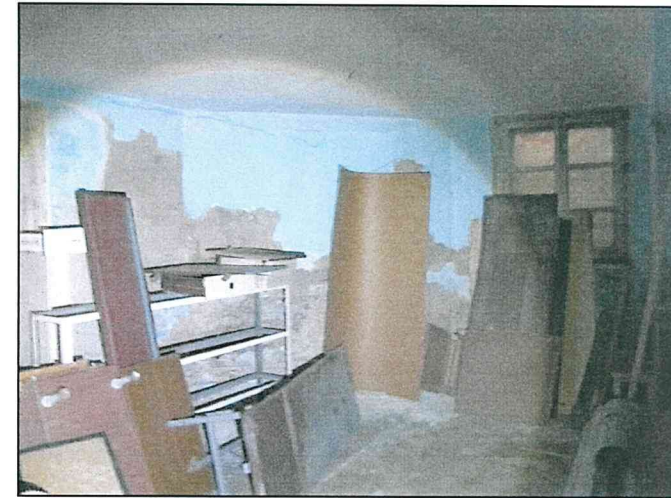
Фото 89. Подвал. Южная часть объекта. Конструкции стен, перекрытий. Конструкции оконных проемов.
