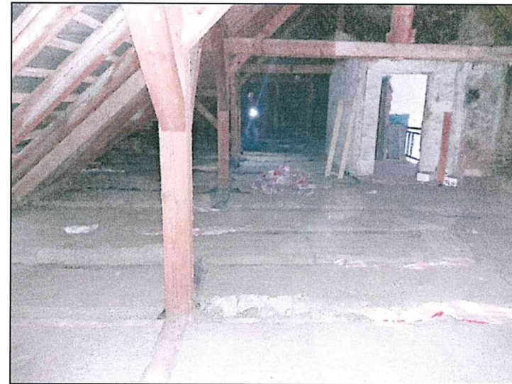
Фото 142. Чердак. Северная часть объекта. Конструкции стропильной системы.
