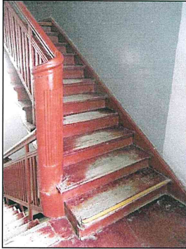
Фото 132. Третий этаж - мансарда южной части объекта.
