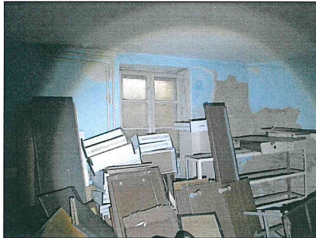
Фото 88. Подвал. Южная часть объекта. Конструкции стен, перекрытий. Конструкции оконных проемов.
