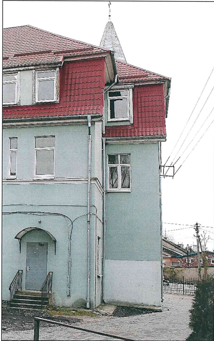
Фото 46. Общий вид. Фасад № 7.
