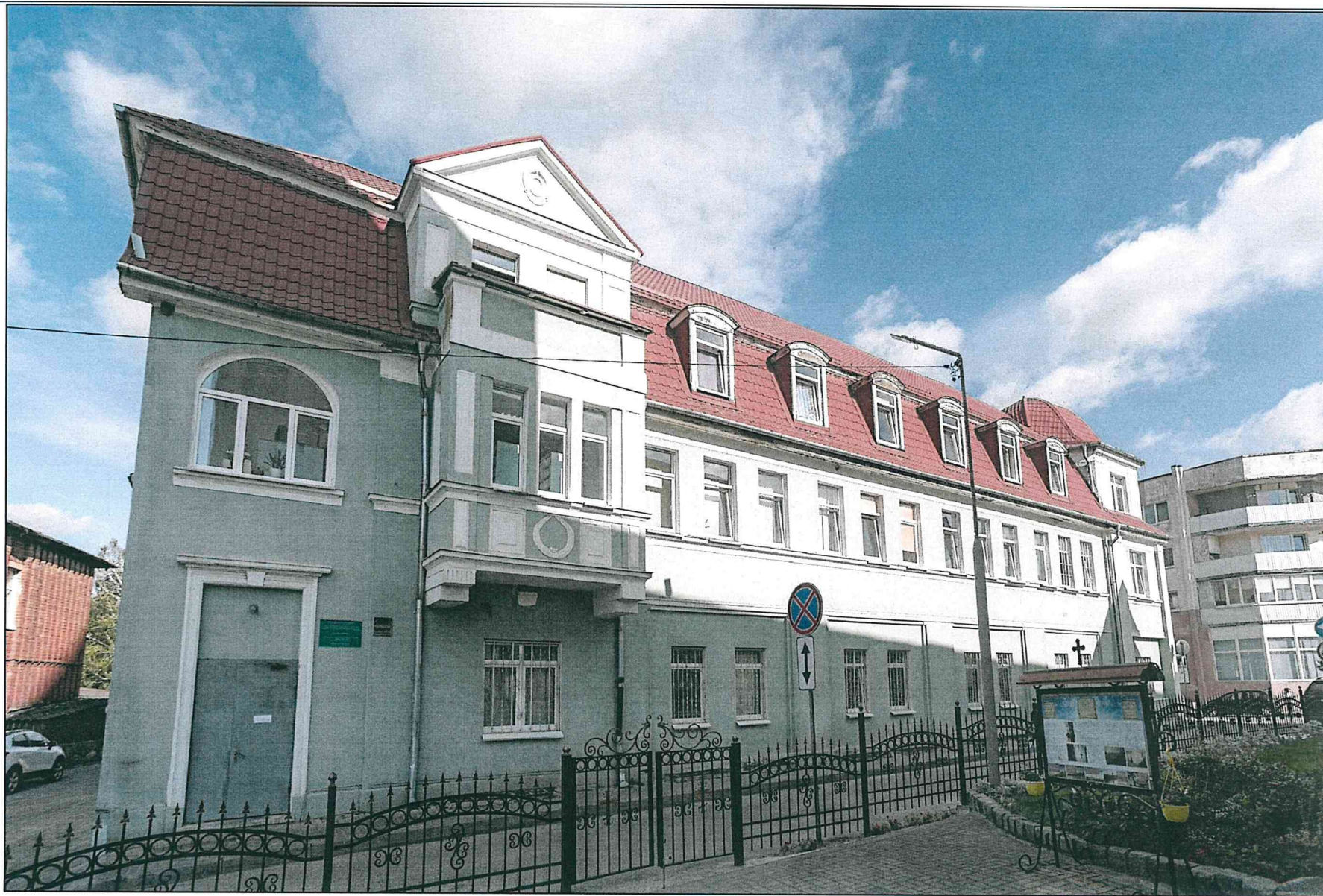
Фото 58. Общий вид. Фасад № 9.
