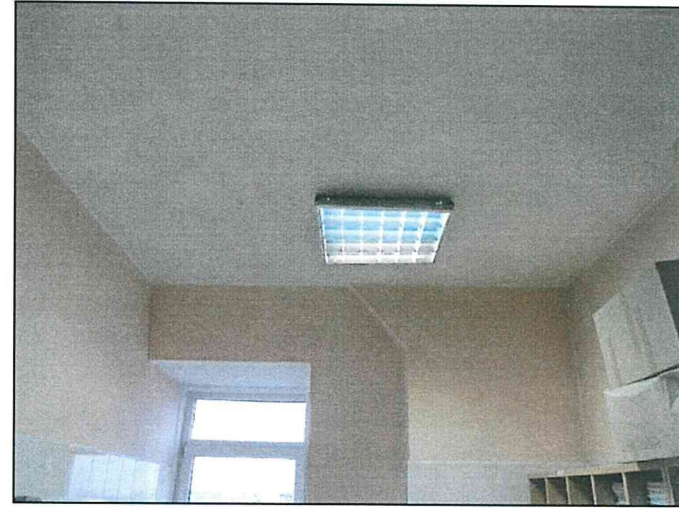
Фото 126. Третий этаж - мансарда северной части объекта. Конструкции стен, перекрытий. Конструкции оконных проемов.
