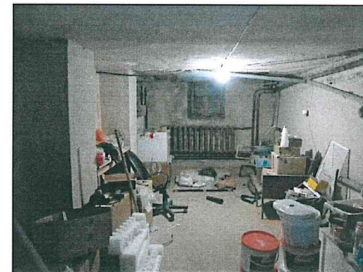
Фото 82. Подвал. Северная часть объекта. Конструкции стен, перекрытий. Конструкции оконных проемов.
