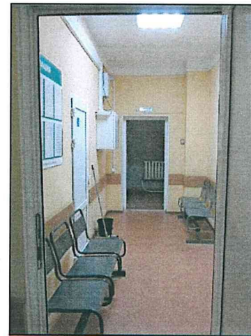
Фото 131. Третий этаж - мансарда южной части объекта. Конструкции стен. Конструкции дверных проемов.
