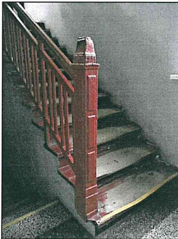
Фото 109. Первый этаж южной части объекта. Конструкции стен. Конструкции межэтажной лестницы.
