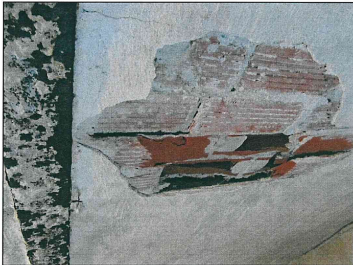
Фото 84. Подвал. Северная часть объекта. Конструкции перекрытий.
