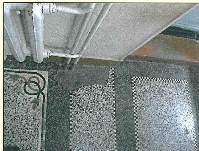
Фото 99. Первый этаж северной части объекта. Конструкции пола.
