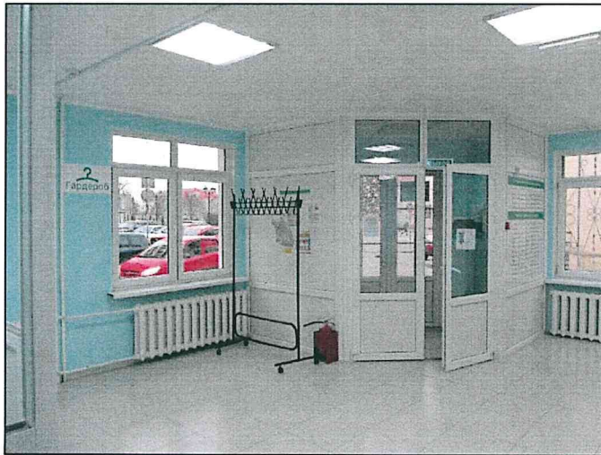
Фото 105. Первый этаж южной части объекта. Конструкции стен.
