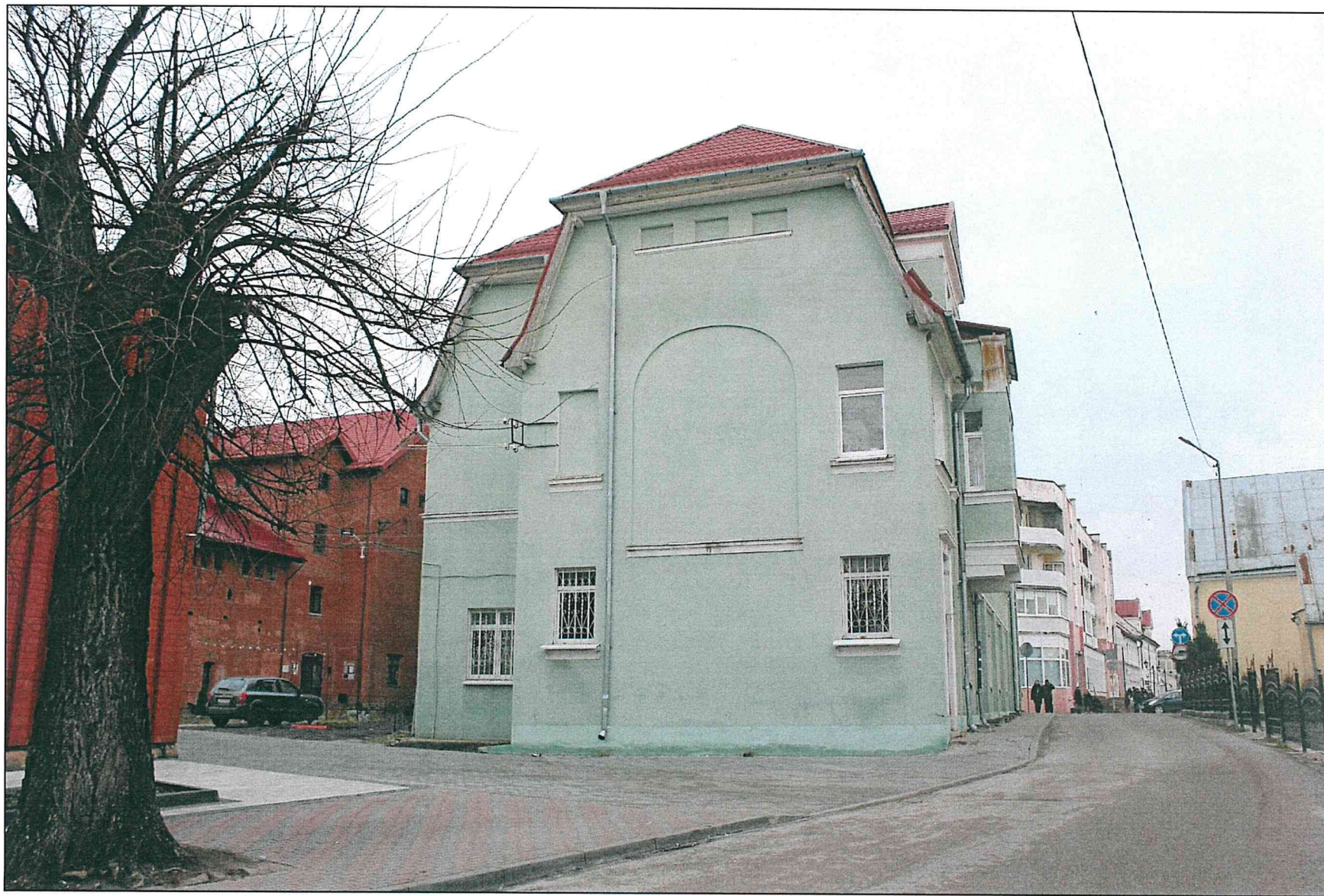
Фото 49. Общий вид. Фасад № 6. Фасад № 8.
