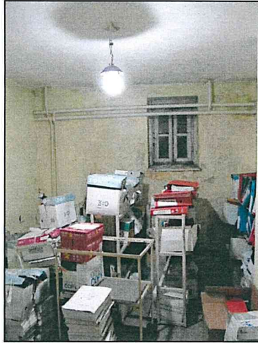
Фото 87. Подвал. Южная часть объекта. Конструкции стен, перекрытий. Конструкции оконных проемов.
