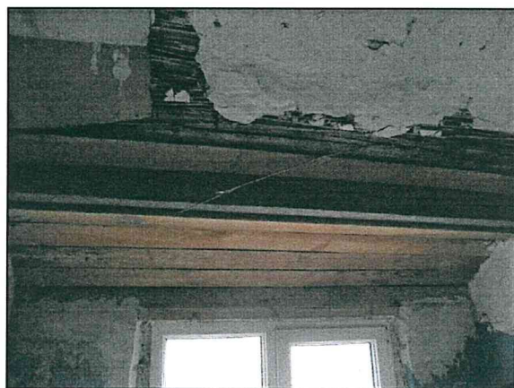
Фото 136. Третий этаж – мансарда южной части объекта. Чердак. Конструкции стропильной системы крыши. Конструкции оконных проемов.
