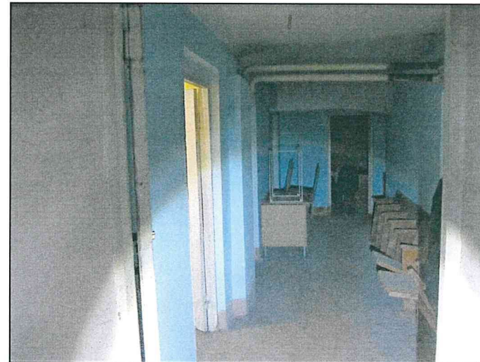
Фото 86. Подвал. Южная часть объекта. Конструкции стен, перекрытий.
