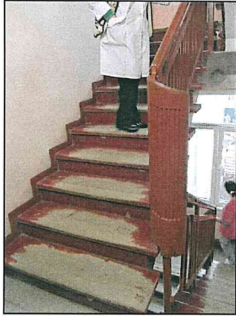
Фото 114. Второй этаж северной части объекта. Конструкции межэтажной лестницы.
