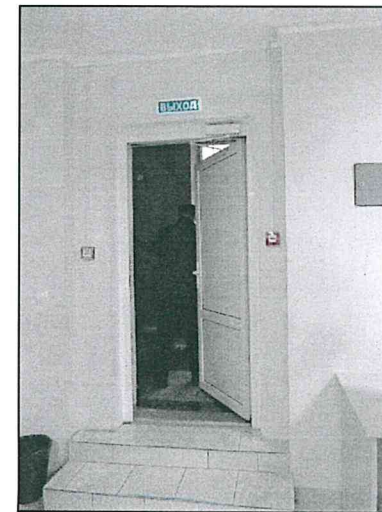
Фото 107. Первый этаж южной части объекта. Конструкции стен.
