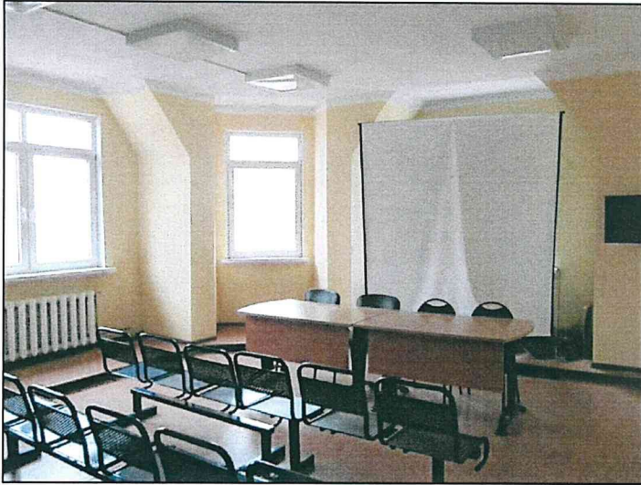
Фото 128. Третий этаж - мансарда южной части объекта. Конструкции оконных проемов.
