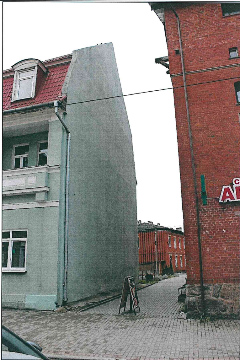
Фото 36. Общий вид. Фасад № 3.
