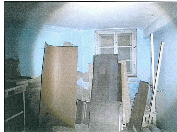
Фото 90. Подвал. Южная часть объекта. Конструкции стен, перекрытий. Конструкции оконных проемов.
