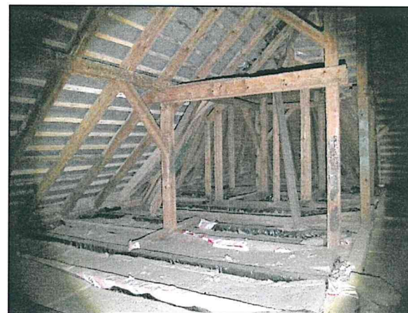
Фото 138. Чердак. Южная часть объекта. Угловая часть. Конструкции стропильной системы.
