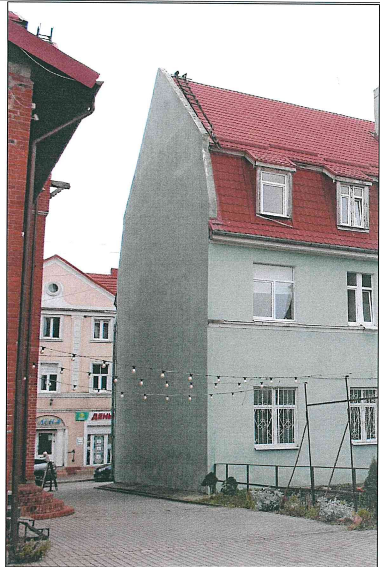
Фото 37. Общий вид. Фасад № 3.
