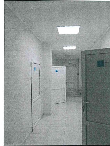
Фото 106. Первый этаж южной части объекта. Конструкции стен, колонн.
