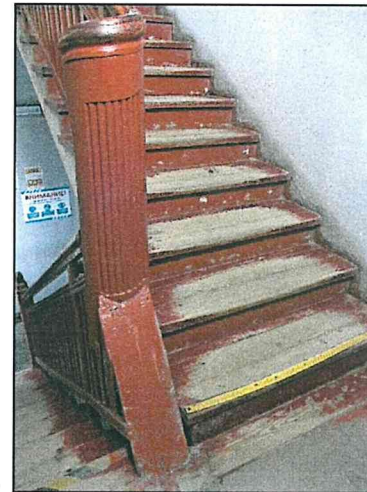
Фото 111. Первый этаж южной части объекта. Конструкции стен. Конструкции межэтажной лестницы, межэтажная площадка.
