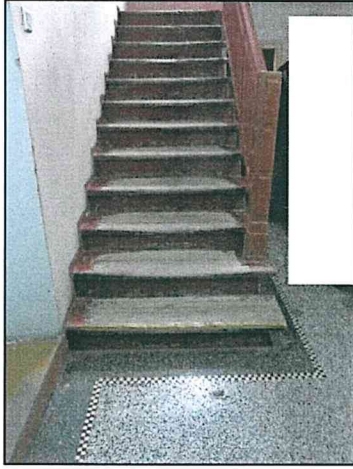
Фото 100. Первый этаж северной части объекта. Конструкции межэтажной лестницы. Конструкции пола.
