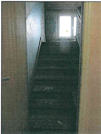
Фото 135. Третий этаж – мансарда южной части объекта. Чердак. Конструкции межэтажной лестницы.
