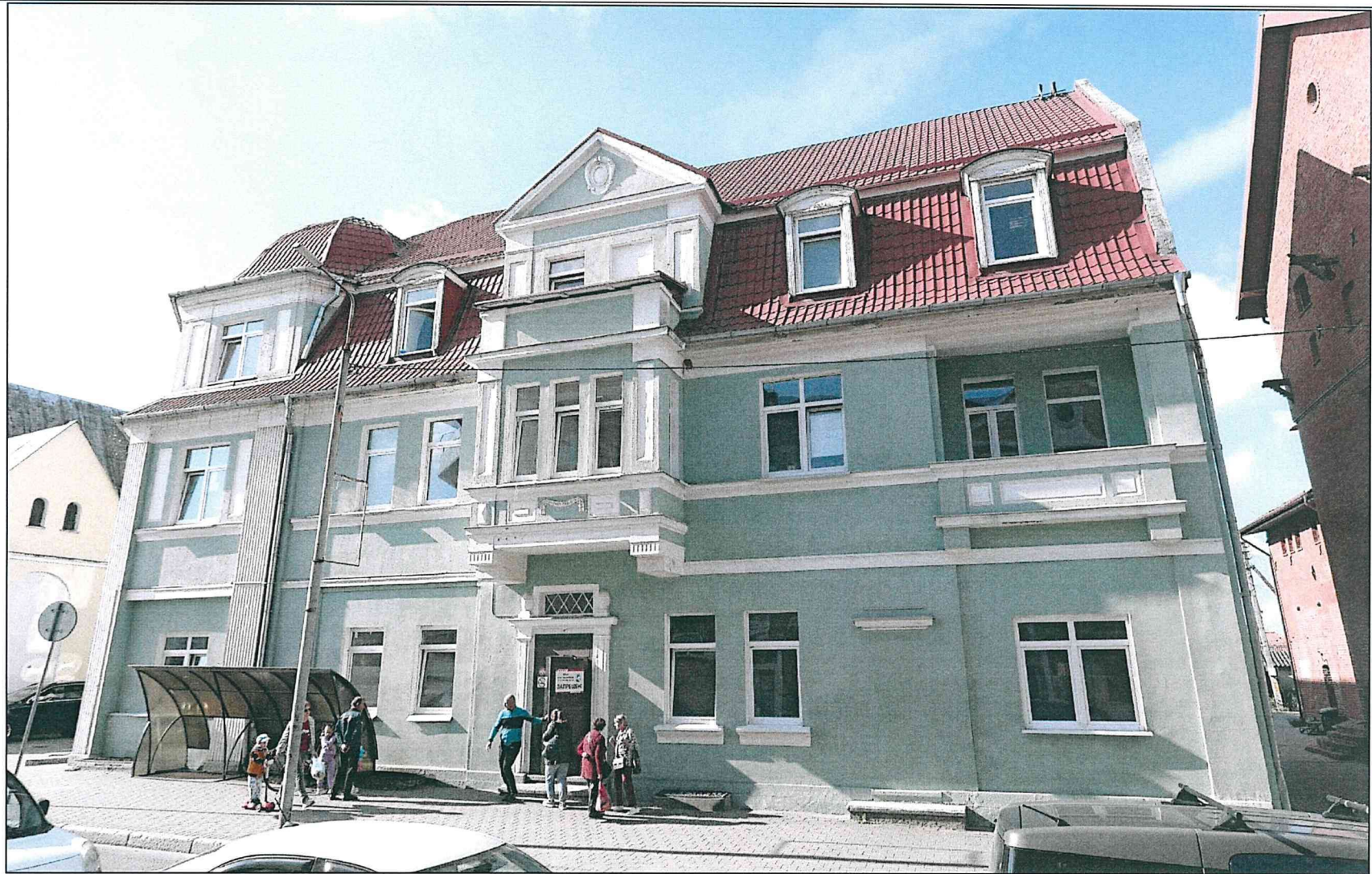
Фото 17. Общий вид. Фасад № 2.
