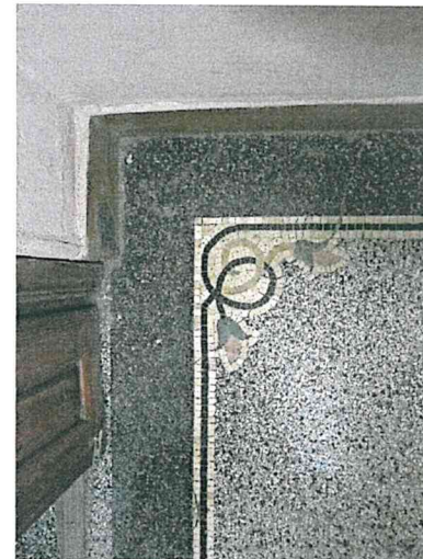
Фото 98. Первый этаж северной части объекта. Конструкции пола.
