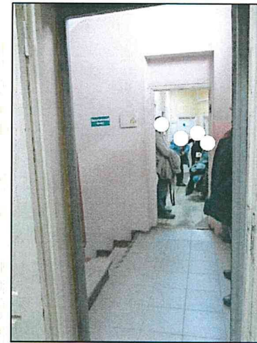
Фото 121. Второй этаж южной части объекта. Конструкции стен.
