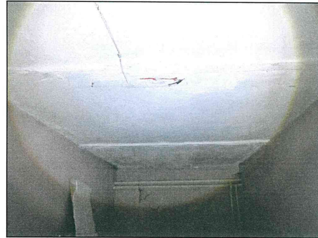
Фото 85. Подвал. Северная часть объекта. Конструкции стен, перекрытий.
