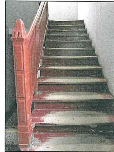
Фото 110. Первый этаж южной части объекта. Конструкции стен. Конструкции межэтажной лестницы.
