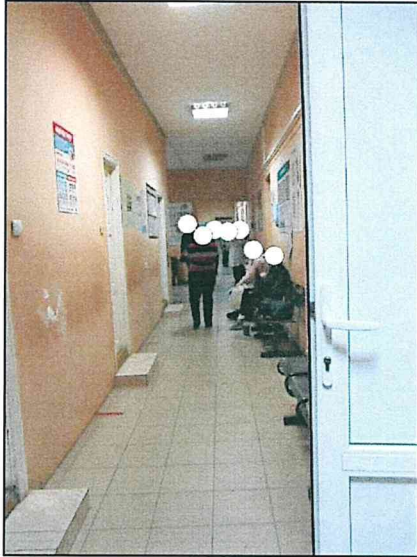
Фото 118. Второй этаж южной части объекта. Конструкции стен.
