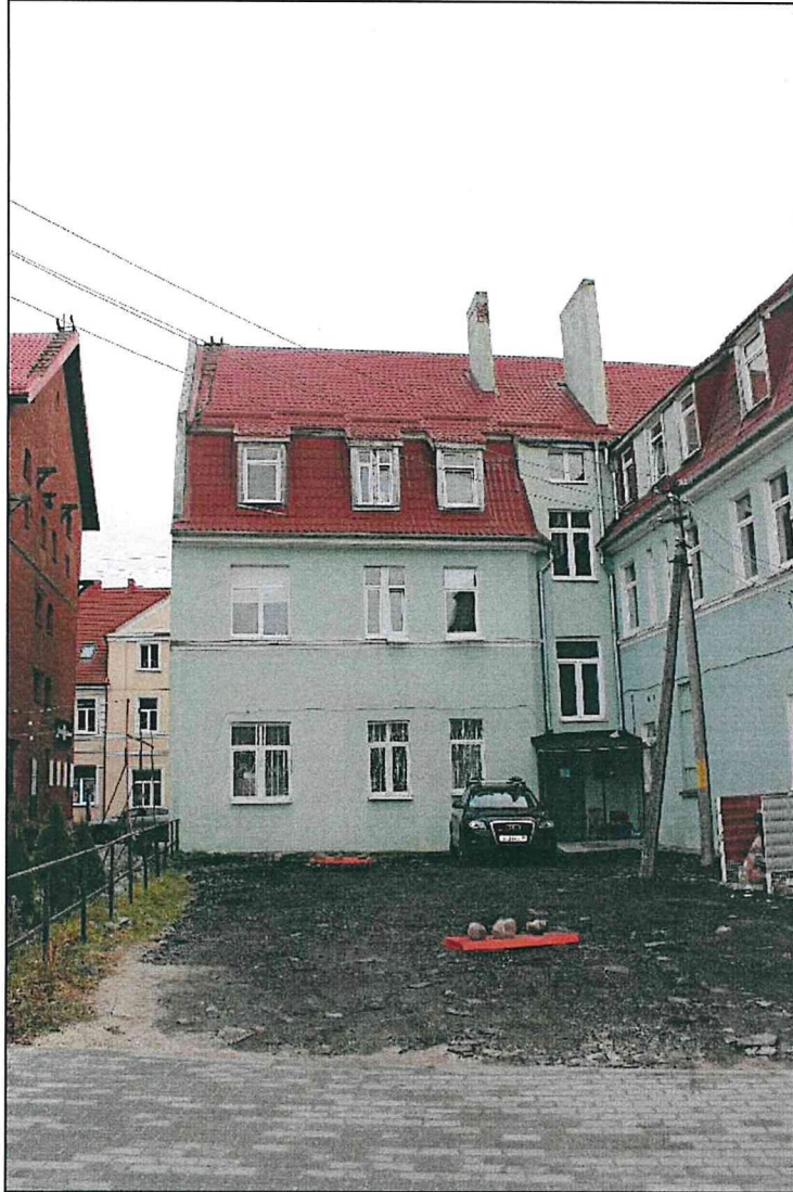
Фото 38. Общий вид. Фасад №4.
