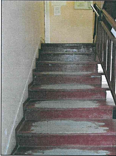
Фото 124. Третий этаж - мансарда северной части объекта. Конструкции межэтажной лестницы.
