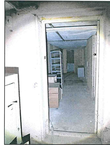
Фото 81. Подвал. Северная часть объекта. Конструкции стен, перекрытий.
