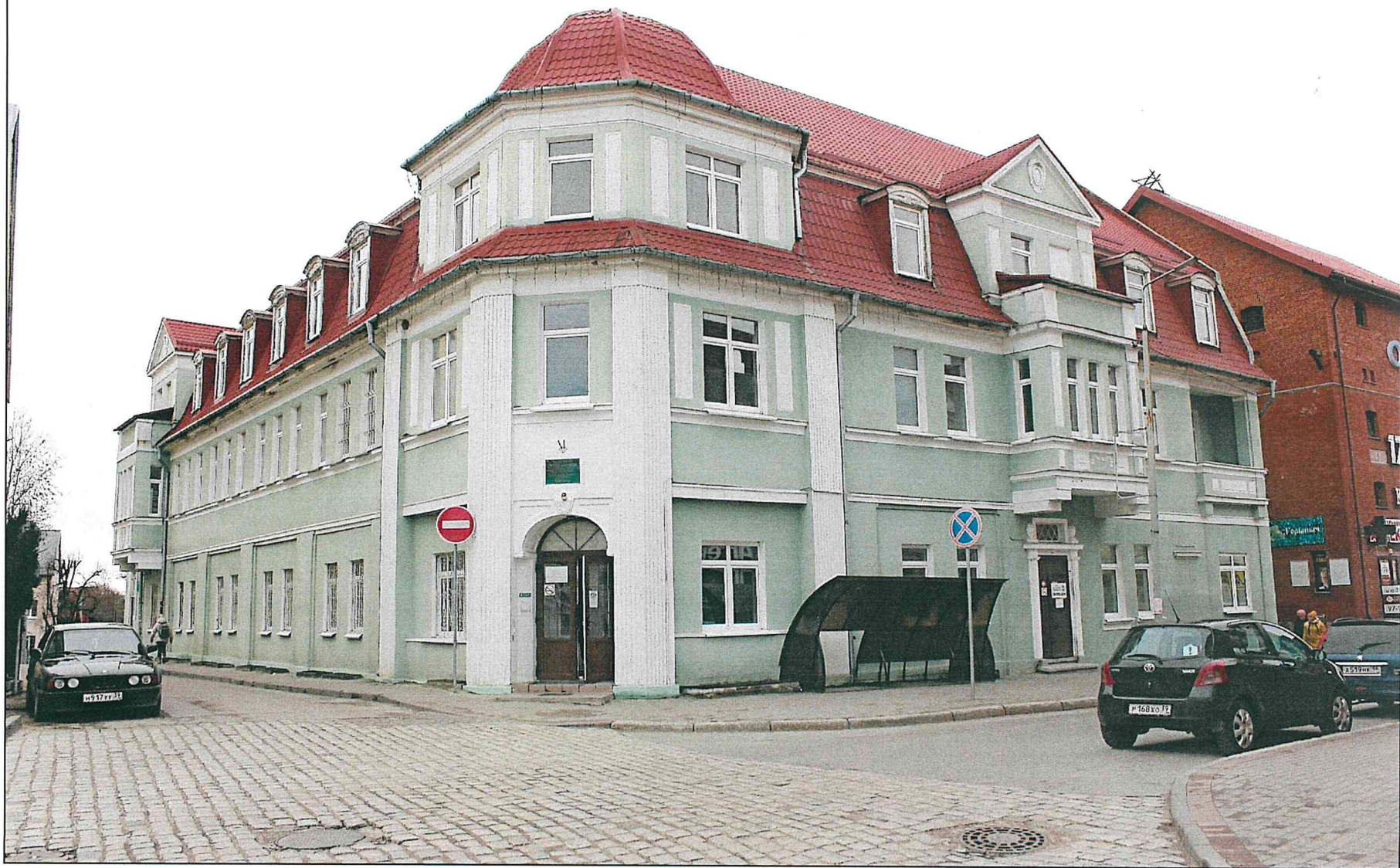
Фото 9. Общий вид. Фасад № 1, 2, 9.
