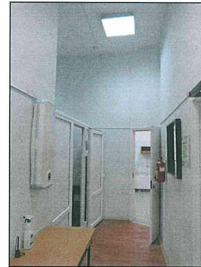
Фото 103. Первый этаж северной части объекта. Конструкции стен, перекрытий.
