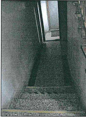
Фото 108. Первый этаж южной части объекта. Конструкции стен. Конструкции лестницы на первый этаж.
