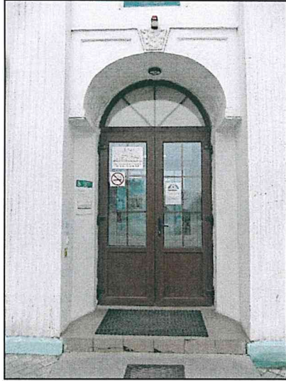
Фото 104. Первый этаж южной части объекта. Вход в здание.
