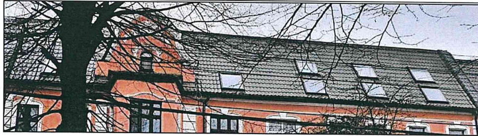
Фото 10. Восточный скат крыши.
