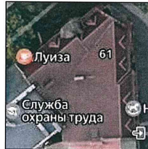
Фото 13. Крыша, вид сверху
