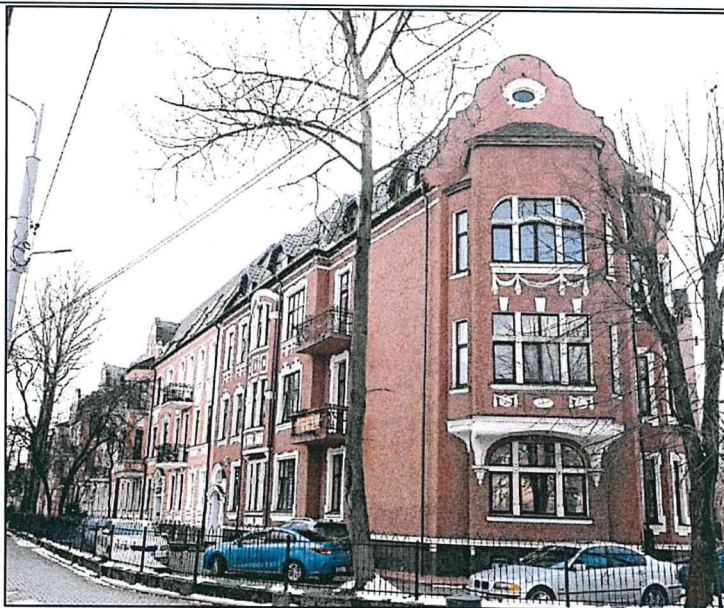
Фото 2. Вид с северо-востока, восточный и северный фасад Памятника.
