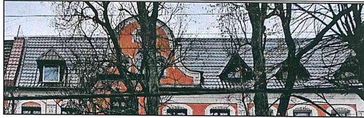
Фото 11. Восточный скат крыши.
