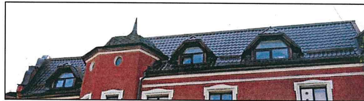
Фото 14. Крыша, северо-западный скат.
