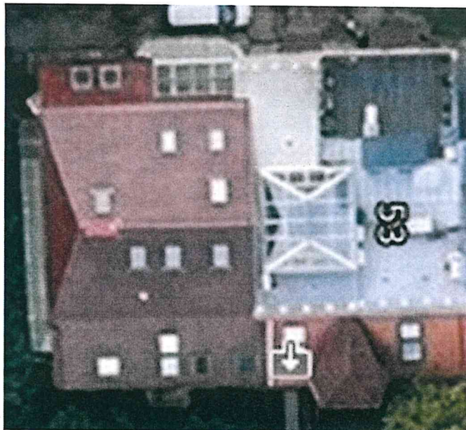
Фото 7. Крыша, вид сверху.
