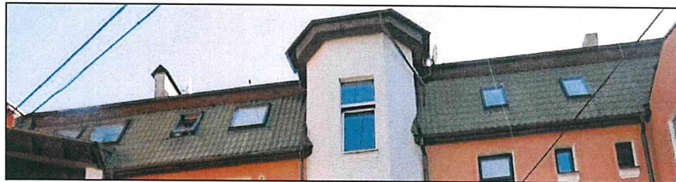
Фото 11. Западный скат крыши.
