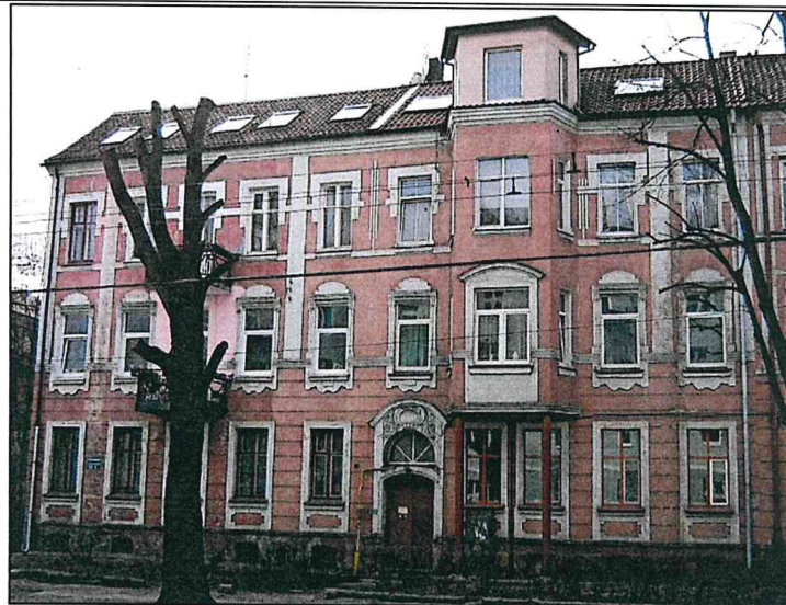
Фото 1. Вид с юго-востока, восточный фасад домов № 53
