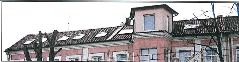
Фото 8. Крыша со стороны восточного фасада
