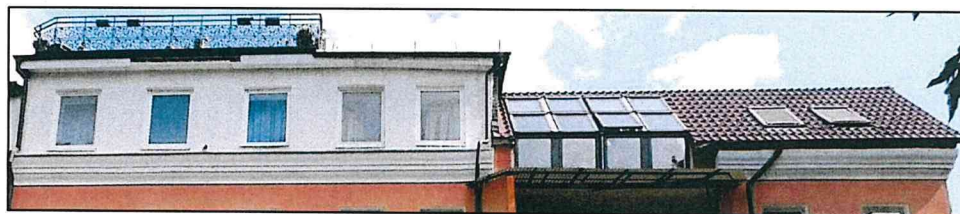
Фото 9. Крыша со стороны западного фасада
