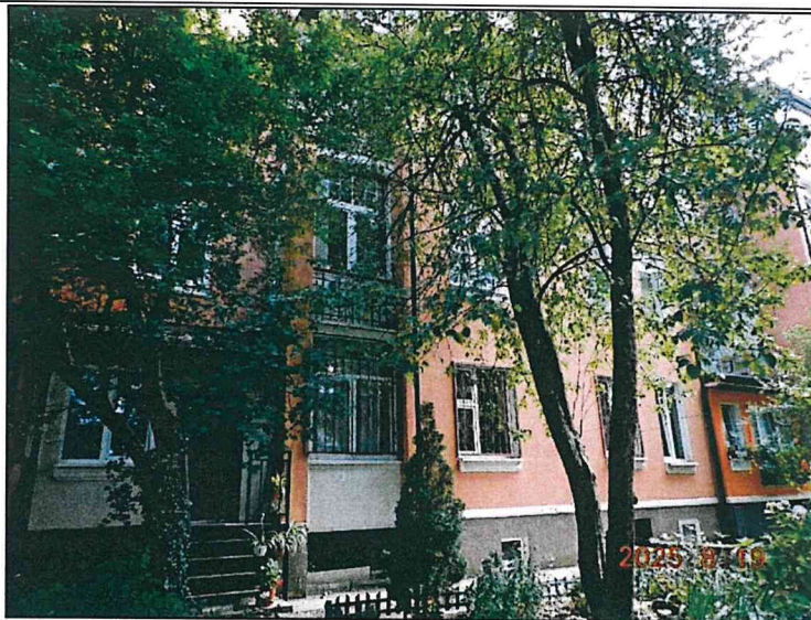
Фото 2. Вид с северо-запада, западный фасад дома 53а.
