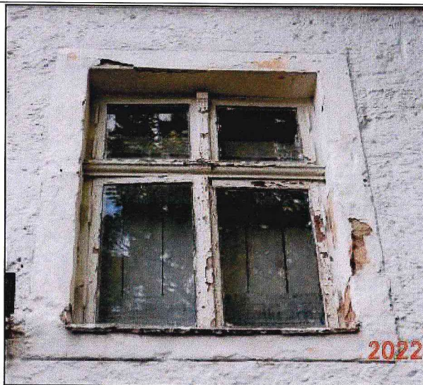
Фото 9. Заполнения двух центральных оконных проемов.
