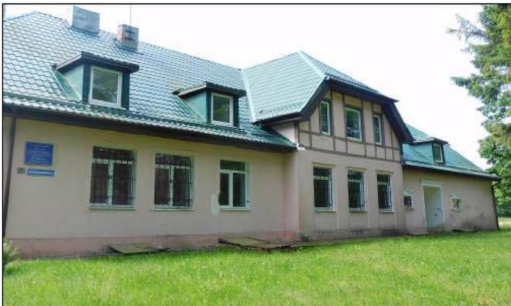
Фото 1. Вид с северо-востока. Северный главный фасад.
