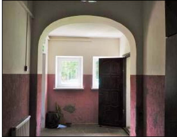
Фото 5. Проем с перемычкой в форме коробовой арки.
