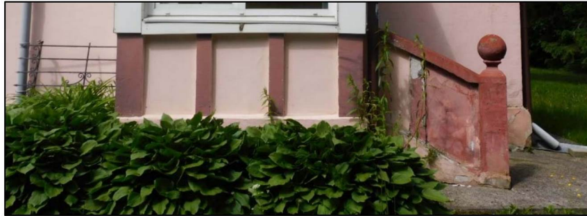
Фото б. Крыльцо. Вид с востока.
