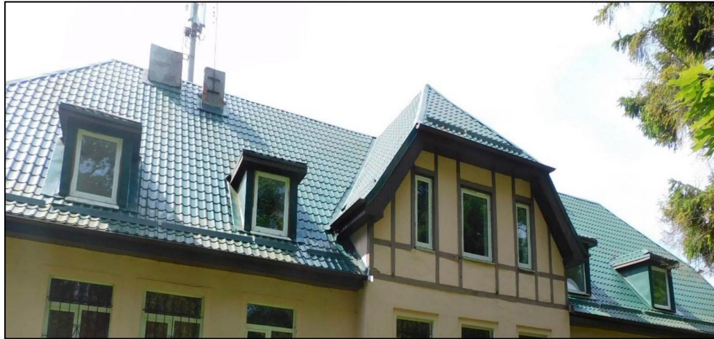
Фото 8. Северный скат крыши.
