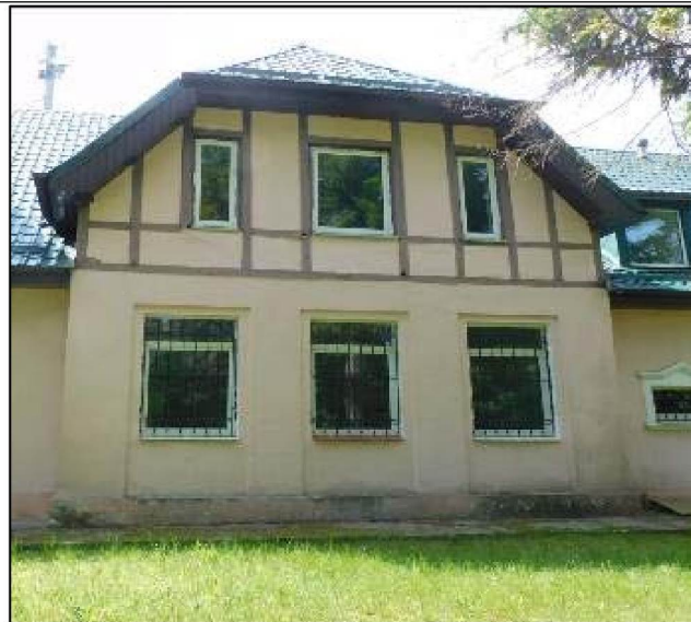
Фото 5. Оформление стены на северном главном фасаде.
