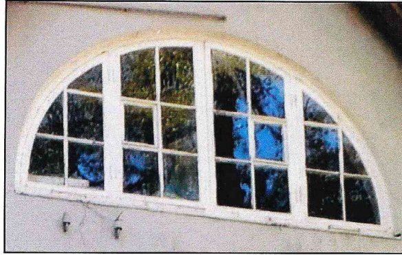
Фото 9. Оконный проем на северо-восточном фасаде.
