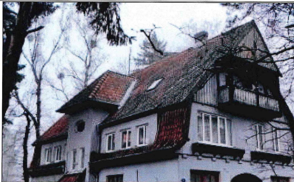
Фото 5. Вид с юга. Юго-западный скат крыши и юго-восточный фронтон.
