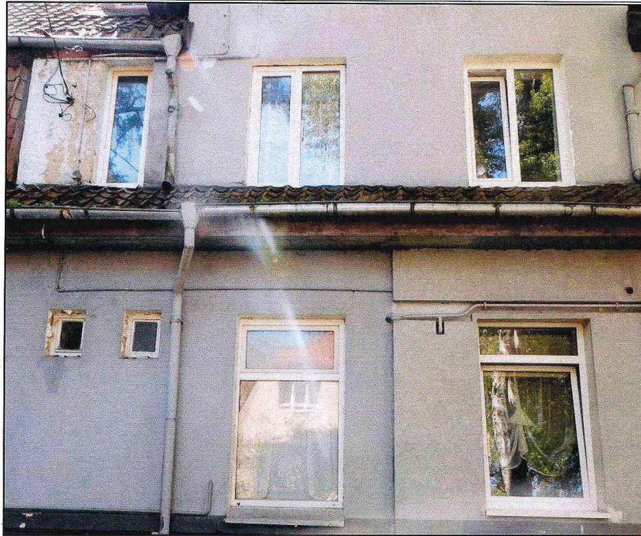
Фото 14. Вид оконных проемов в уровнях первого этажа и мансарды на северо-восточном фасаде.
