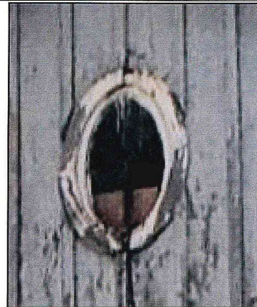
Фото 10. Оконные проемы чердака на юго-восточном и северо-западном фасадах.
