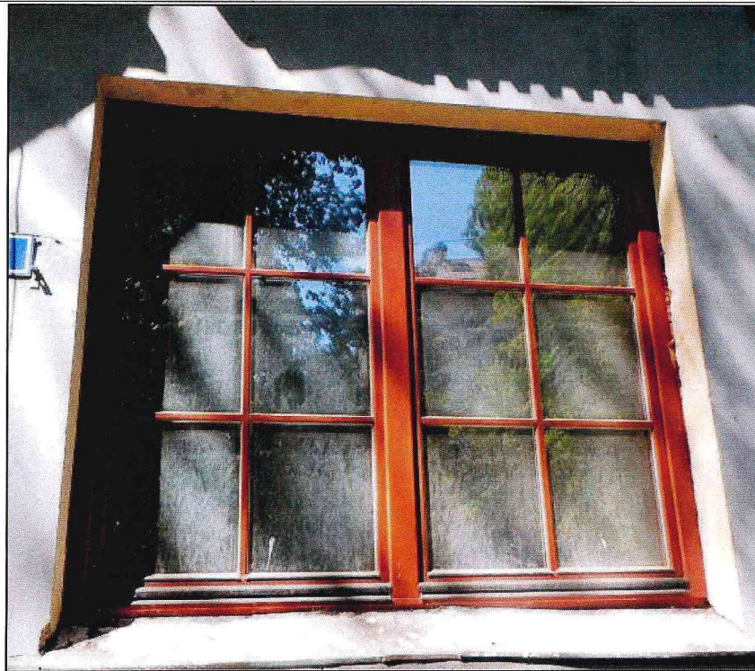
Фото 13. Оконные проемы в уровне первого этажа на юго-восточном фасаде.
