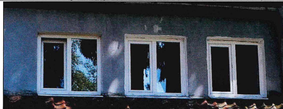
Фото 11. Оконные проемы на фронтовой стене мансарды на юго-западном фасаде.
