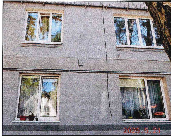
Фото 16. Вид оконных проемов в уровнях первого этажа и мансарды на северо-западном фасаде.
