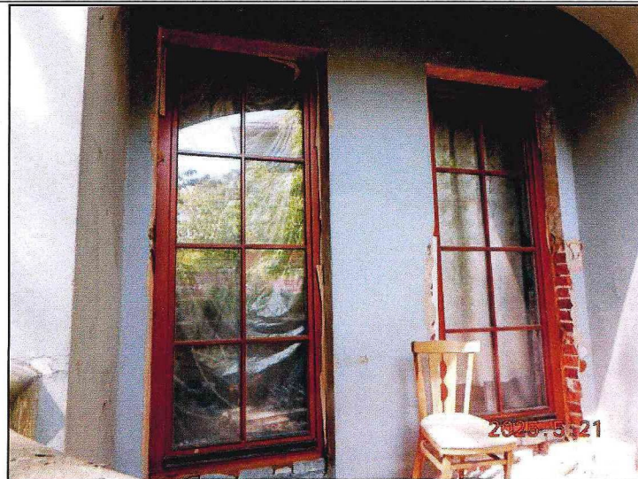
Фото 18. Вид дверного проема лоджии.
