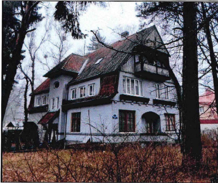
Фото 1. Общий вид на Памятник с юга. Юго-восточный и юго-западный фасады.
