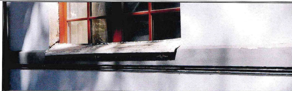
Фото 21. Вид межэтажного карниза.
