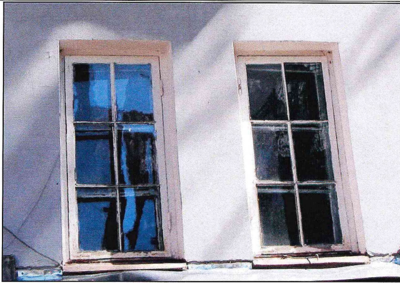
Фото 7. Оконные проемы лестничной клетки.
