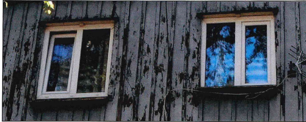
Фото 12. Оконные проемы в уровне чердака на северо-западном фасаде.
