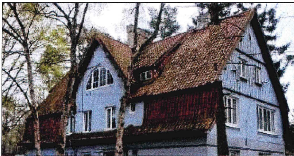
Фото 6. Северо-восточный скат крыши и северо-западный щипец.
