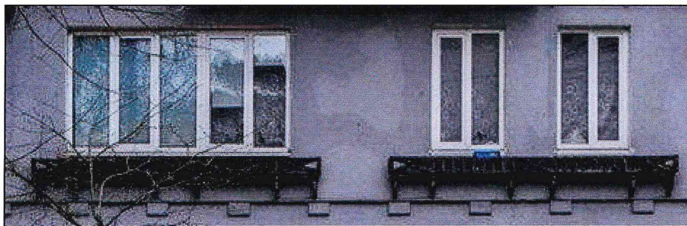
Фото 15. Вид оконных проемов в уровне мансарды на юго-восточном фасаде.
