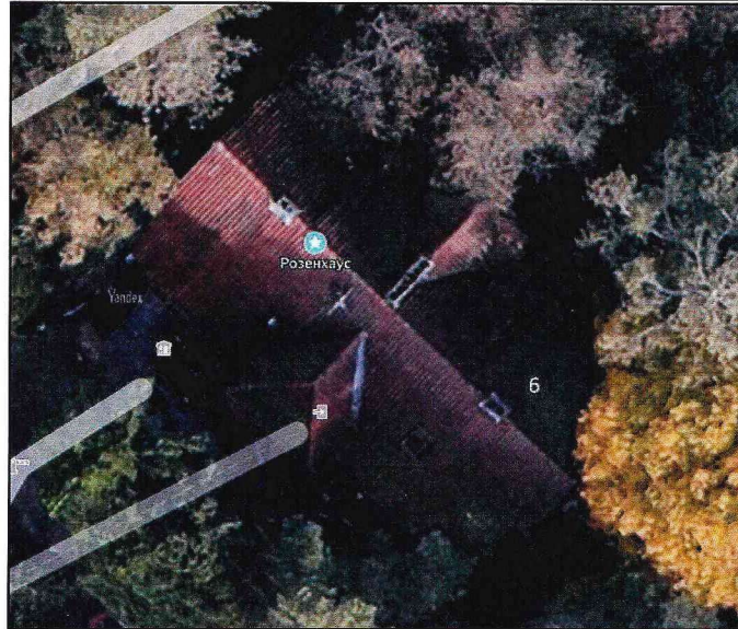
Фото 4. Вид крыши сверху.
