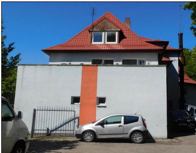
Фото 7. Восточный объем. Восточный фасад. Пристройка №1. Вид с востока.
