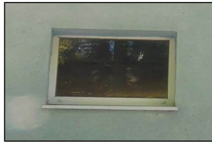
Фото 5. Оконные проемы на северном дворовом фасаде восточного объема в уровне подвала, первого, второго этажей.
