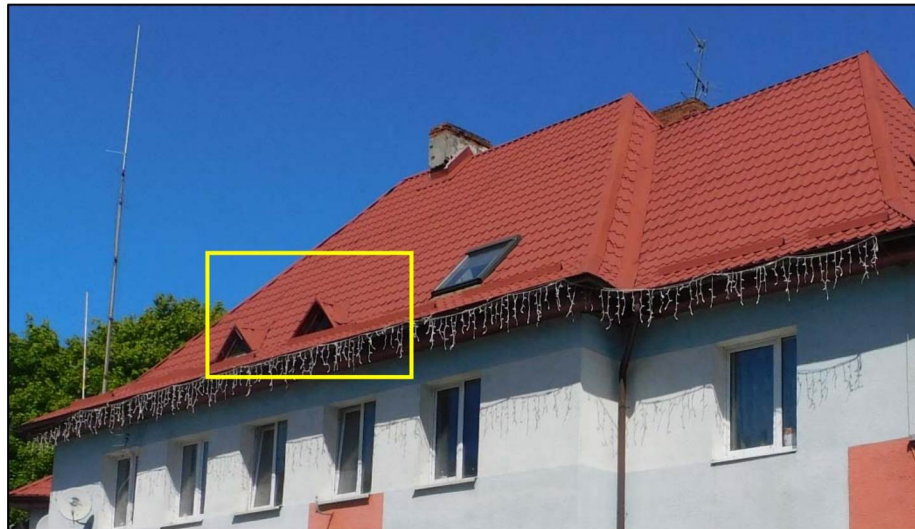
Фото 9. Восточный объем. Южный скат крыши.
