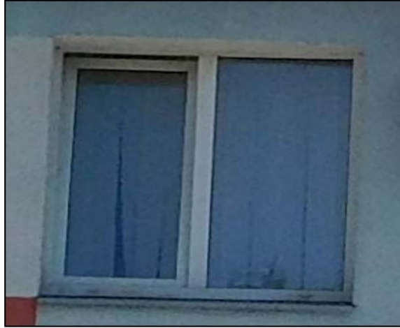
Фото 3. Оконные проемы на фасадах здания в уровне первого, второго этажей и мансарды.
