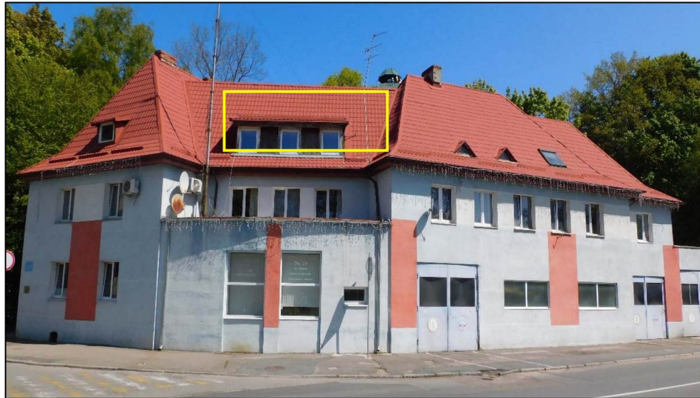
Фото 11. Юго-западный скат крыши.
