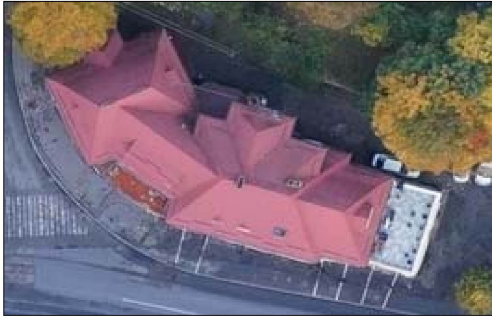
Фото 8. Крыша. Вид сверху.
