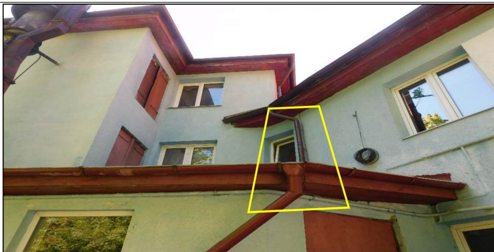
Фото 5. Промежуточный объем. Северный дворовой фасад. Вид с севера.
