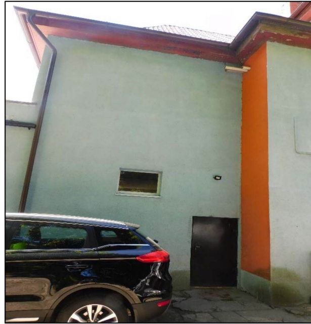
Фото 8. Восточный объем. Северный дворовой фасад. Восточная часть фасада.
