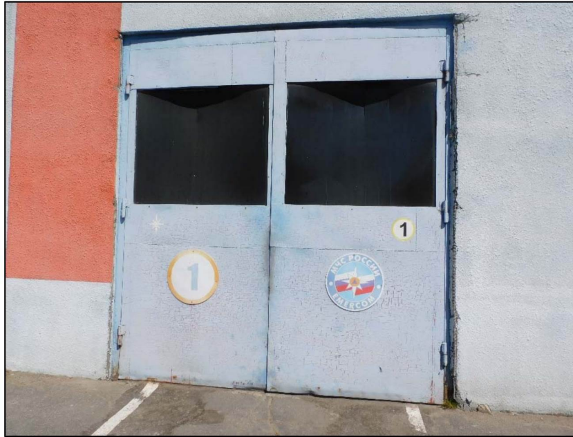
Фото 6. Дверной проем в бокс для пожарных машин.
