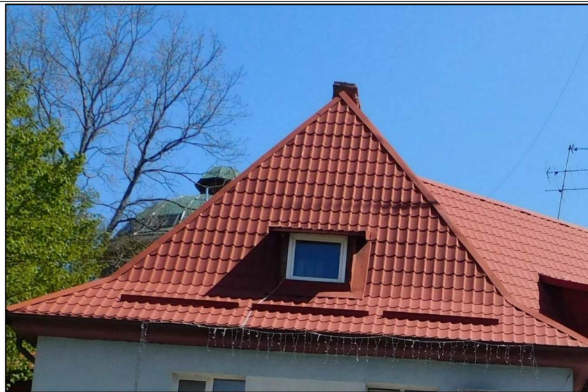
Фото 13. Западный объем. Западный скат крыши.
