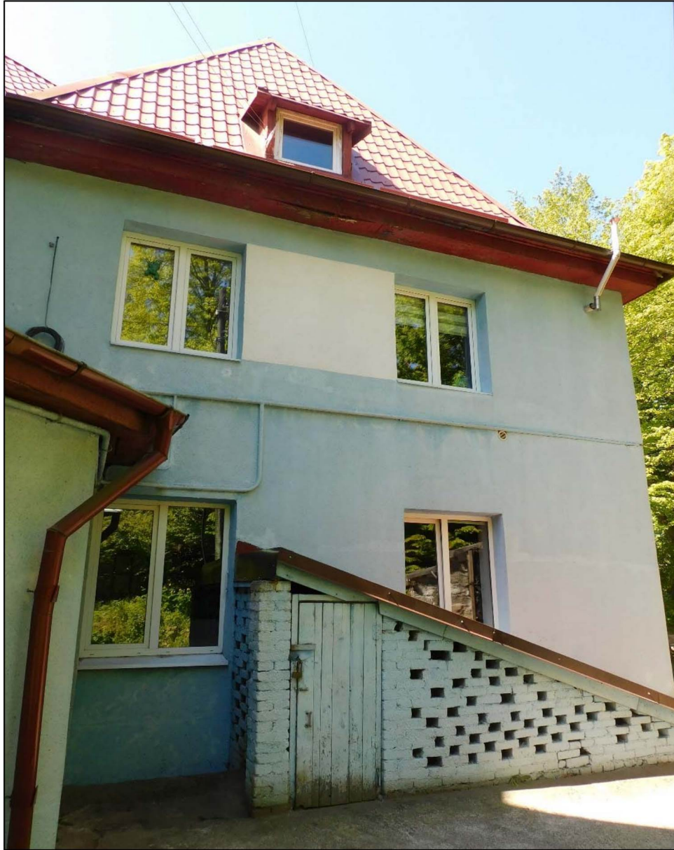
Фото 3. Западный объем. Северо-восточный фасад. Вид с северо-востока.
