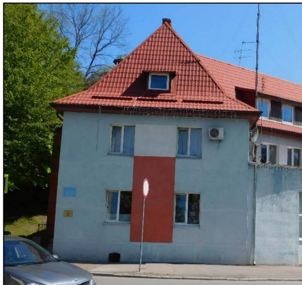
Фото 1. Западный объем. Юго-западный главный фасад. Вид с юго-запада.
