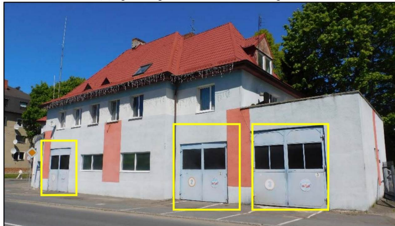
Фото 7. Дверные проемы в боксы для пожарных машин.
