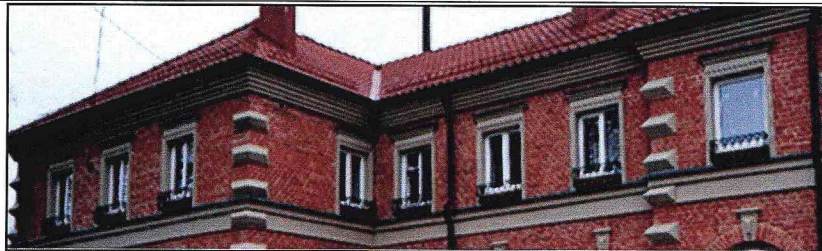
Западный фасад (Оконные проемы второго этажа)
