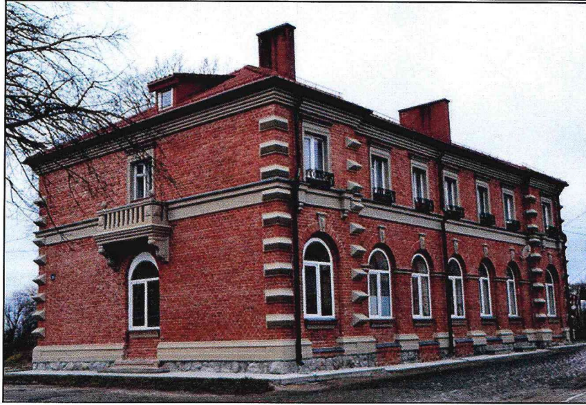
3. Восточный уличный фасад (с ул. Первомайской): Насчитывается 7 световых осей. На северном и южном углу выполнены вертикальные раскреповки
