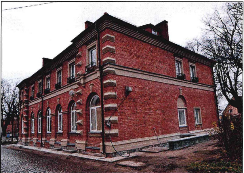
4. Северный фасад: Насчитывается 2 световые оси в западной части фасада. В восточной части фасада на первом этаже имеется подпружная арка. Ближе к центру фасада имеется вход в подвал.
