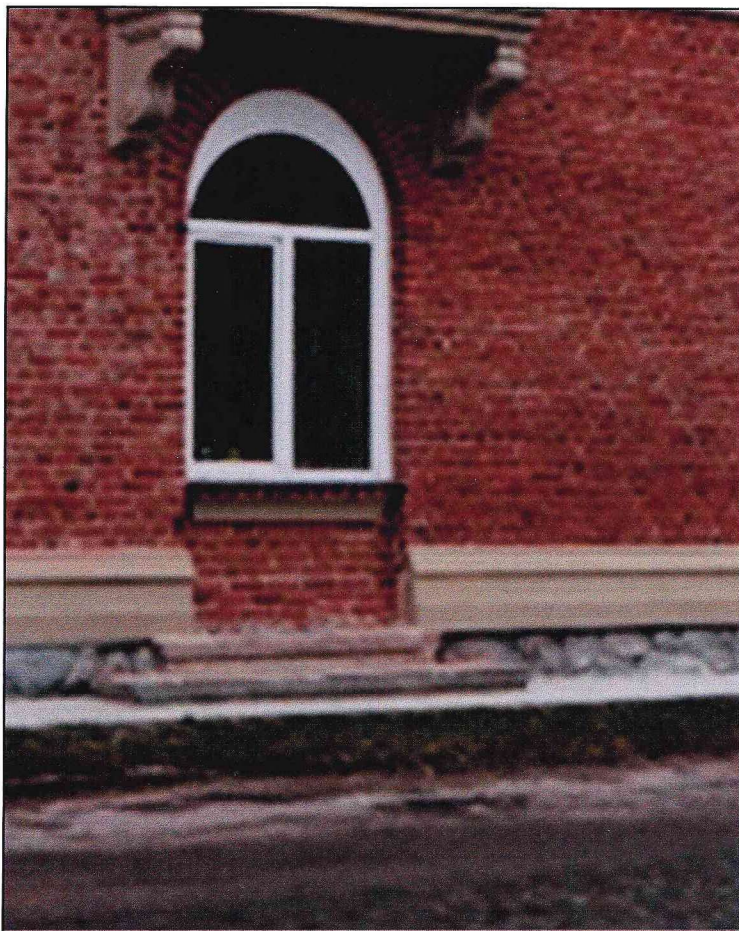
Оконный проем на первом этаже южного фасада
