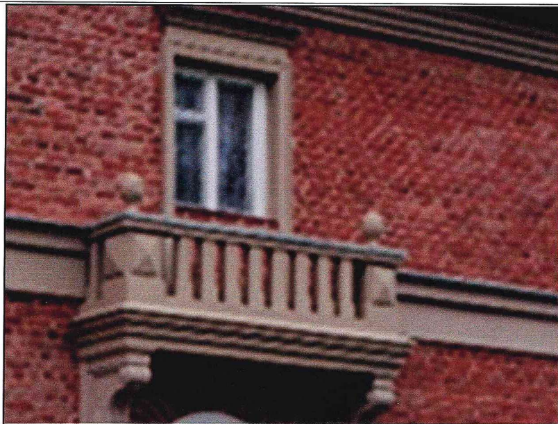
Оконный проем на втором этаже южного фасада
