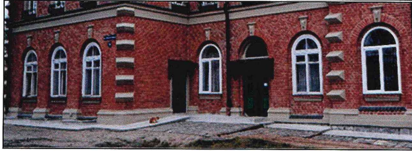
Западный фасад (Оконные проемы первого этажа)
