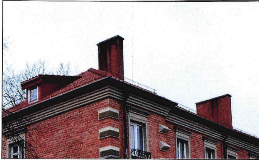
Южный и восточный скаты крыши.
