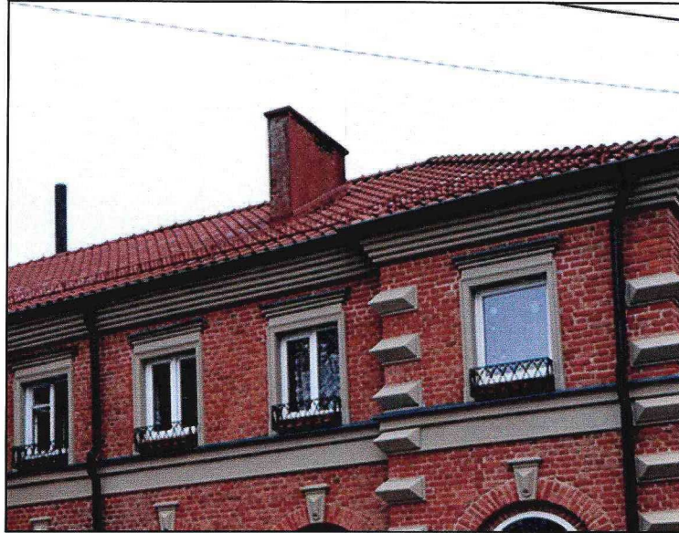
Западный скат крыши
