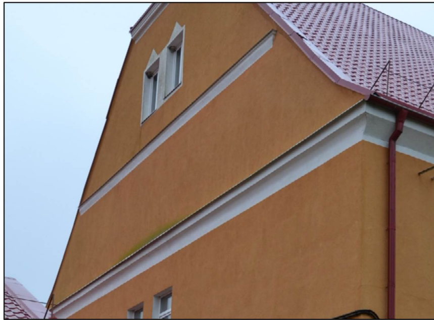
Карнизы на северо-восточном (боковом) фасаде
