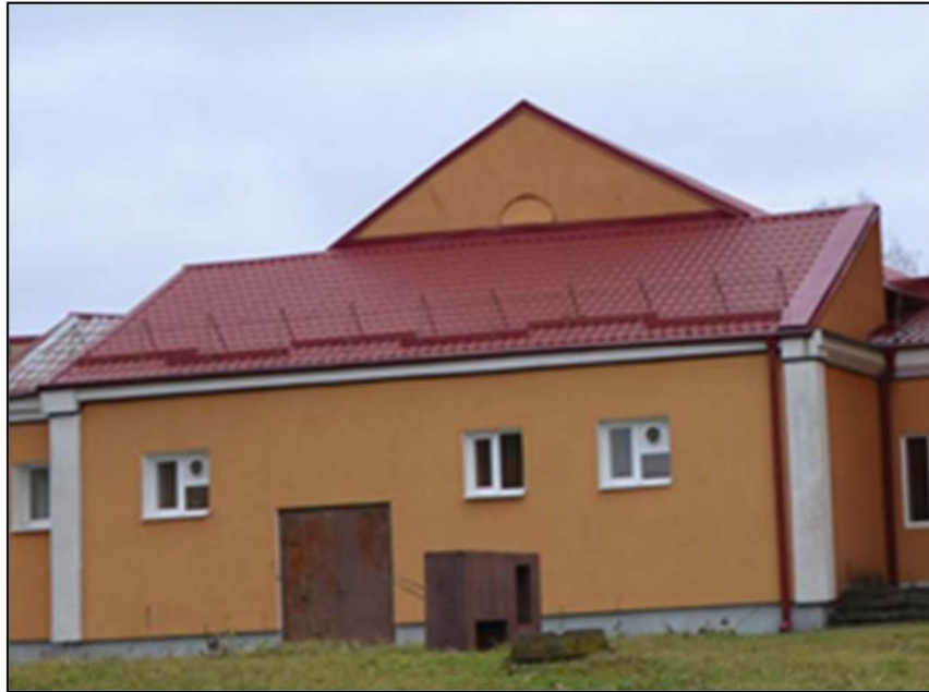
Дворовой (северо-западный фасад (закрыт современной пристройкой))
