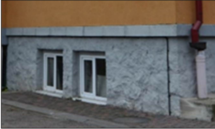
Оконные проемы цоколя юго-западного фасада
