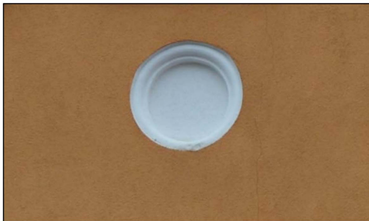
Круглая ниша фальшокна на главном фасаде
