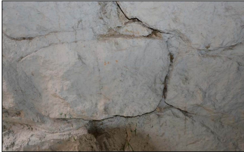
Элементы валунной кладки цоколя
