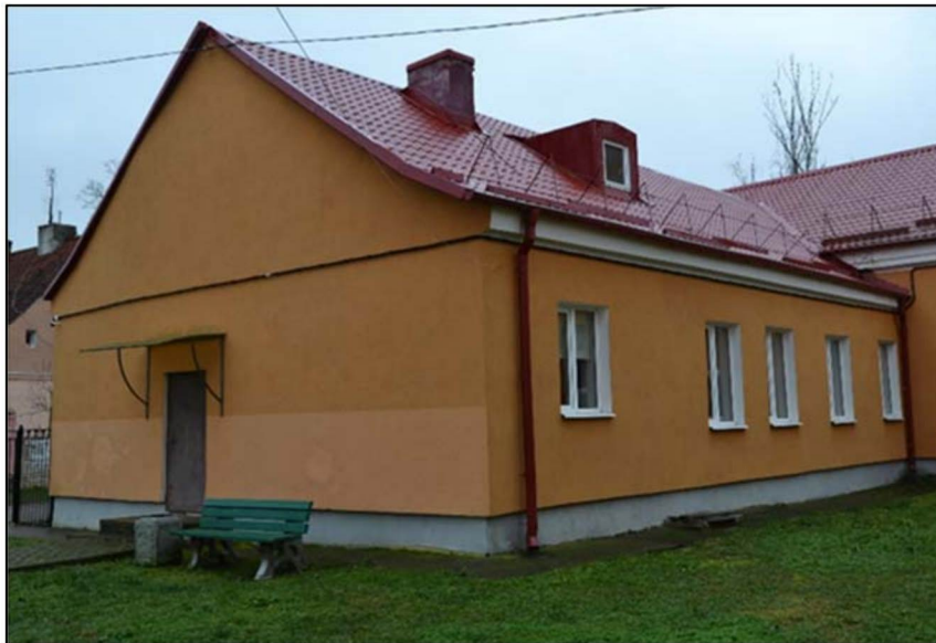
Скат крыши со стороны дворового (юго-западного) фасада
