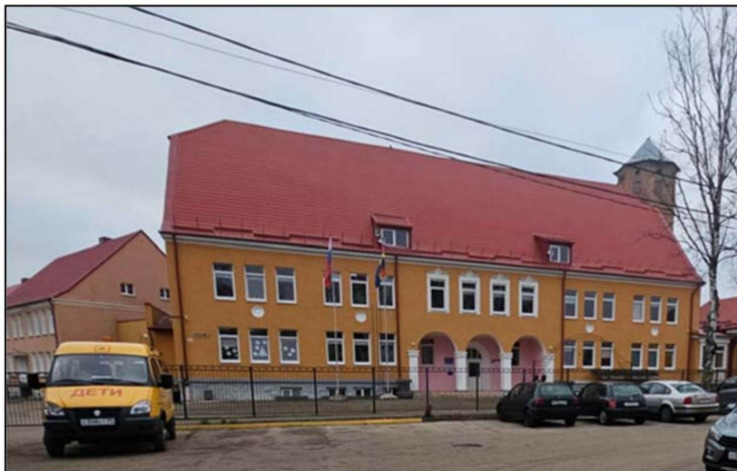
Главный (юго-восточный) фасад
