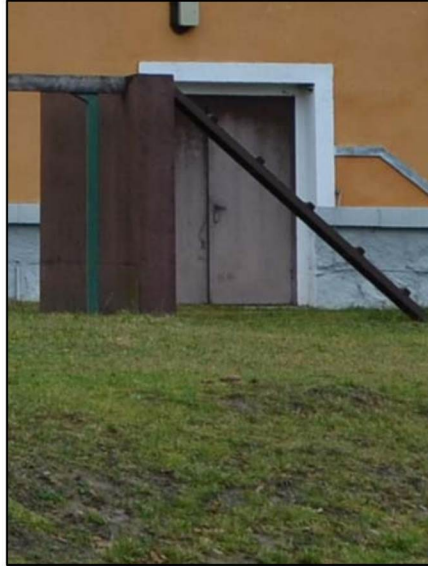
Дверной проем северо-западного (дворового) фасада
