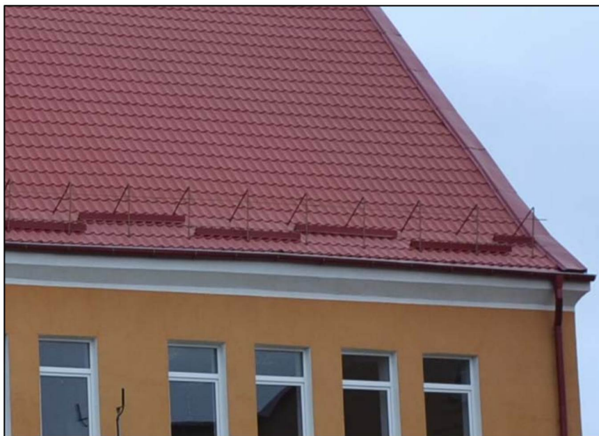
Венчающий карниз дворового фасада
