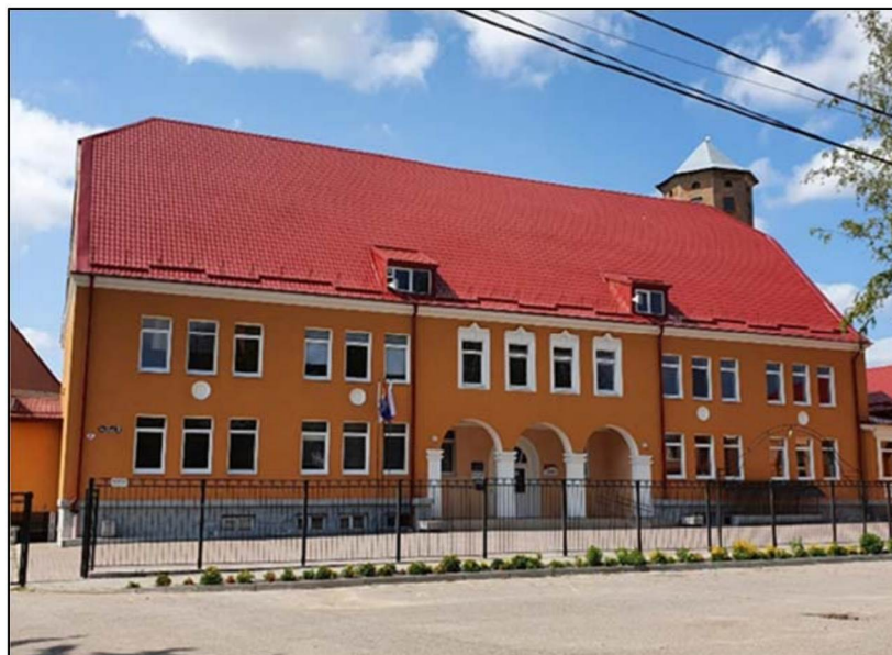
Главный (юго-восточный) фасад
