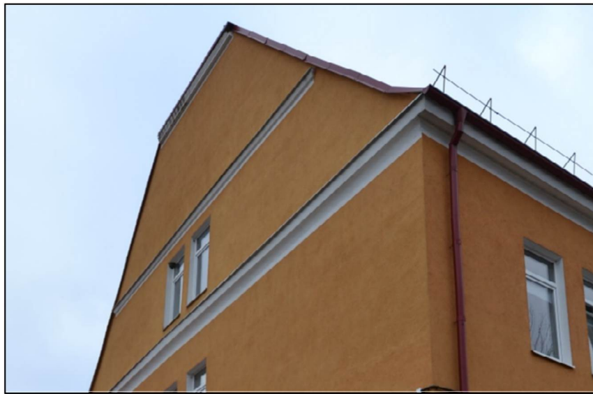
Два межэтажных карниза юго-западного (бокового) фасада
