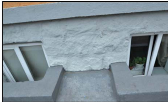
Приямки с бордюрами окон цокольного этажа главного (юго-восточного) фасада
