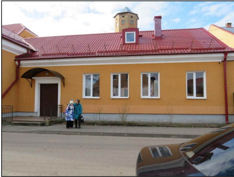
Вид на главный (юго-восточный) фасад
