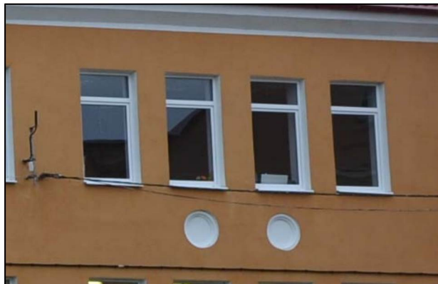
Оконные проемы 2-го этажа северо-западного (дворового) фасада
