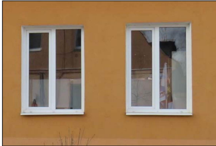
Оконные проемы главного фасада
