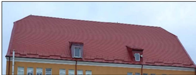
Крыша со стороны северо-западного фасада
