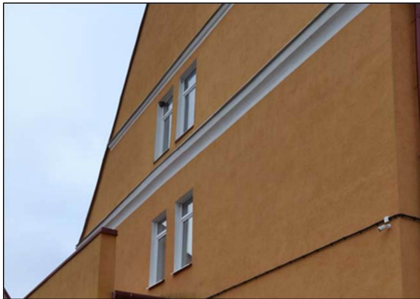
Оконные проемы второго и мансардного этажей юго-западного фасада
