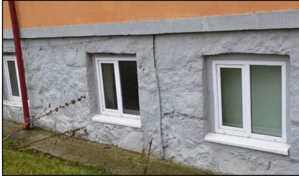
Оконные проемы цоколя северо-западного (дворового) фасада
