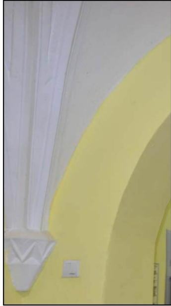
Пята нервюр свода потолка первого этажа
