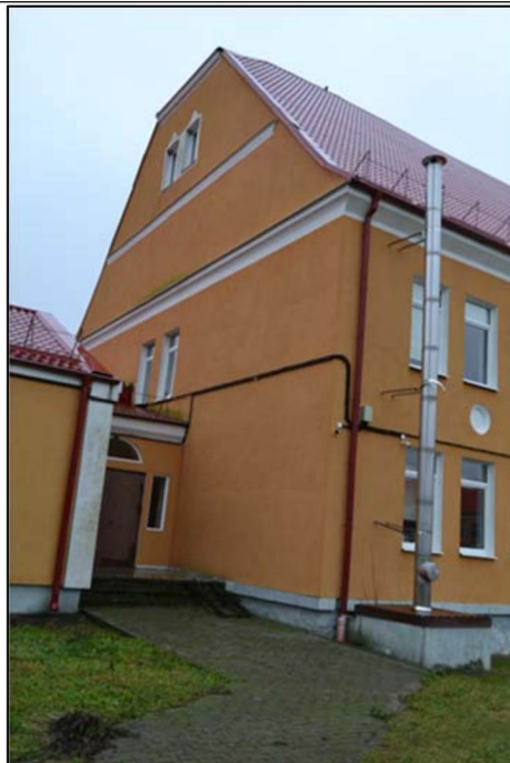
Боковой (северо-восточный) фасад
