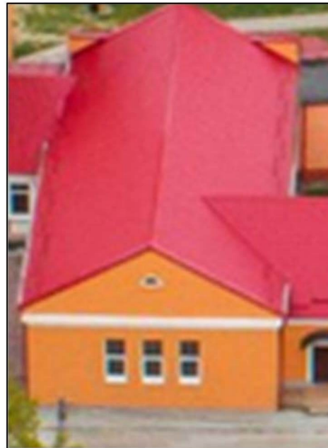
Фрагмент аэрофотосъемки (здание спортивного зала)
