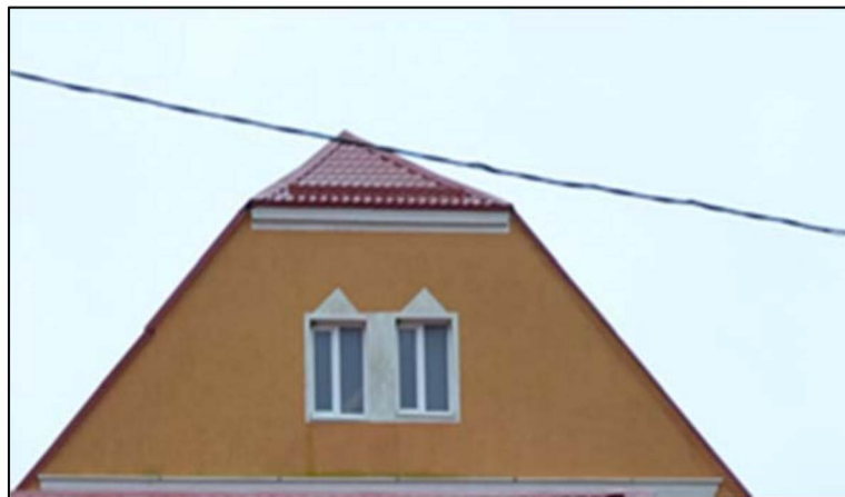
Полувальма крыши со стороны северо-восточного фасада
