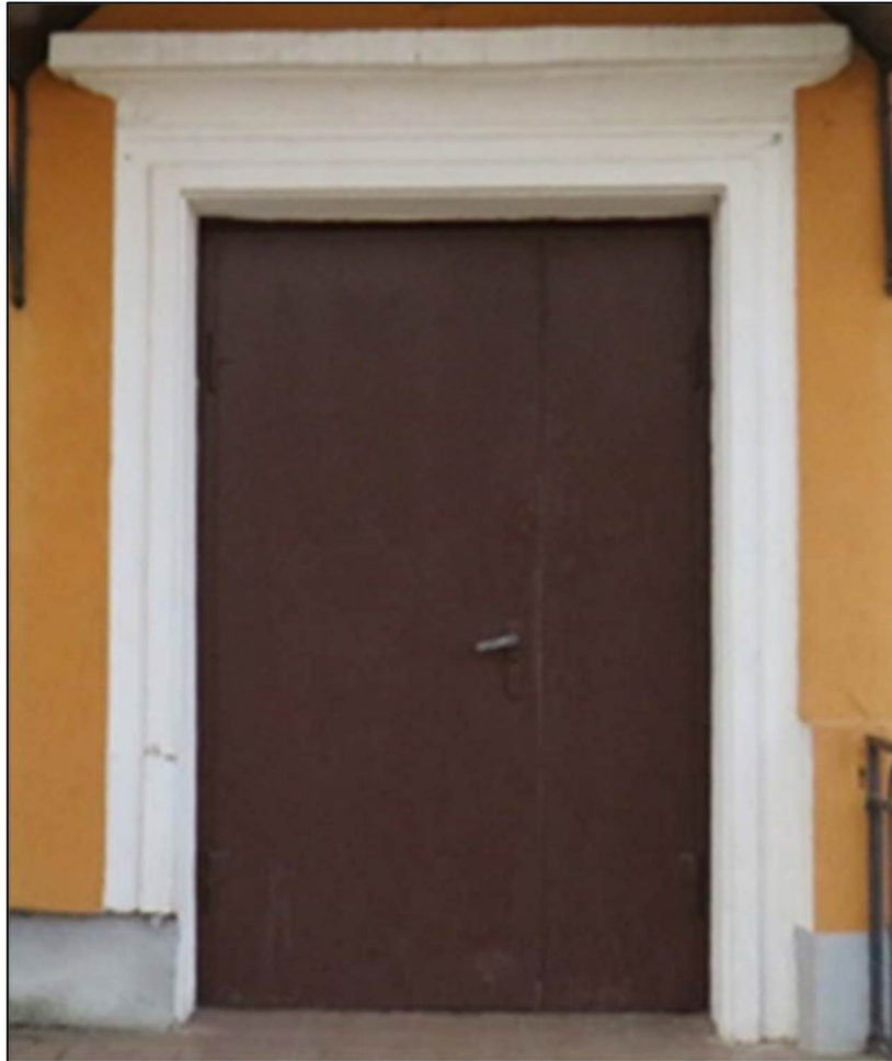
Наличники и сандрик дверного проема на главном фасаде
