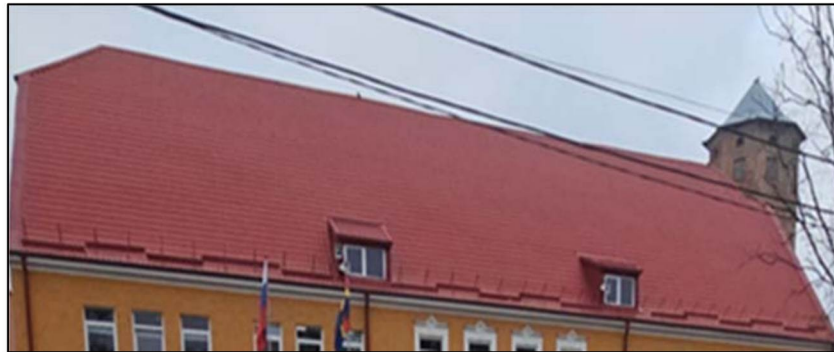
Крыша со стороны юго-восточного фасада
