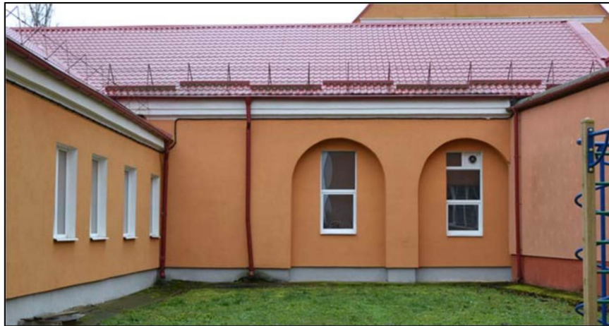
Боковой (северо-восточный) фасад
