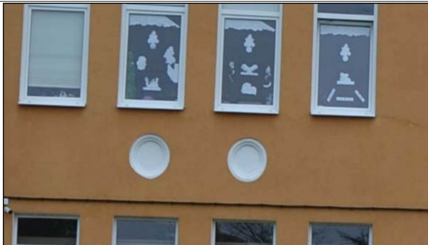
Круглые ниши фальшокон на дворовом фасаде
