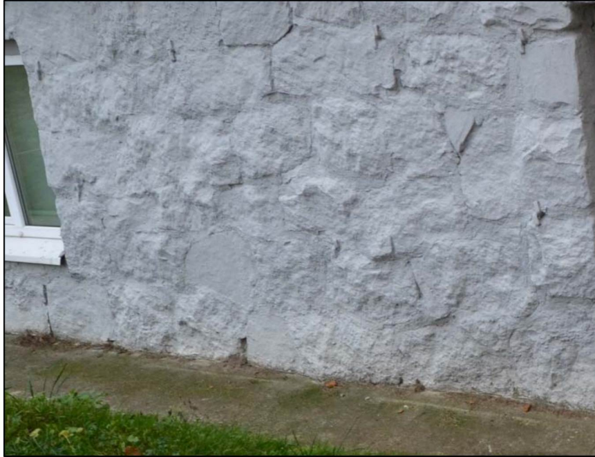
Элементы валунной кладки цоколя
