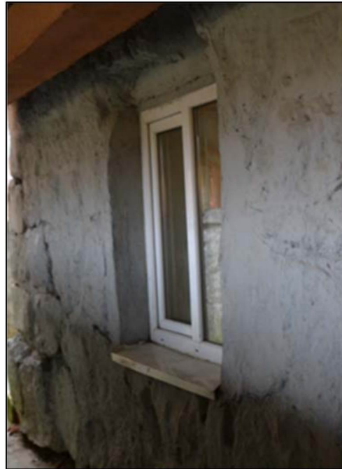
Оконные проемы цоколя юго-западного фасада (под пристройкой)
