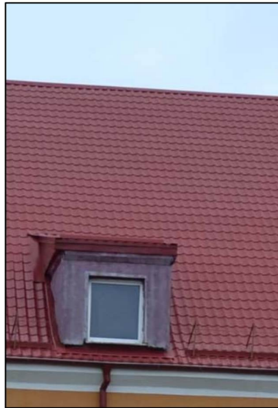
Оконный проем мансардного этажа северо-западного (дворового) фасада
