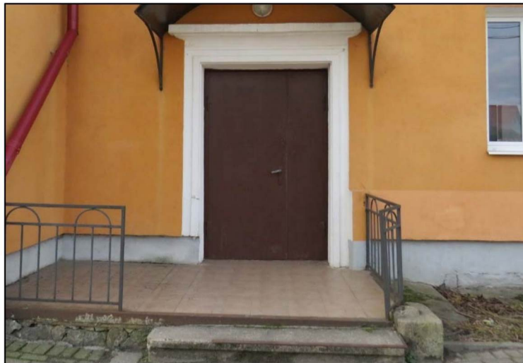
Дверной проем главного фасада
