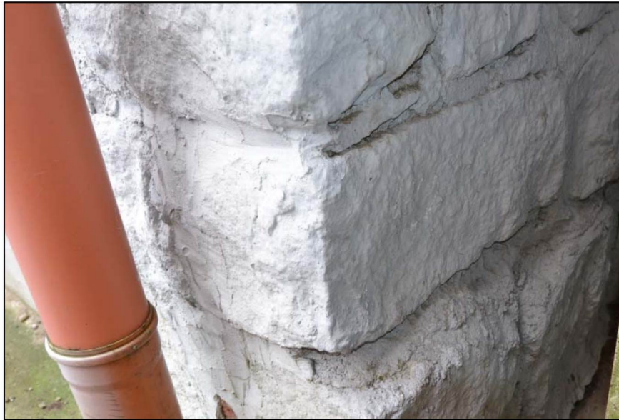
Элементы валунной кладки цоколя
