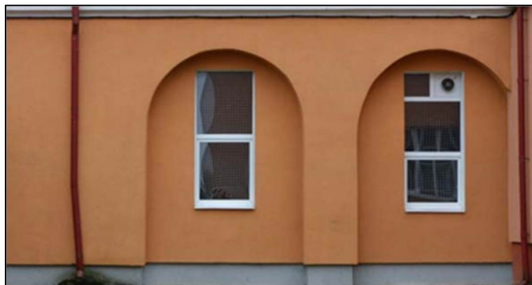
Два оконных проема северо-восточного (бокового) фасада
