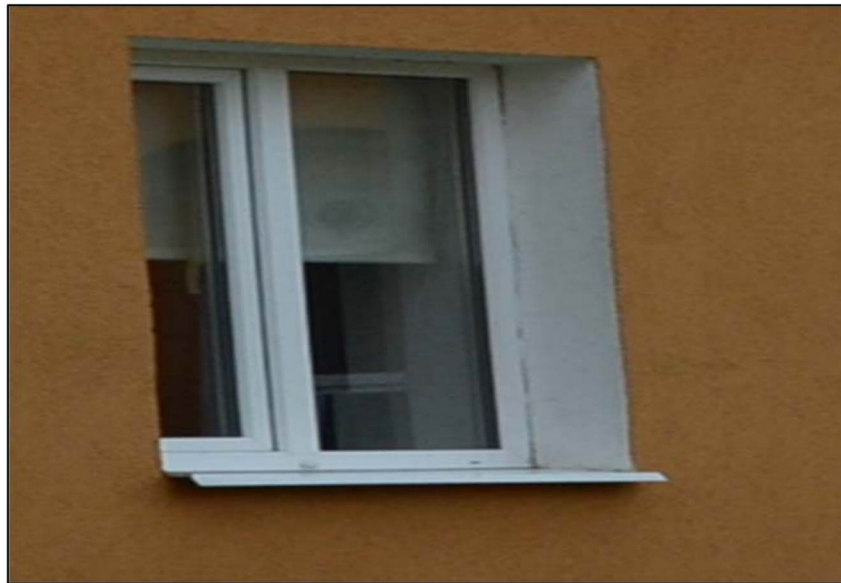
Оконный проем на дворовом фасаде
