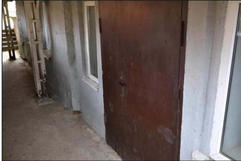
Оконные и дверной проемы цоколя юго-западного фасада (под пристройкой)
