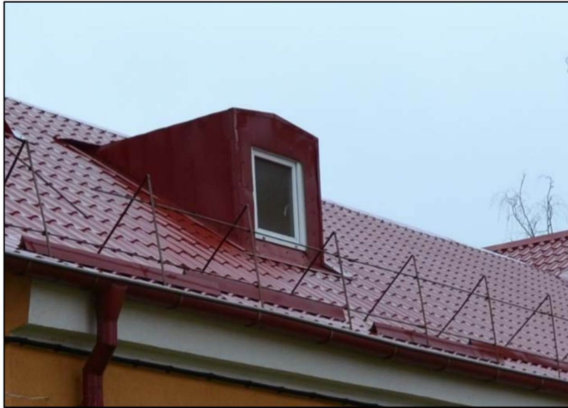
Оконный проем слухового окна на северо-западном скате крыши
