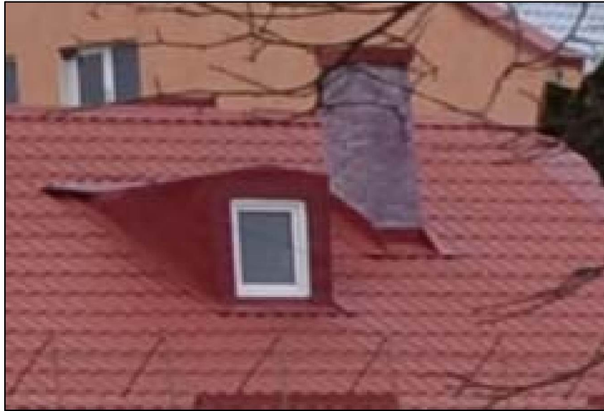
Оконный проем слухового окна на юго-восточном скате крыши
