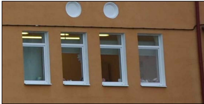
Оконные проемы 1-го этажа северо-западного (дворового) фасада
