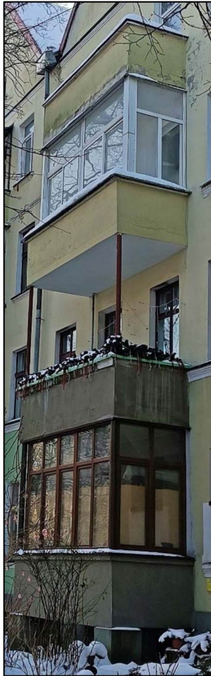
Фото 13. Общий вид балконов на восточном главном фасаде.
