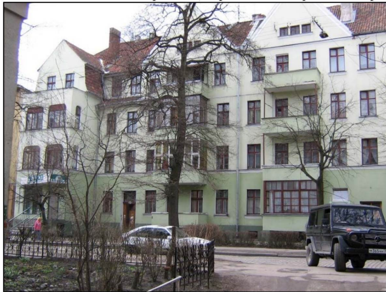
Фото 6. Восточный главный фасад . Центральная и южная части фасада.
