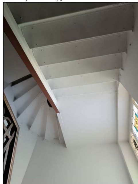
Фото 4. Вид металлоконструкции лестничных маршей.
