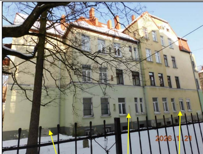
Фото 7. Южный боковой фасад, вид с юга.
