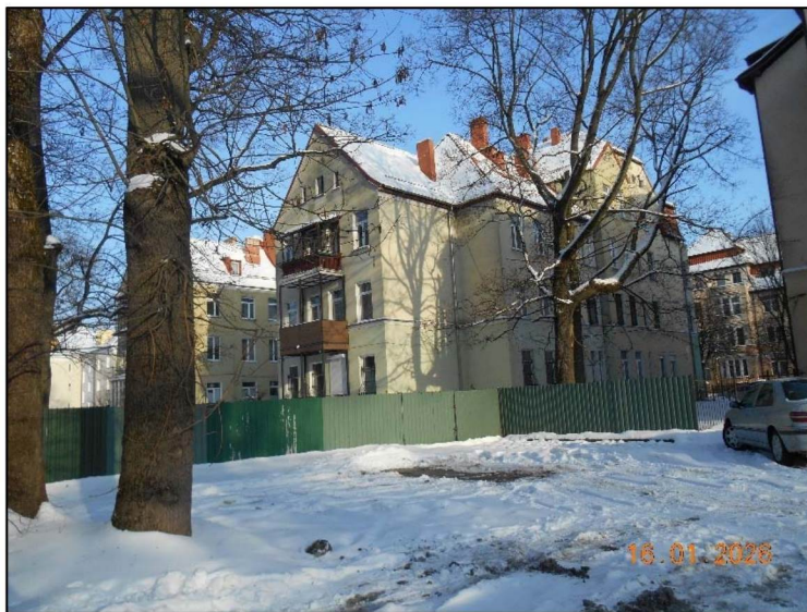
Фото 2. Вид с юго-запада. Южный боковой и западный дворовый фасады.
