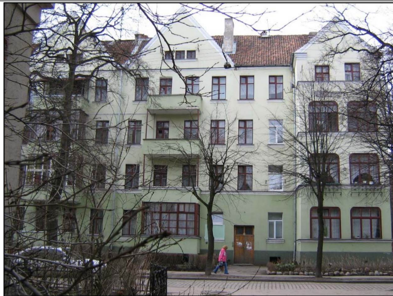
Фото 5. Восточный главный фасад. Центральная и северная части фасада.
