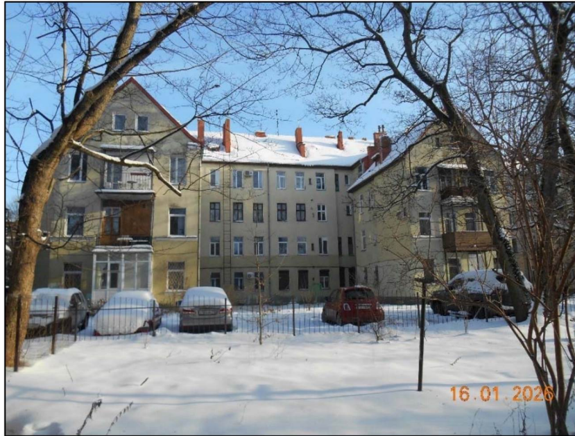
Фото 9. Западный дворовый фасад Памятника.
