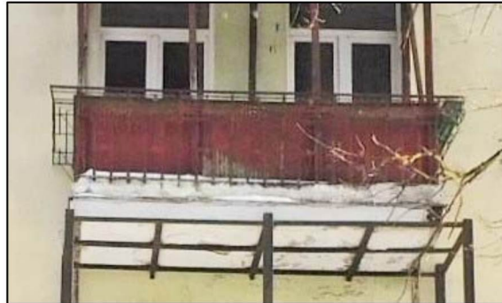
Фото 14. Вид ограждения площадки балкона на западном дворовом фасаде.
