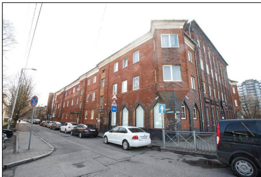
Фото 8. Фасад № 2. Вид с северо-востока.
