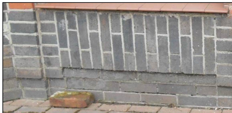
Фото 3. Вид цоколей фасада № 1.
