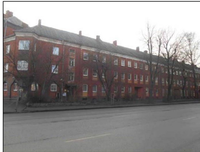
Фото 10. Фасад № 3. Вид с северо-запада.
