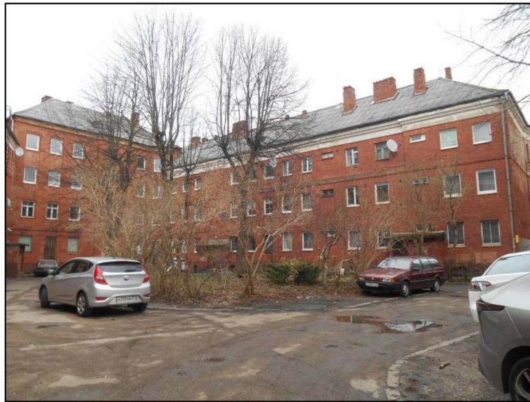
Фото 22. Фасады № 7, № 8. Вид с юго-запада.
