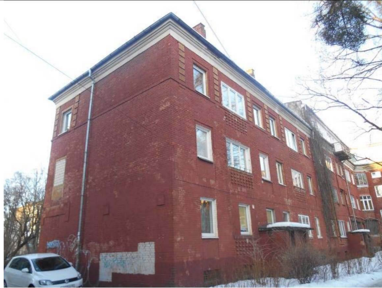
Фото 17. Фасад № 5, фасад № 10. Вид с востока.
