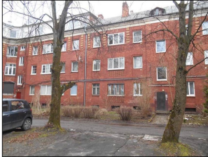
Фото 21. Фрагмент южной части фасада. Южный внутренний угол
