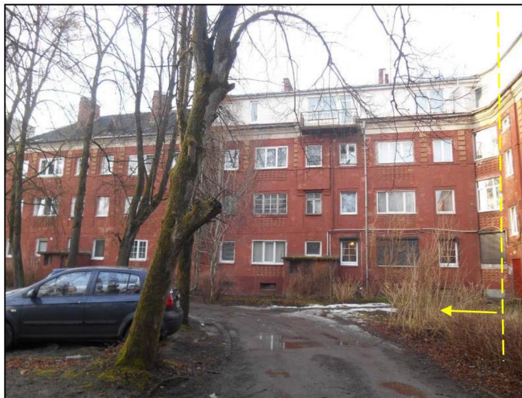
Фото 16. Фасад № 5. Вид с северо-востока.
