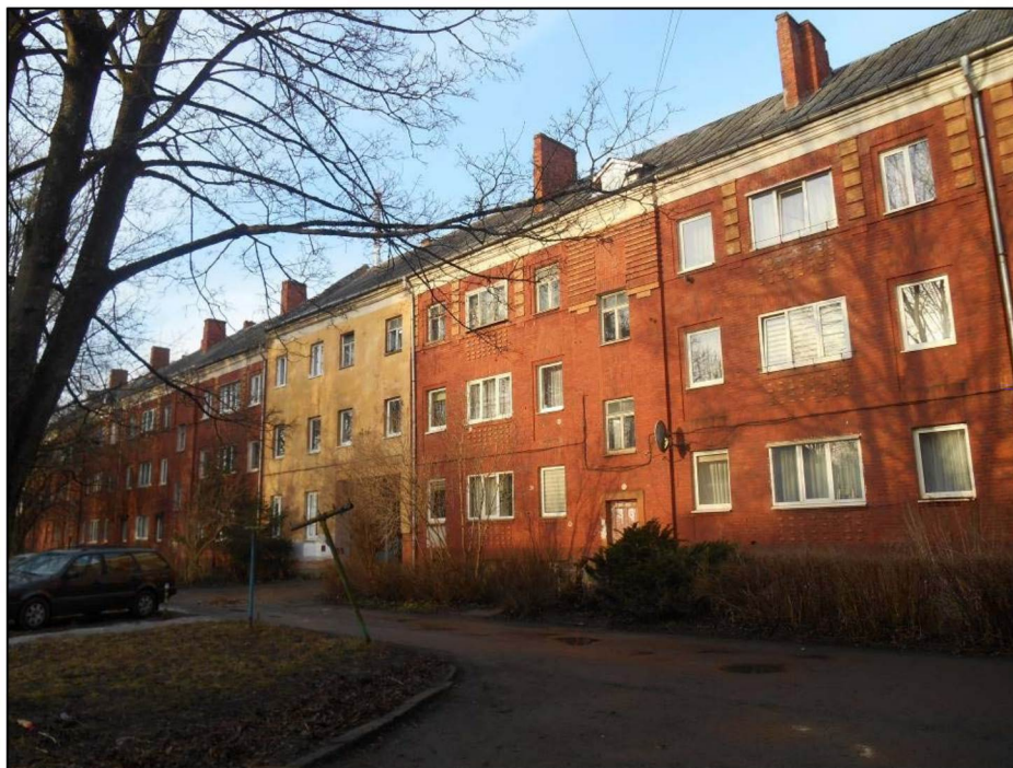
Фото 20. Фасад № 6, фрагмент центральной части фасада со сквозным проездом.
