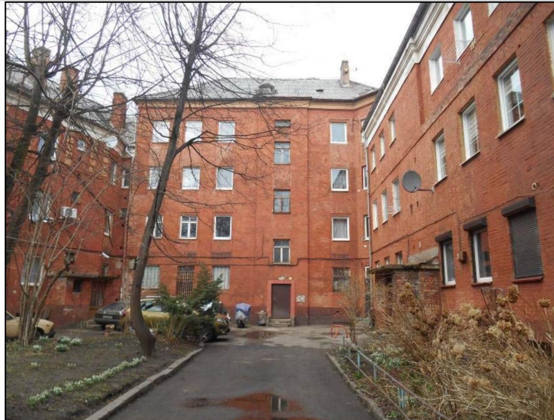
Фото 18. Общий вид с юга. Фасад № 7, фрагменты фасадов № 6, № 8.
