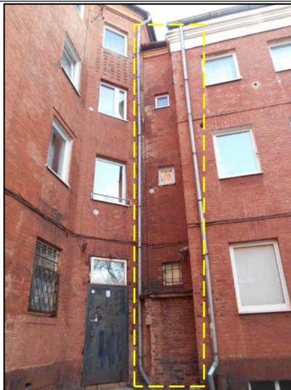
Фото 25. Фасад № 8. Фасад № 8. Фрагмент северной части фасада № 8,внутренний северный угол.
