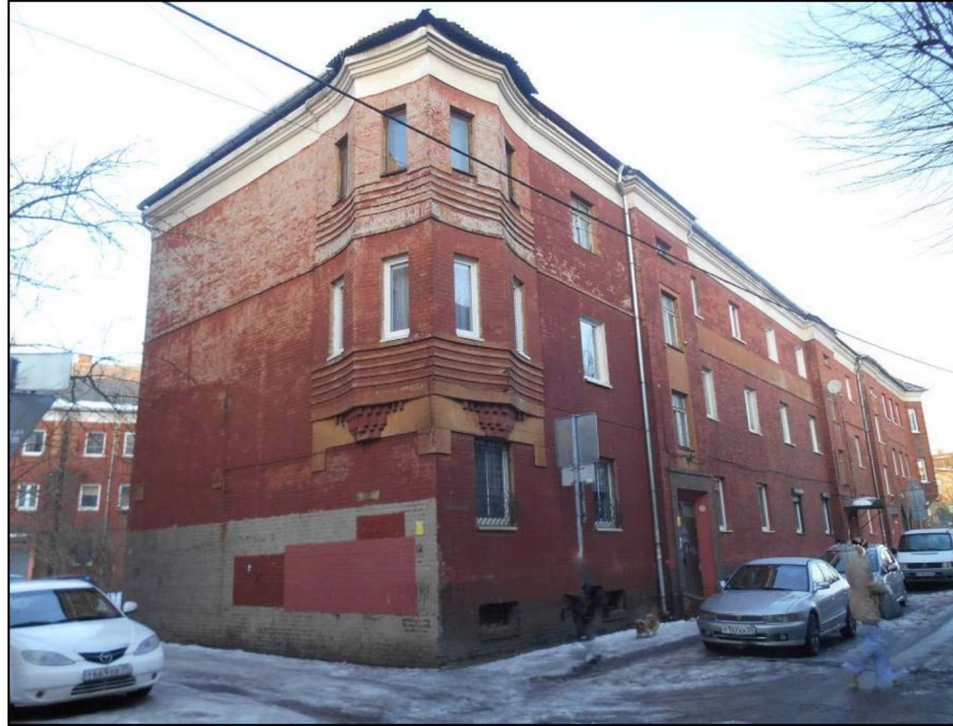
Фото 9. Фасад № 2. Вид с юго-востока.
