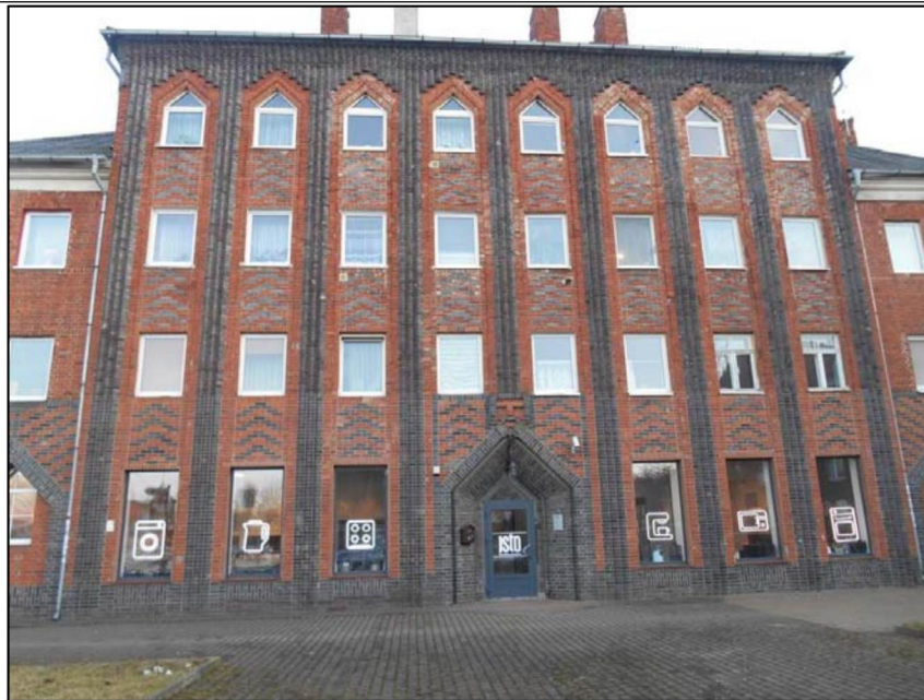
Фото 4. Общий вид настенного декора центральной части фасада № 1.
