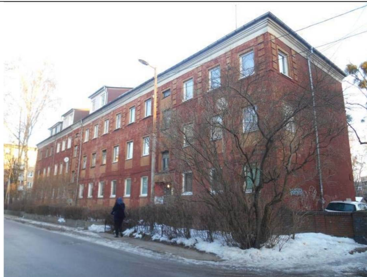
Фото 15. Фасад № 4. Вид с юго-востока.
