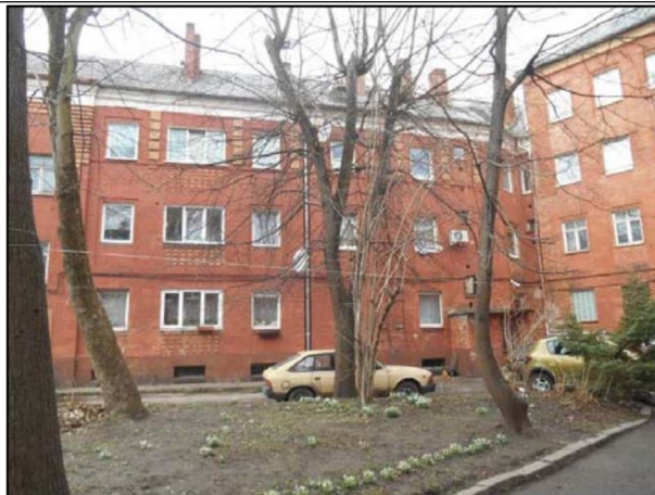
Фото 19. Фасад № 6, фрагмент северной части фасада, северный внутренний угол.
