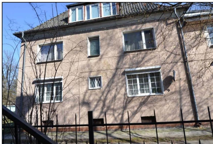
Фото 4. Юго-западный боковой фасад.
