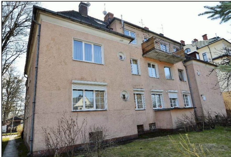
Фото 2. Северо-западный дворовый фасад.
