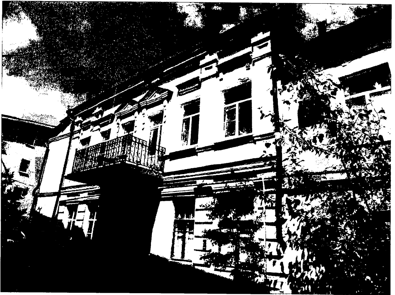
Фото 1. Вид с юго-востока.
