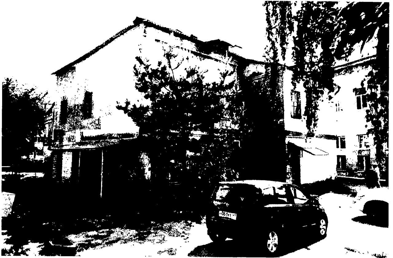
Фото 3. Вид с северо-запада.
