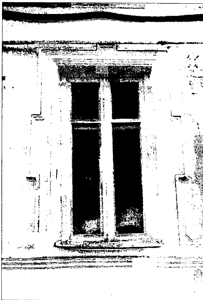
Фото 6. Элементы фасадного декора – наличник и подоконный пояс.
