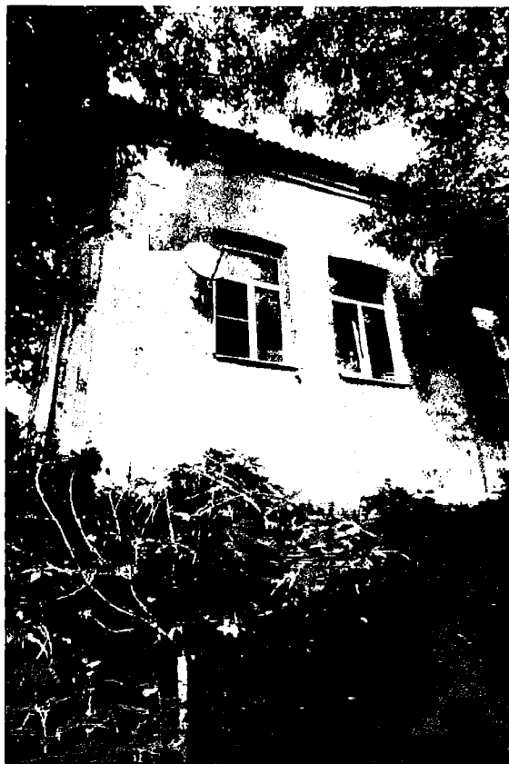
Фото 11. Левая часть южного фасада.
