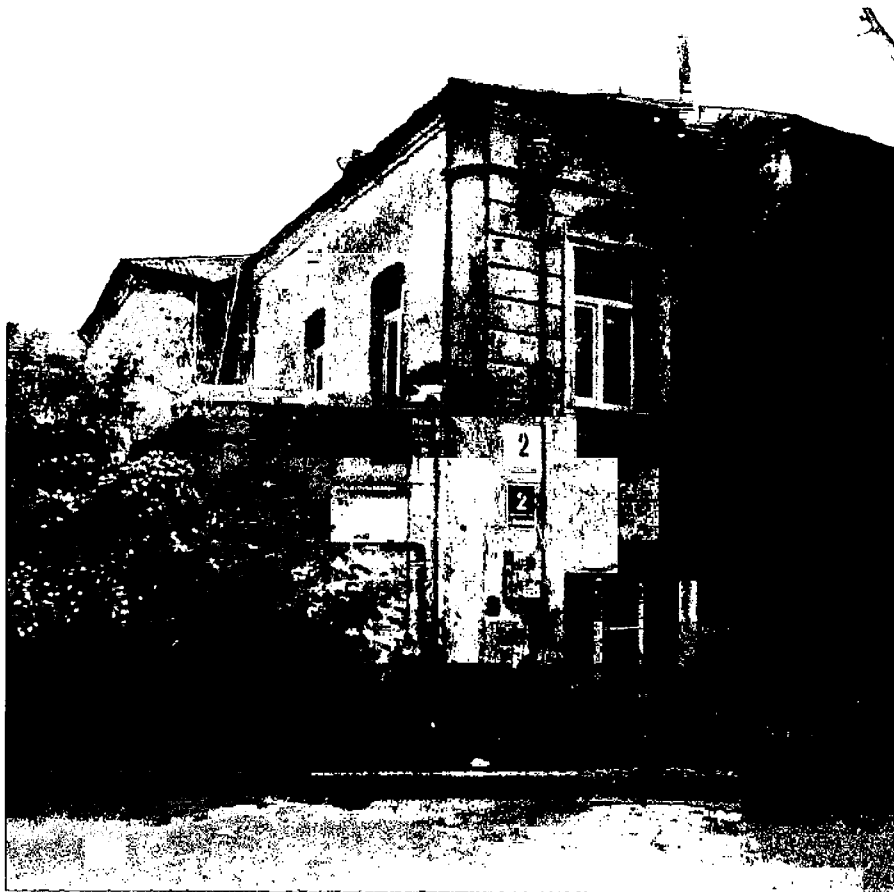
Фото 4. Северо-восточный угол здания.
