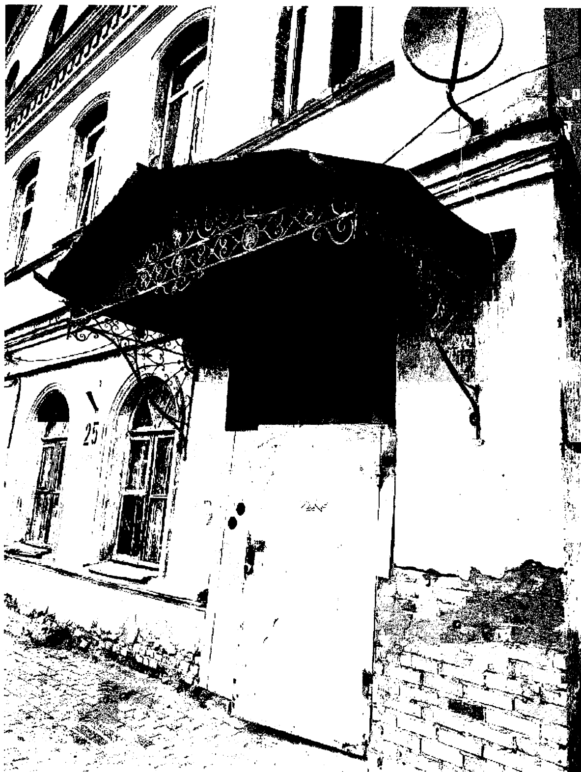
Фото 9. Козырек над главным входом.
