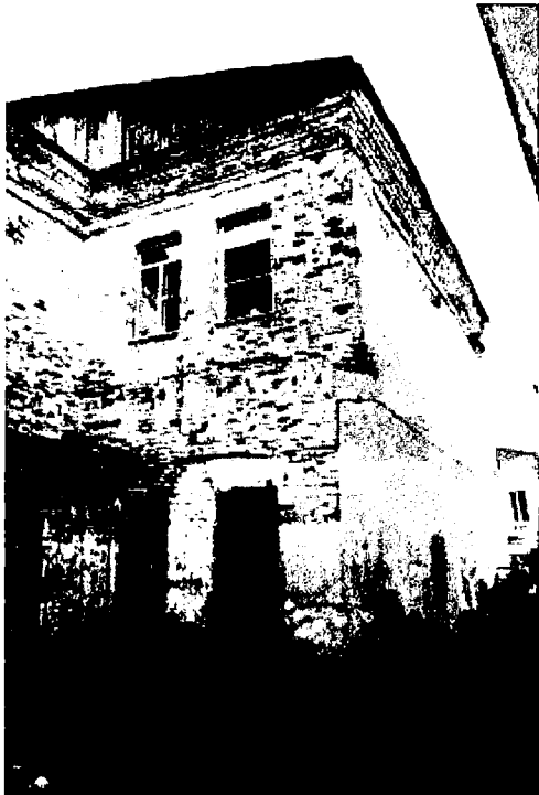
Фото 13. Правая часть северного фасада.
