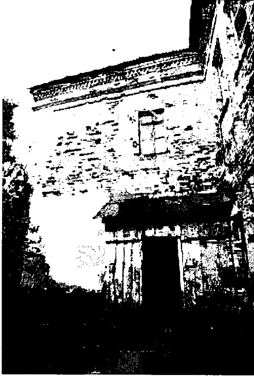
Фото 14. Левая часть западного фасада.
