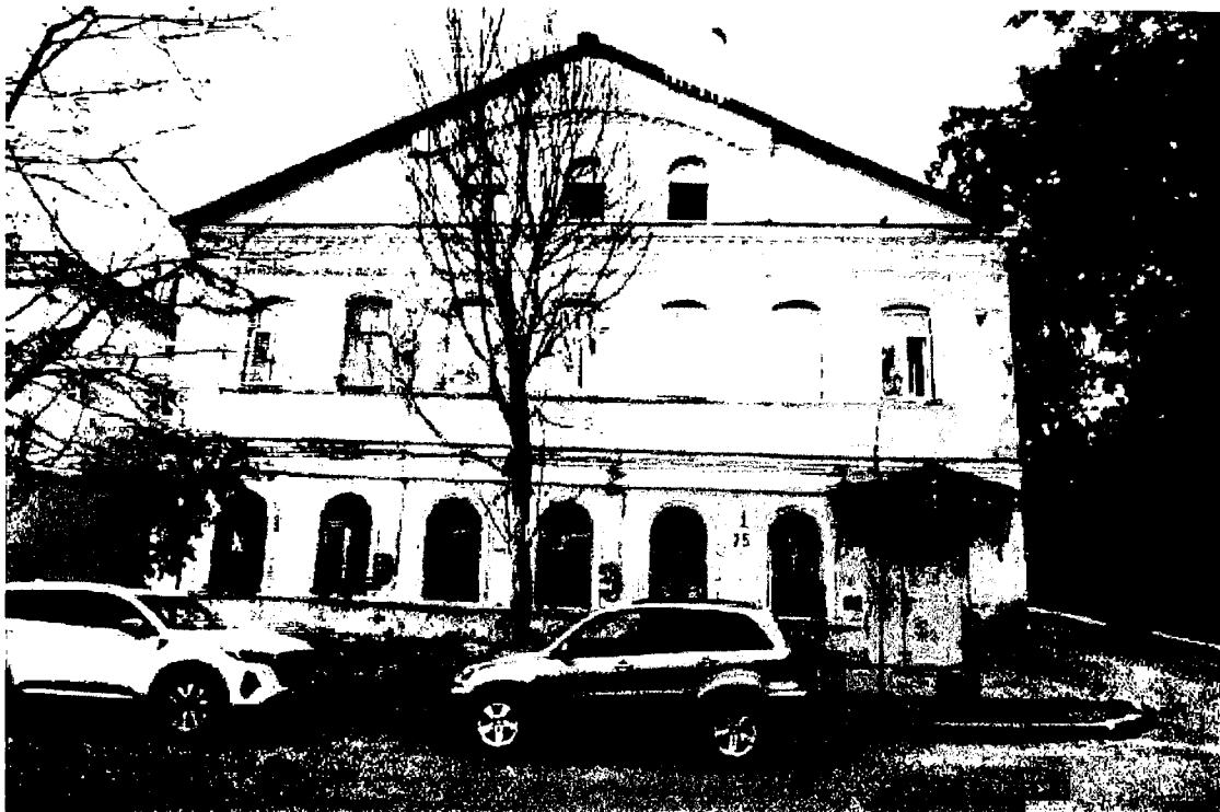
Фото 4. Южный (уличный) фасад.
