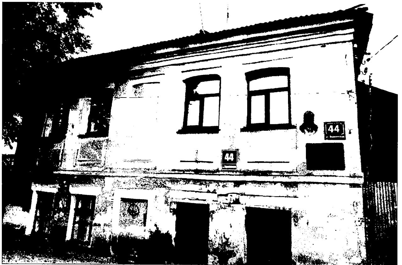
Фото 2. Уличный (северный) фасад.
