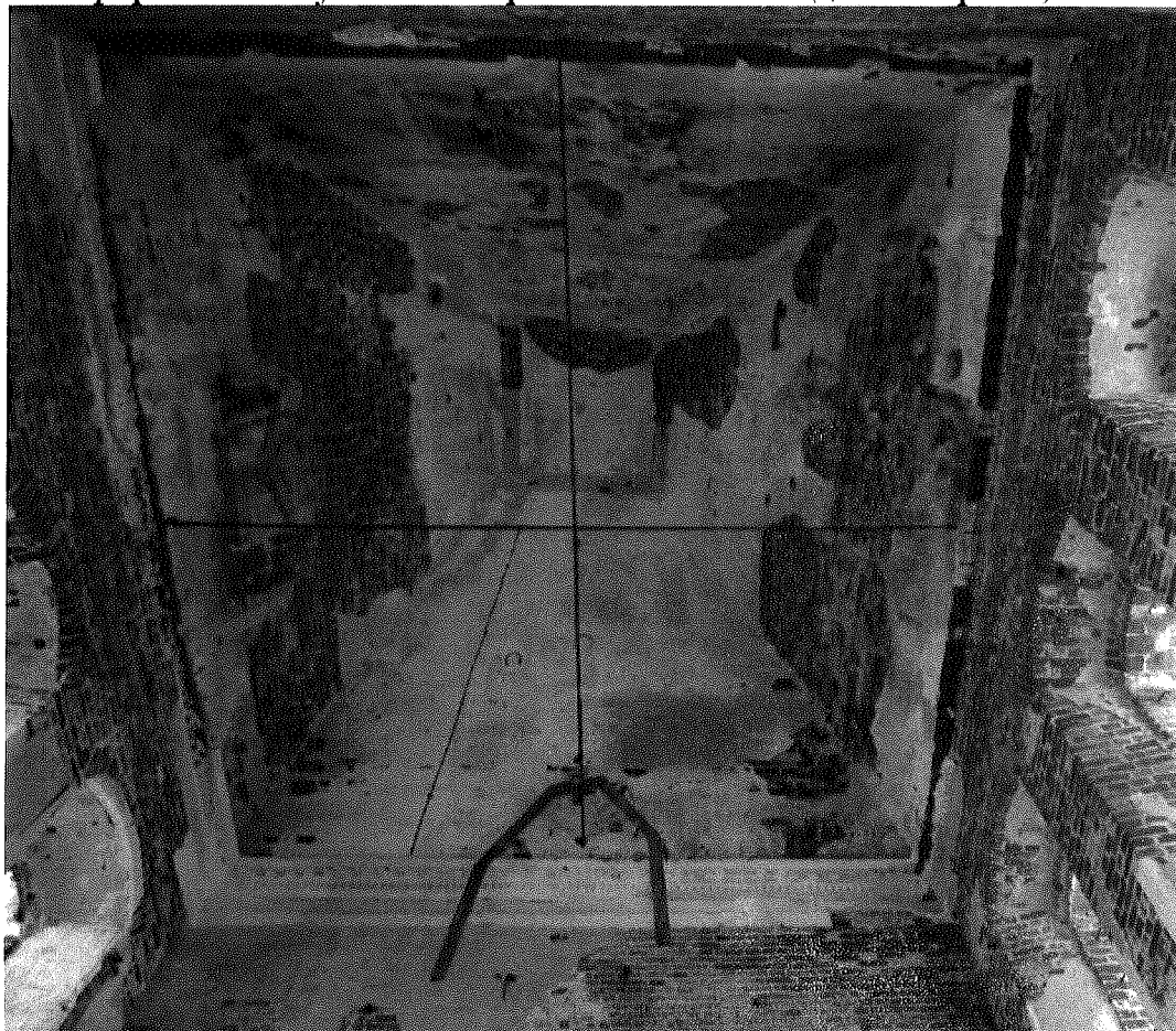
Габариты и форма сомкнутого четырехлоткового свода четверика;
