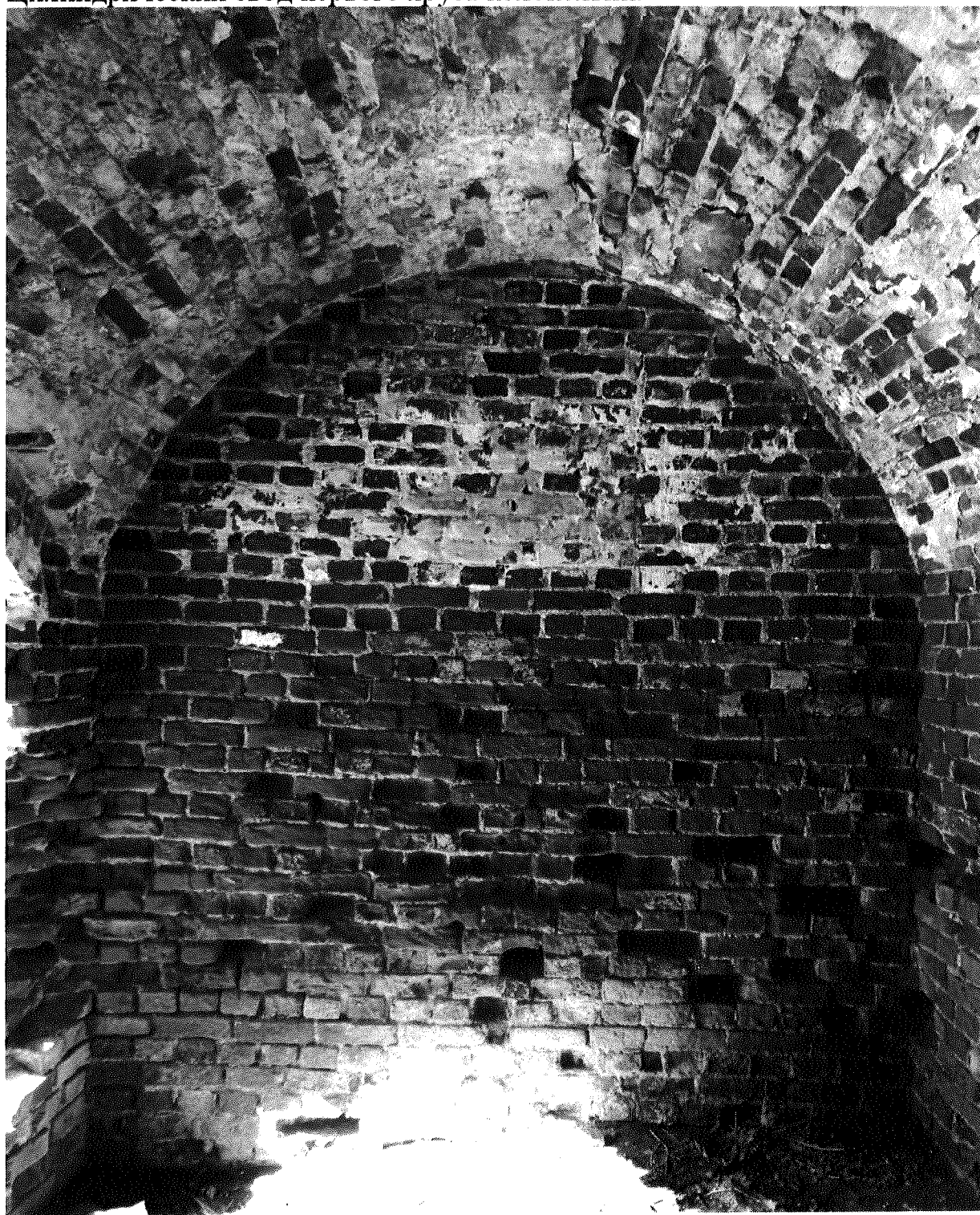
Цилиндрический свод первого яруса колокольни.
