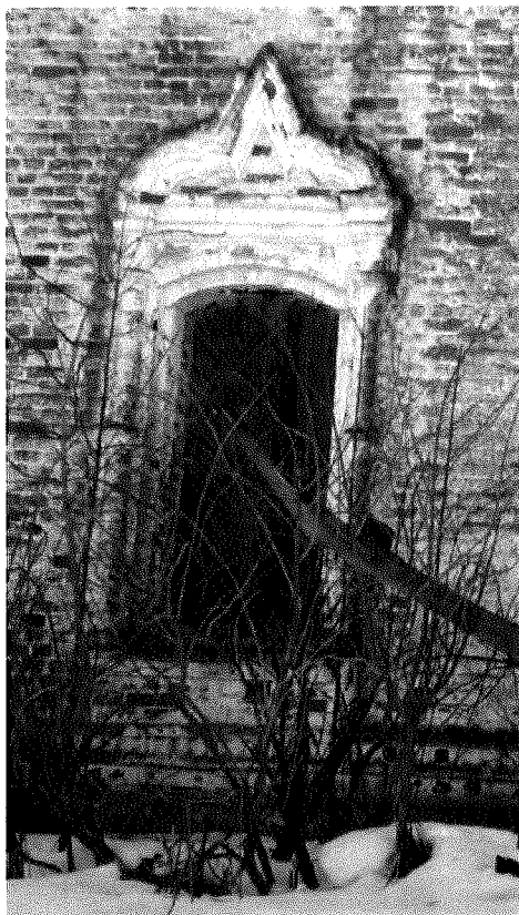
Оконный проем четверика
