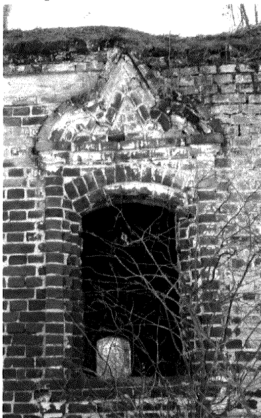
Оконный проем трапезной
