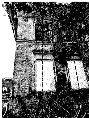
Северо-западный фасад (левая часть)
