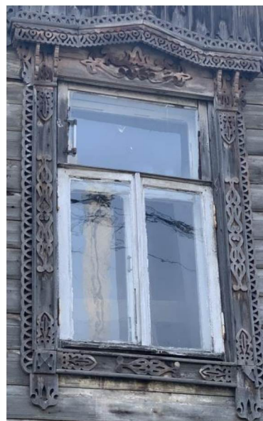
Накладной наличник оконного проема (северный, восточный фасад)
