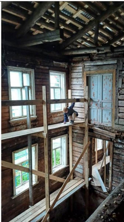
Интерьеры. Основной объем. Вид на северо-восток. Стена с окнами северного фасада. Перпендикулярно ей внутренняя стена-переруб. Делит северный фасад на первое и второе прясло.
