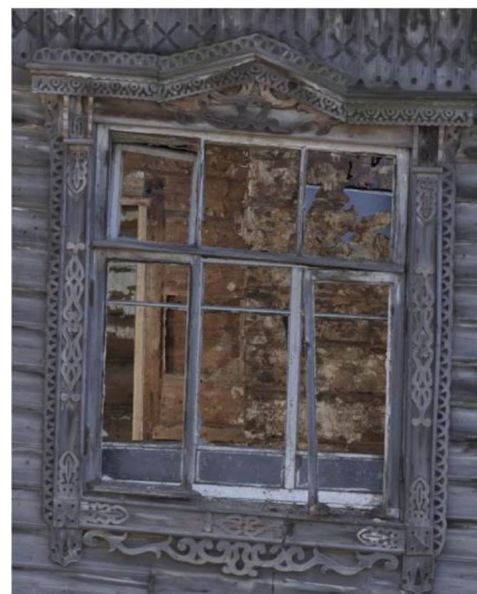
Накладной наличник трехчастного оконного проема (северный фасад второй этаж)
