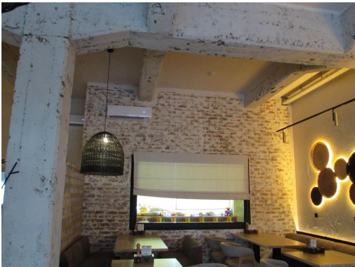
несущие столбы прямоугольного сечения; плоские перекрытия по железобетонным балкам
