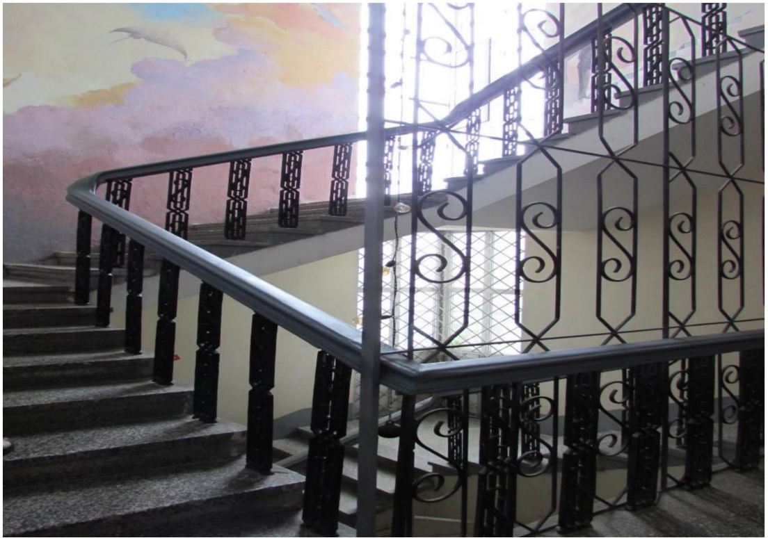
трехмаршевая лестница в северо-западной части правого объема: профилированные бетонные ступени, рисунок кованных ограждений, деревянные поручни
