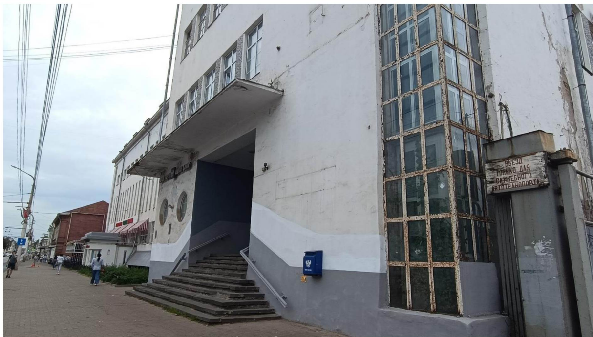
горизонтальный бетонный козырек большого выноса над входом в здание со стороны северо-восточного (главного) фасада правого объема
