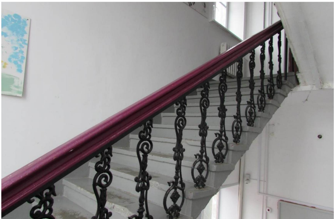
двухмаршевая лестница в северо-восточной части левого объема: профилированные бетонные ступени, рисунок кованных ограждений, деревянные поручни; двухмаршевая лестница в юго-западной части левого объема: профилированные бетонные ступени, рисунок кованных ограждений, деревянные поручни
