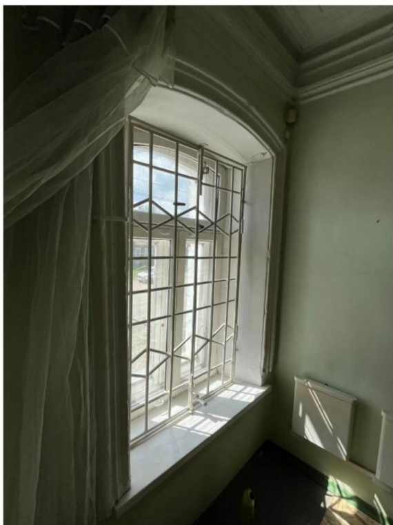
Тянутые наличники оконных проемов в помещениях 2-го этажа
