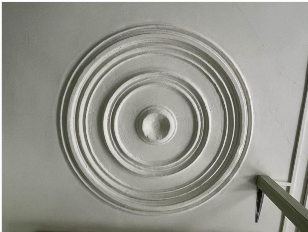
Тянутая потолочная розетка в помещении 2-го этажа
