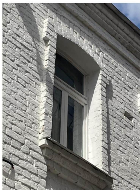
Рамочные наличники с ушами и подоконными полочками окон 2-го этажа
