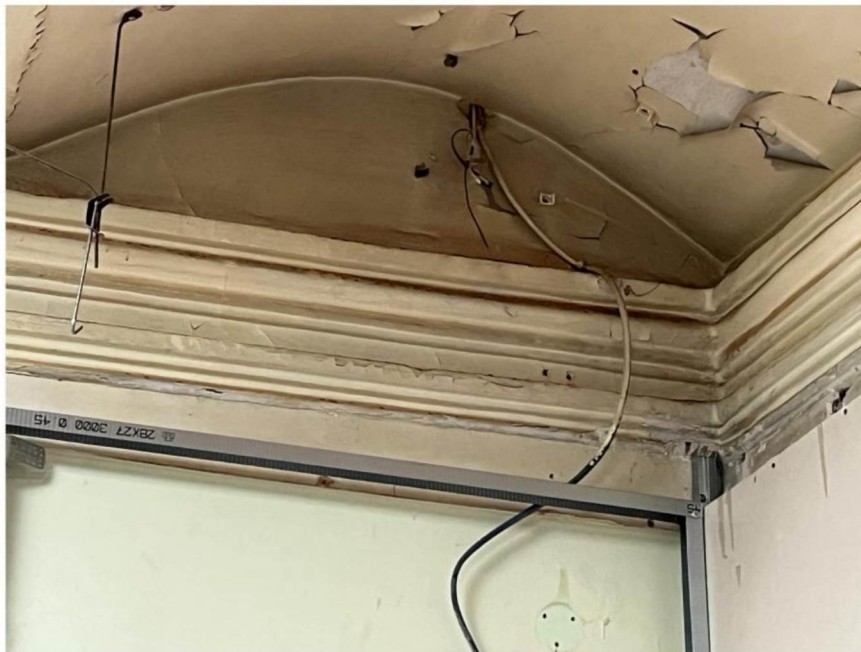
Тянутый потолочный карниз 1-го этажа
