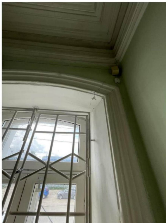
Тянутые наличники оконных проемов в помещениях 2-го этажа
