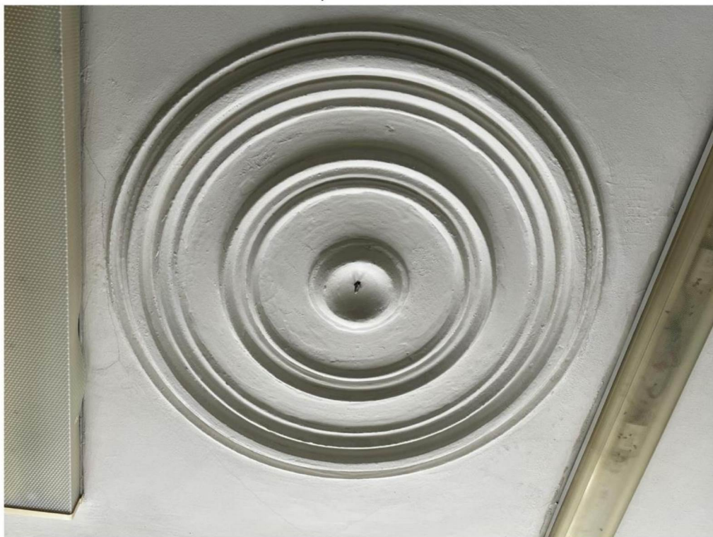
Тянутая потолочная розетка в помещении 2-го этажа
