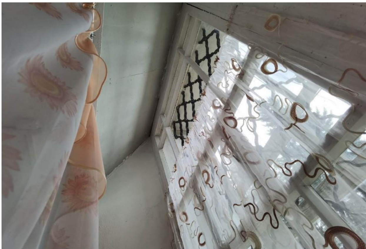
85. Костромская обл., г. Нерехта. Церковь Богоявления (Никольская). Южная палатка. Подшивной потолок, закрывающий коробовый свод перекрытия палатки. Фото июль 2024 г
