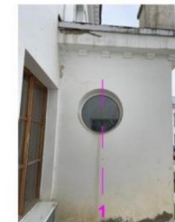
Юго-восточный фасад восточного объема тамбура
