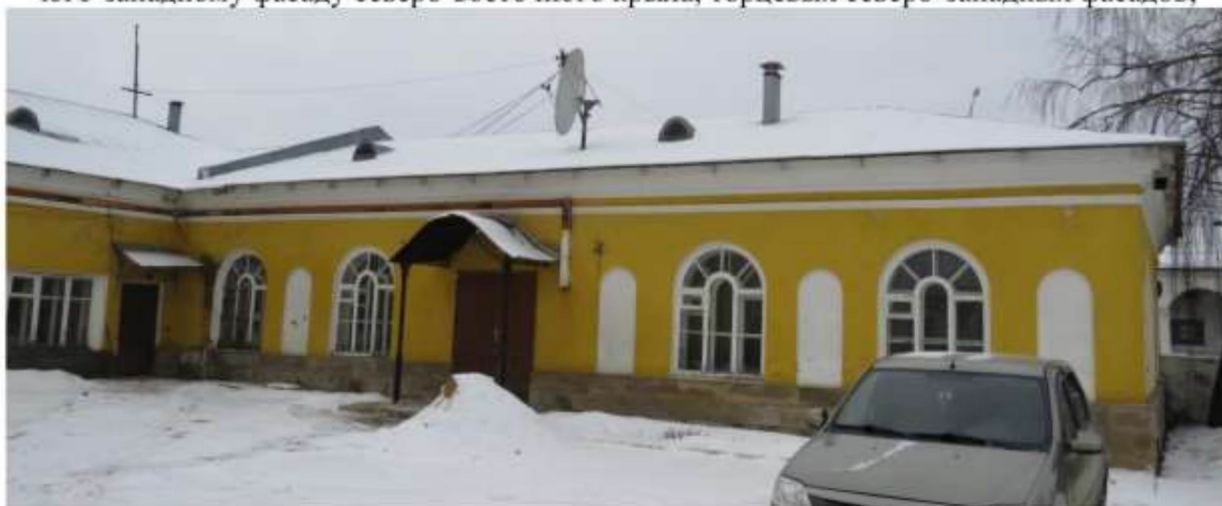
Северо-восточный фасад юго-западного крыла
