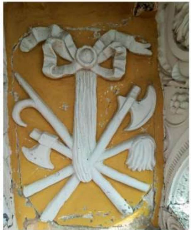
15) крупные волUTOобразные кронштейны, поддерживающие смотровую площадку и лепной декор в простенках, изображающий детали воинского вооружения; розетки на выносах площадки между кронштейнами;
