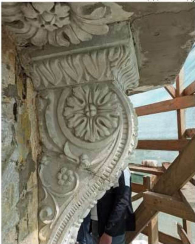
15) крупные волUTOобразные кронштейны, поддерживающие смотровую площадку и лепной декор в простенках, изображающий детали воинского вооружения; розетки на выносах площадки между кронштейнами;
