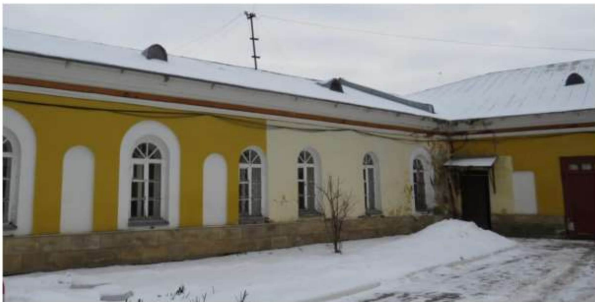
Юго-западный фасад северо-восточного крыла
