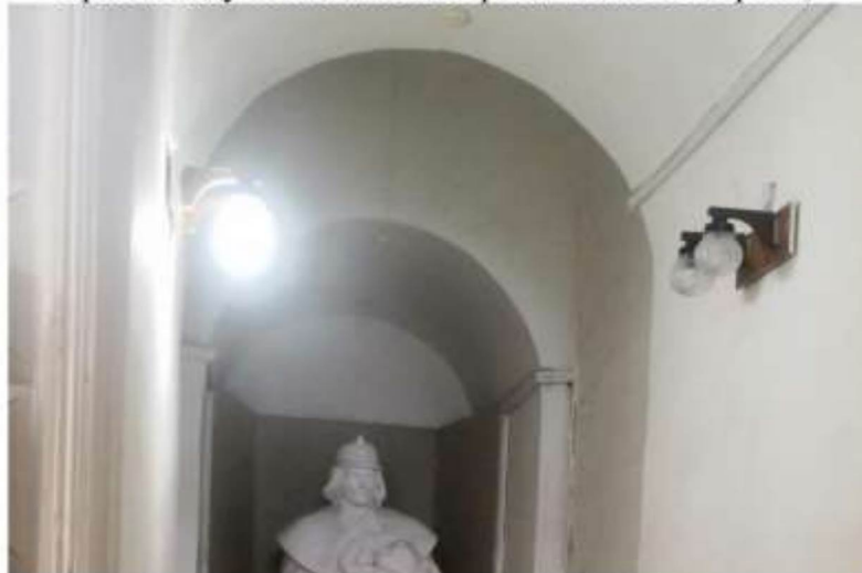
арки между пилонами на первом этаже четверика;
