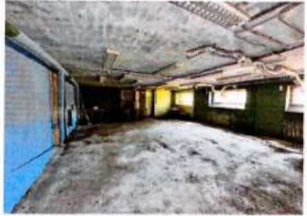
1-ый этаж. Помещение в южной части. Плоское монолитное перекрытие, стены
