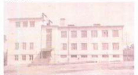
Ю-З лицевой фасад. Фото (копия) 1956 г.
