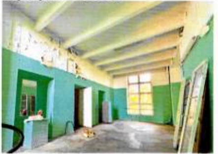
2-ой этаж. Холл. Плоское ж/бребристое перекрытие, кирпичные стены
