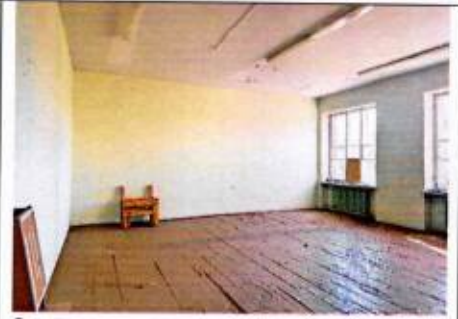
2-ой этаж. Помещение в Ю-З части. Плоское ж/б перекрытие, кирпичные стены
