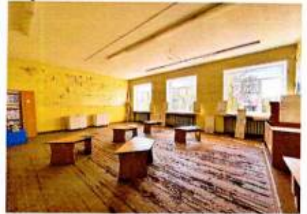
2-ой этаж. Помещение в южной части. Плоское ж/б перекрытие, кирпичные стены
