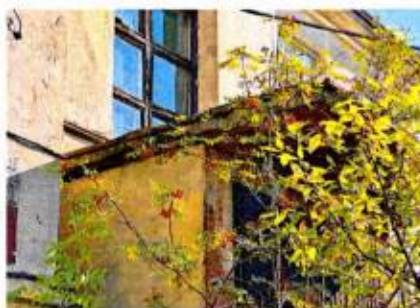
Бетонная плита козырька
