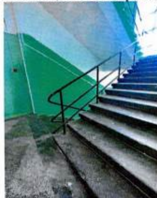
Лестница ЛК-1. Ограждение
