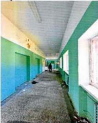
2-ой этаж. Коридор. Плоское ж/б перекрытие, кирпичные стены
