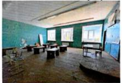
3-ий этаж. Помещение в Ю-З части. Плоское ж/б перекрытие, кирпичные стены
