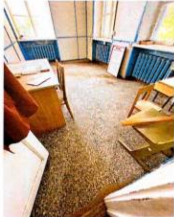
Бетонное мозаичное покрытие пола. Помещение в западной части. 2-ой этаж
