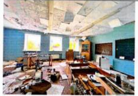
1-ый этаж. Помещение в западной части. Плоское ж/б перекрытие, стены
