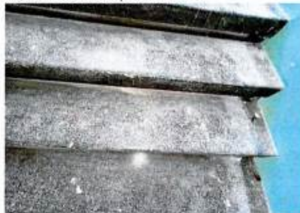
Бетонное мозаичное покрытие ступеней ЛК-1
