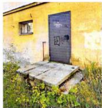
Входная площадка. С-З фасад
