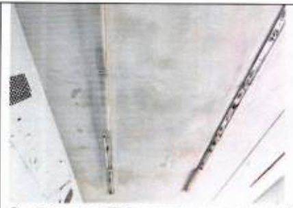
3-ий этаж. Помещение в южной части. Плоское ж/б перекрытие
