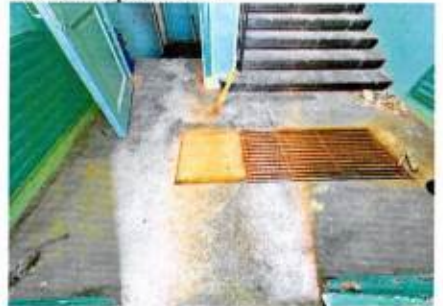
Бетонное мозаичное покрытие пола. Вход. 2-ой этаж
