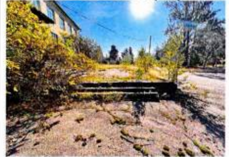
Входная площадка. ЮЗ фасад
