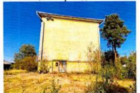
Ю-В торцевой фасад
