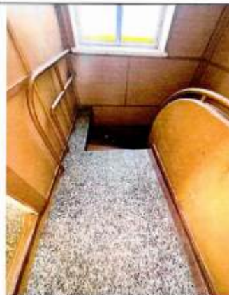
Бетонное мозаичное покрытие пола. Помещение Л-2
