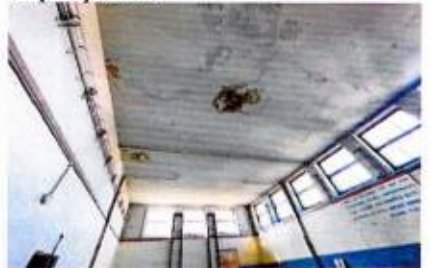
2-ой этаж. Зал. Ж/б перекрытие
