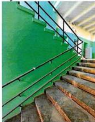
Лестница ЛК-1. Ограждение
