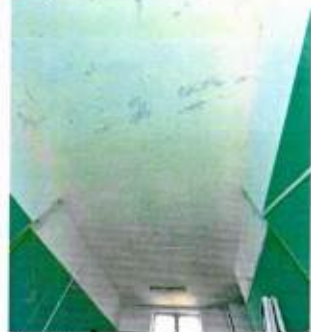
3-ий этаж. Холл. Плоское ж/б перекрытие
