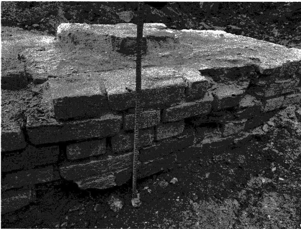
7. Структура кирпичной кладки фундамента здания.
