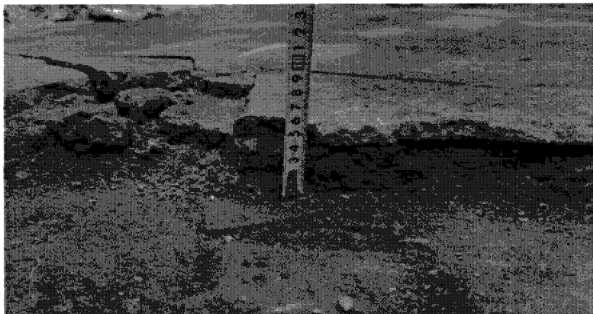
4. Вид на структуру отделки верхнего слоя полов здания.
