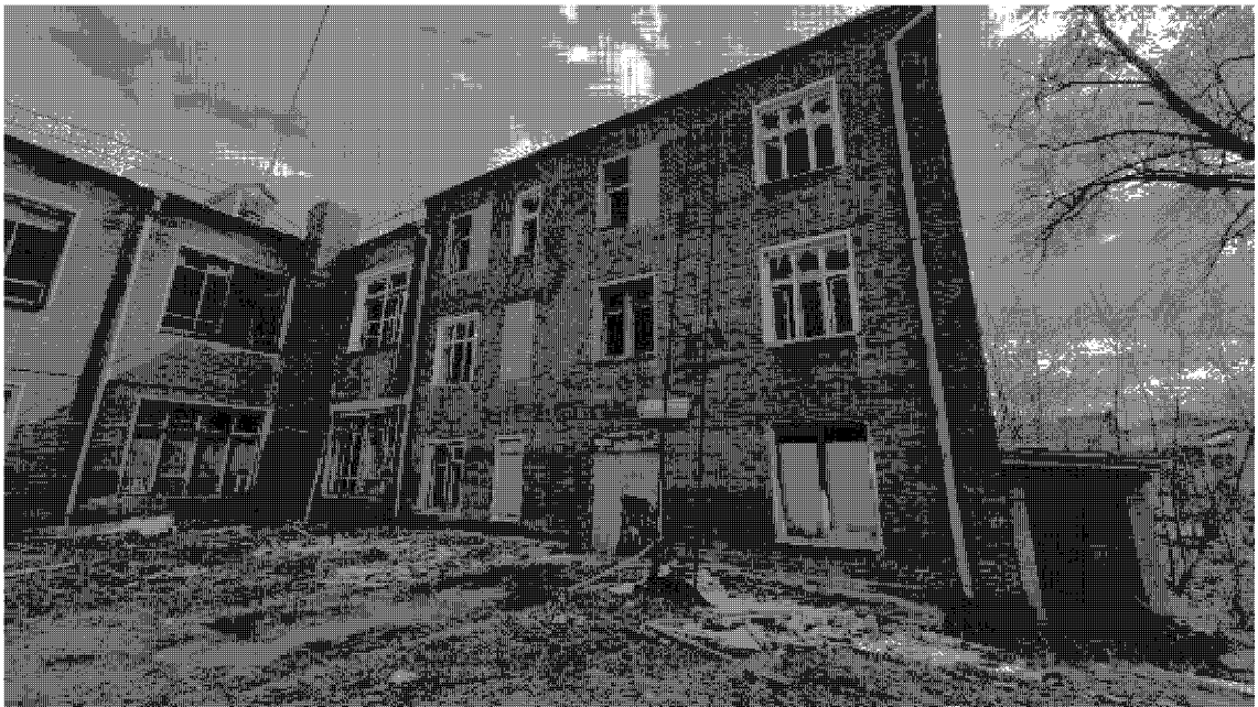
6. Дворовые фасады здания. Вид с запада.
