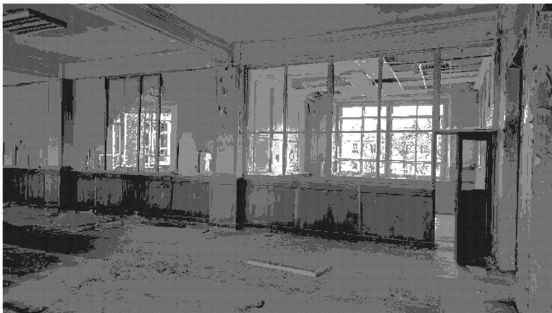
27. Интерьер второго этажа. Архитектурно-художественное оформление стоечно-балочной конструкции. Вид с северо-востока.
