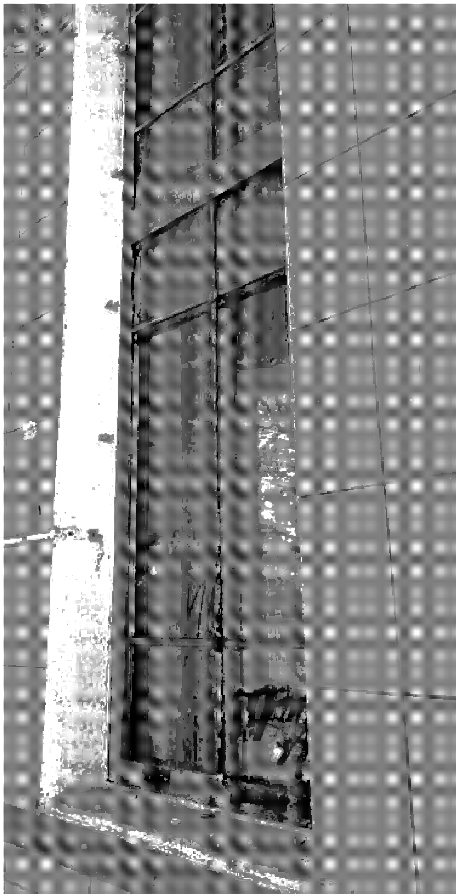
9. Оконный проем с металлическим заполнением главного фасада здания. Вид с северо-востока.
