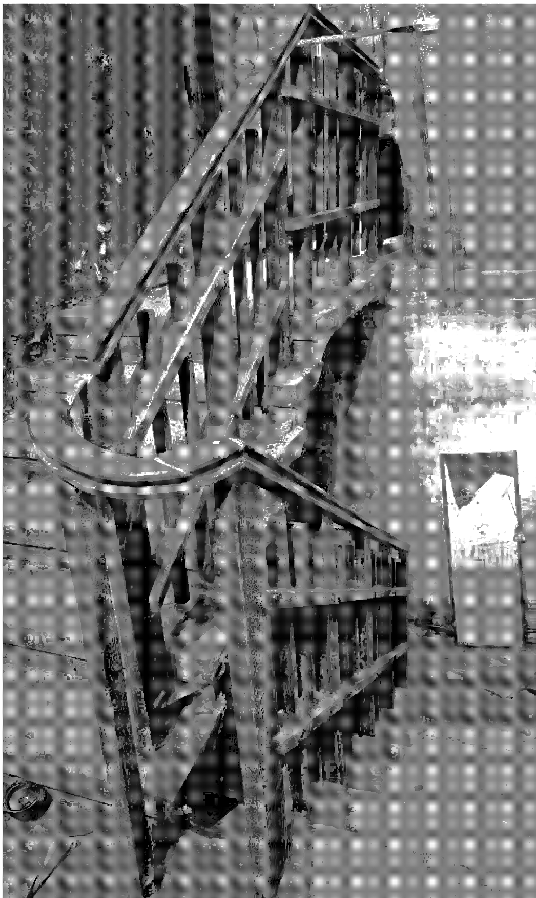
36. Черный лестничный марш. Вид с юго-востока.
