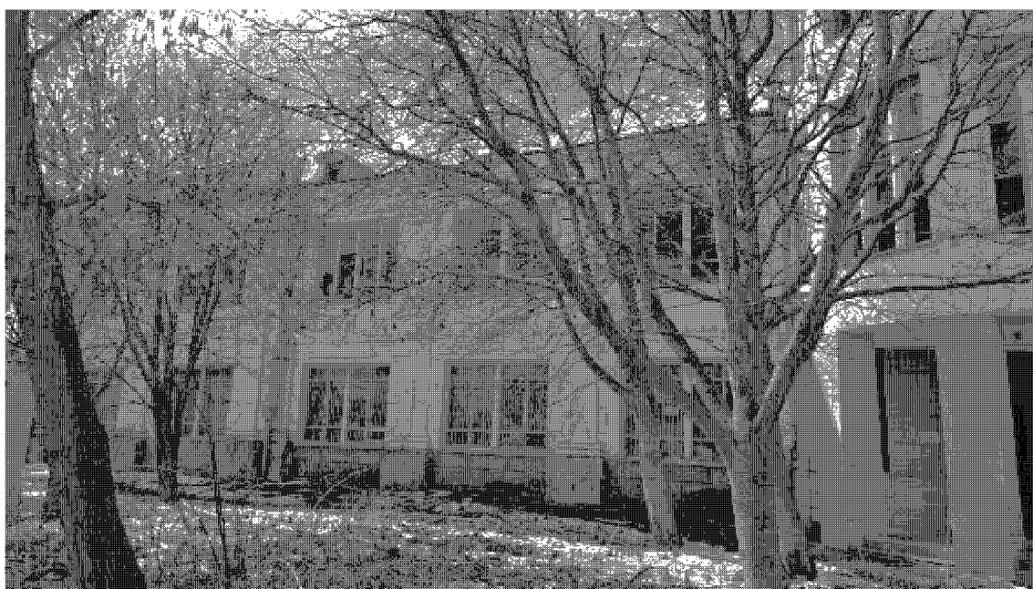
3. Центральная часть главного (северного) фасада. Вид с севера.
