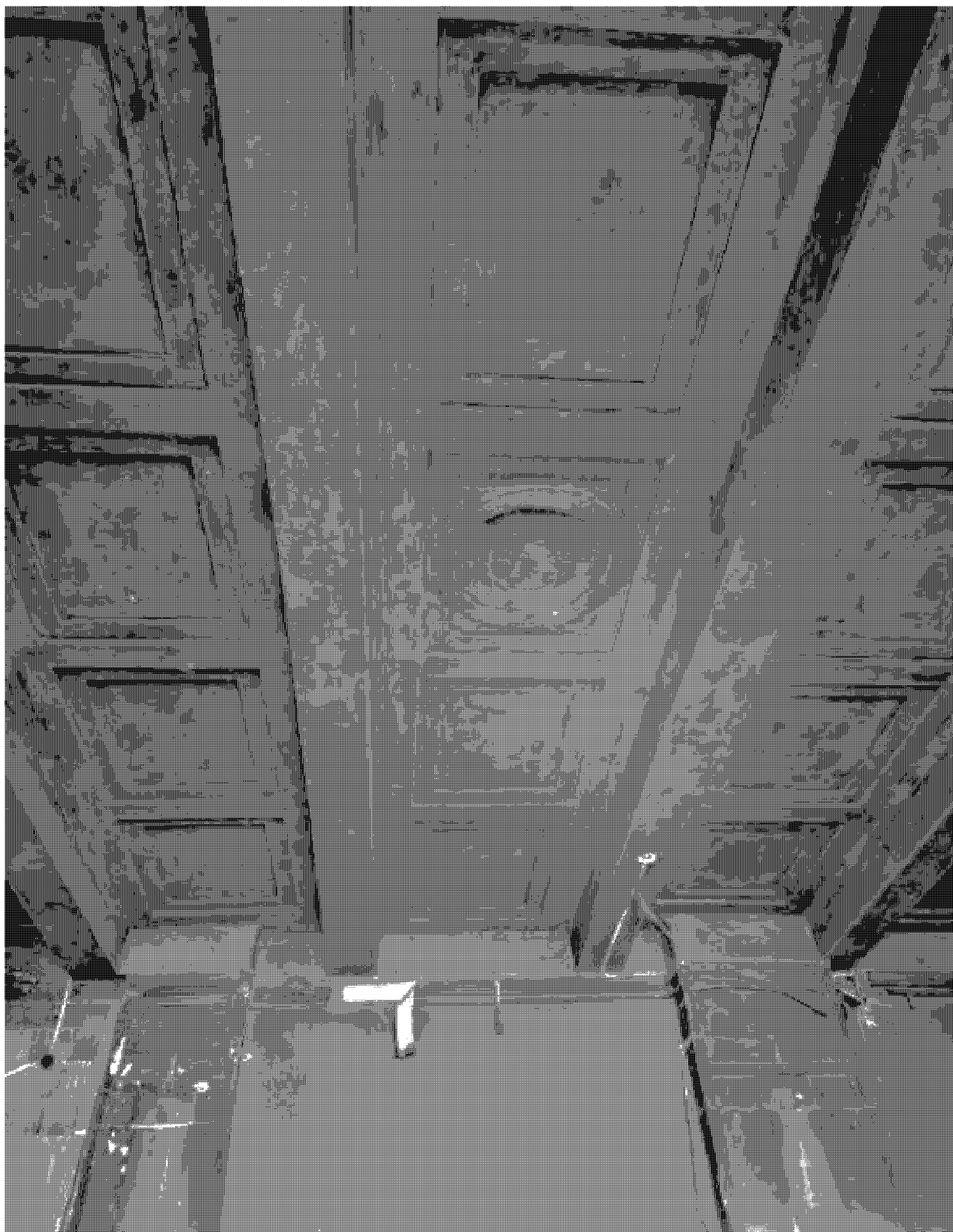
14. Кессонированный потолок холла первого этажа.
