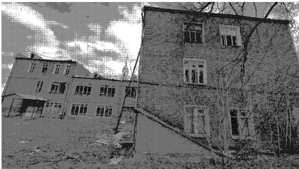
7. Дворовые фасады здания. Вид с юго-запада.
