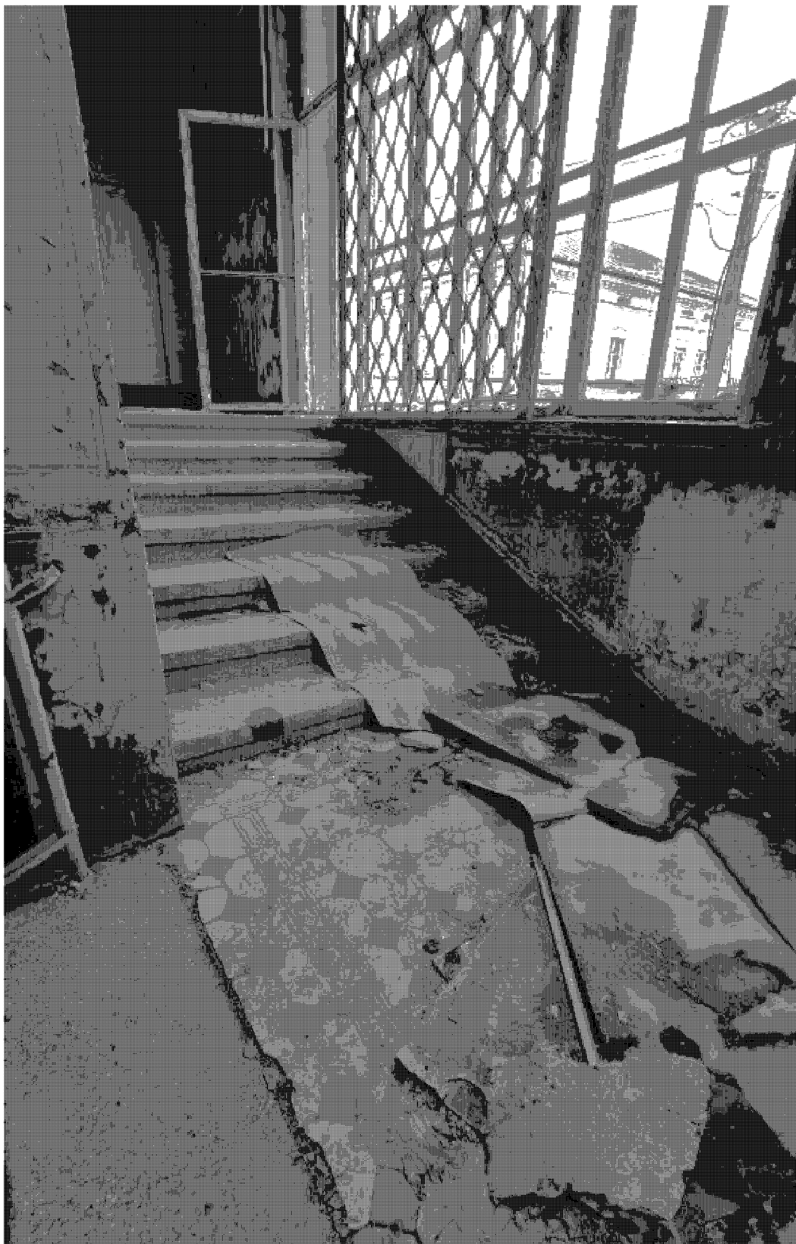
21. Парадный лестничный марш. Метлахская плитка на лестничной площадке. Вид с востока.
