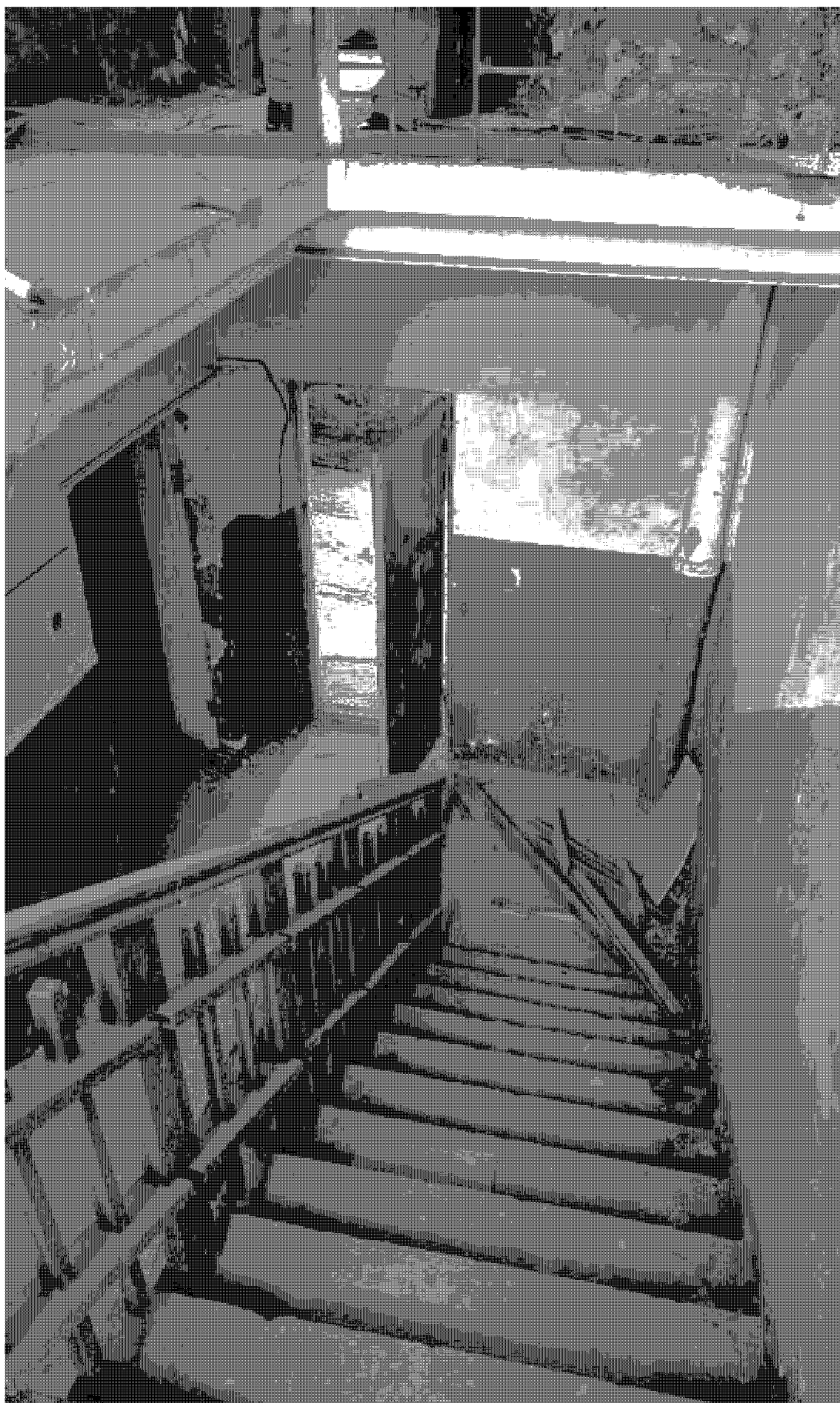
32. Черный лестничный марш. Вид с юго-востока.
