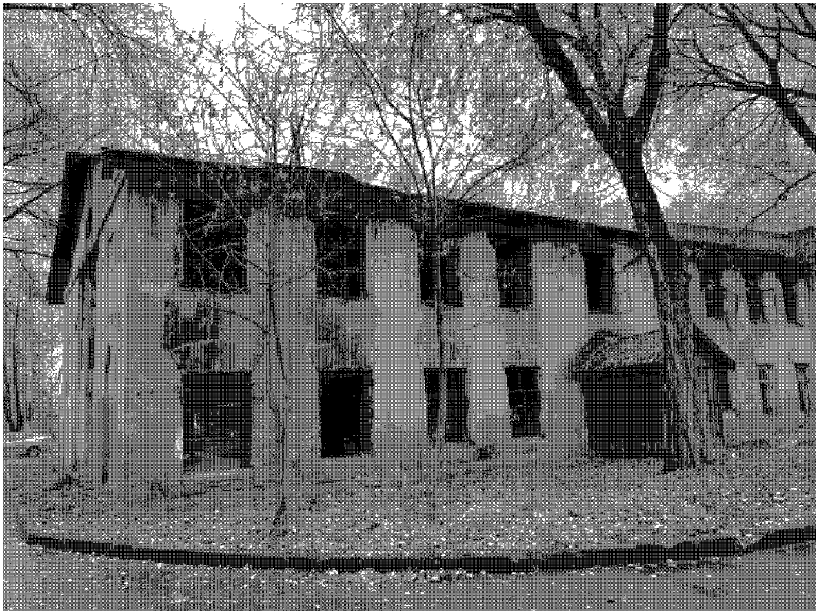
1. Вид с севера на западный фасад здания.
