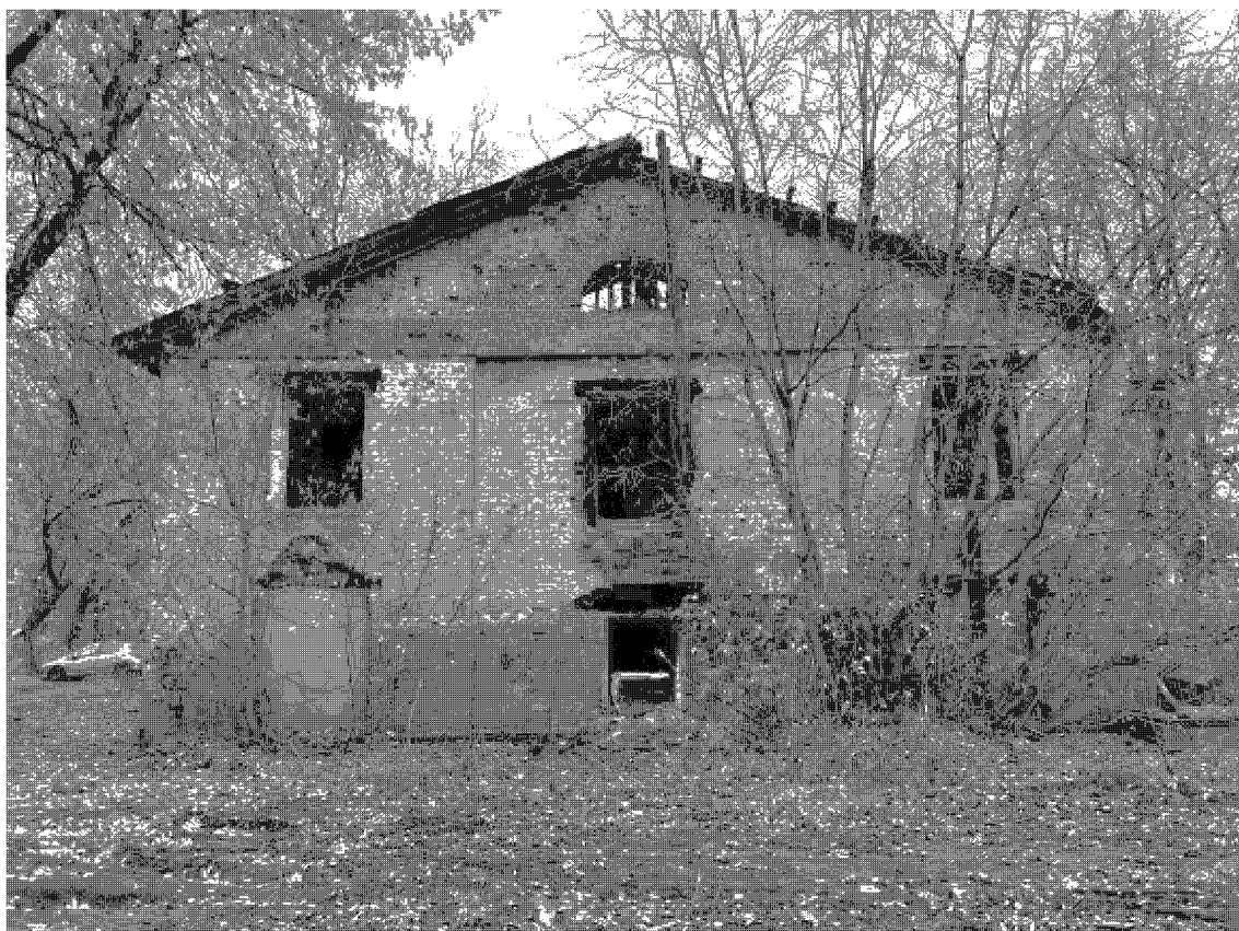
5. Южный (торцевой) фасад здания.
