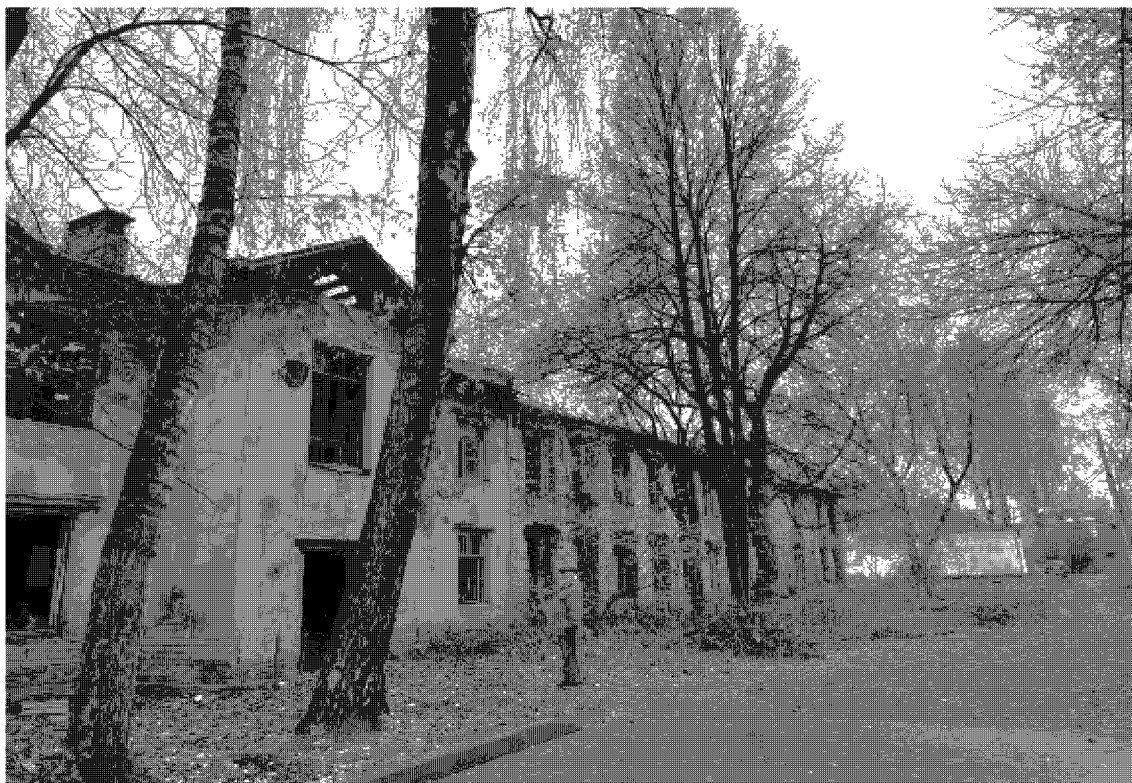
2. Западный фасад центрального и южного объемов здания.
