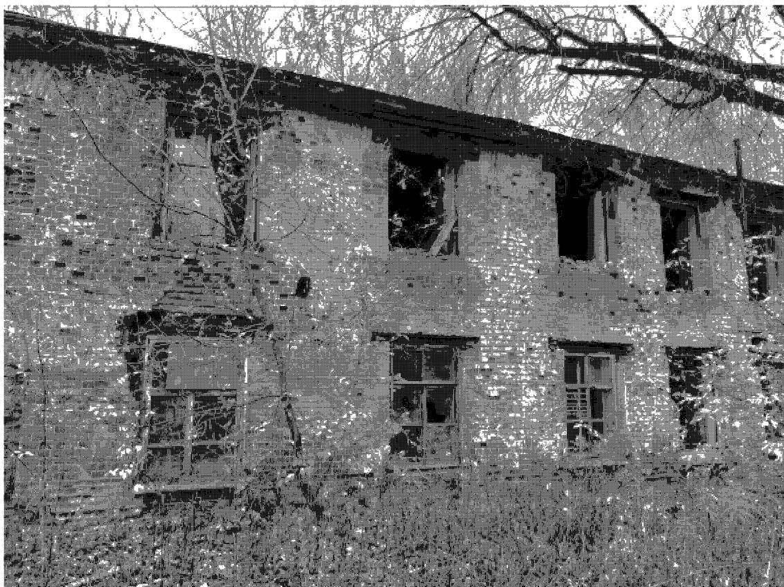
4. Фрагмент восточного фасада южной части здания.
