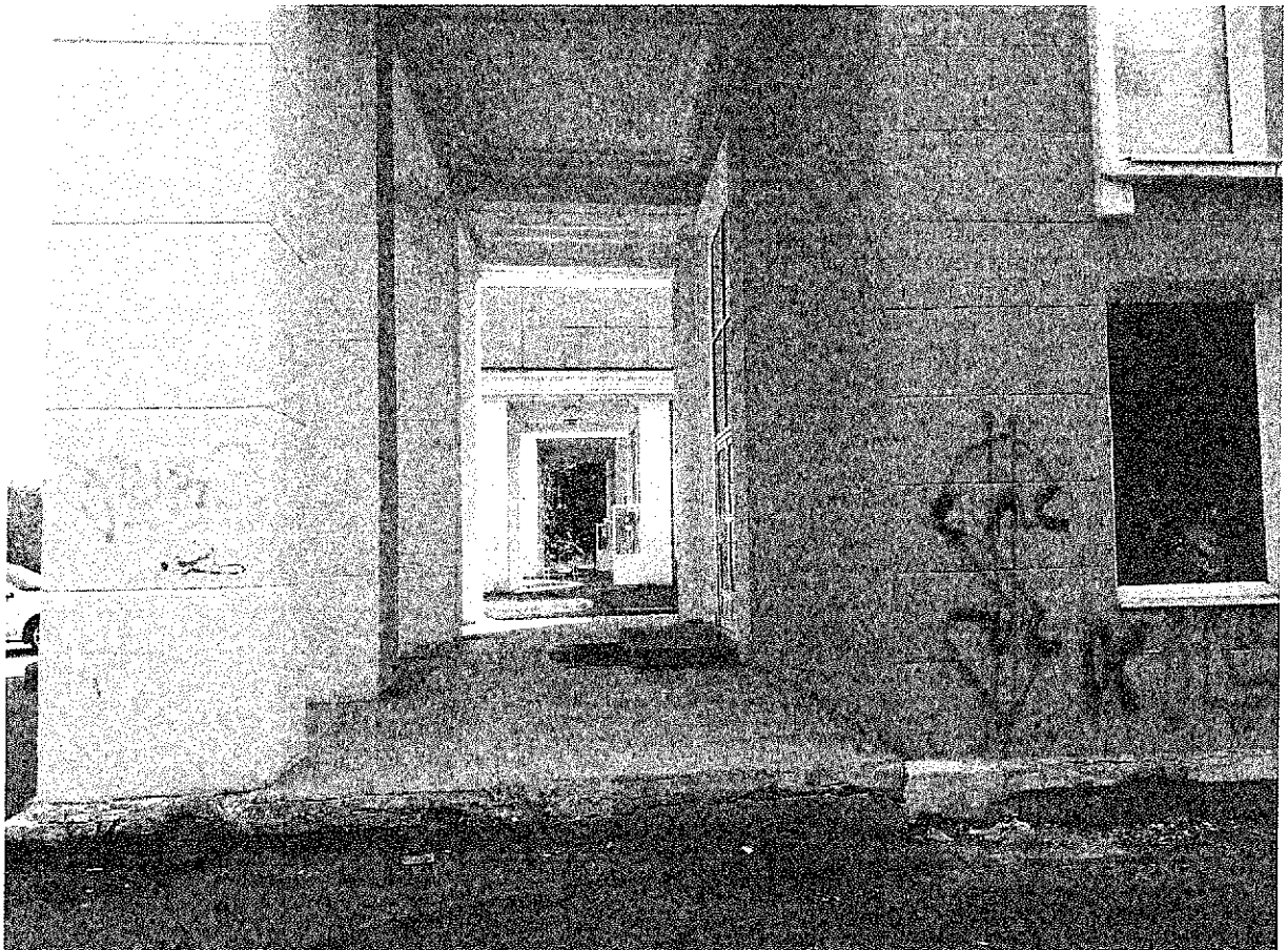
Фото 4. Перспектива прохода вдоль главного северо-восточного фасада между фасадными стенами обоих ризалитов и пилонами
