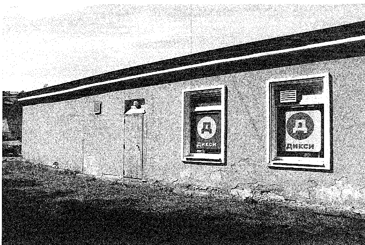
Фото 6. Фрагмент бокового юго-восточного фасада
