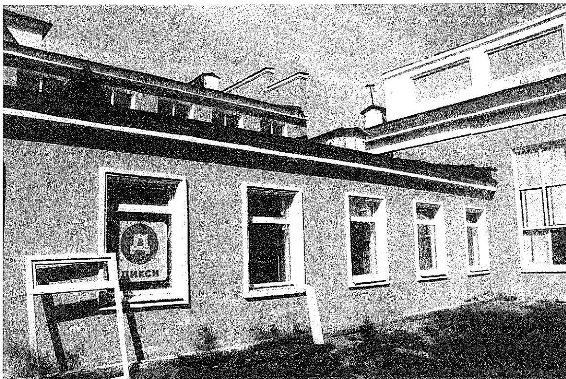
Фото 5. Фрагмент бокового юго-восточного фасада
