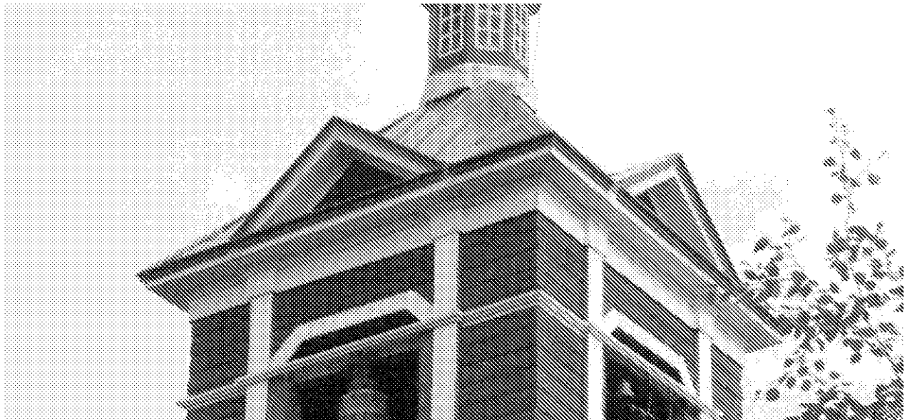
Фото 14. Вид на объект культурного наследия с юга. Четырехскатное завершение звонницы с слухами
