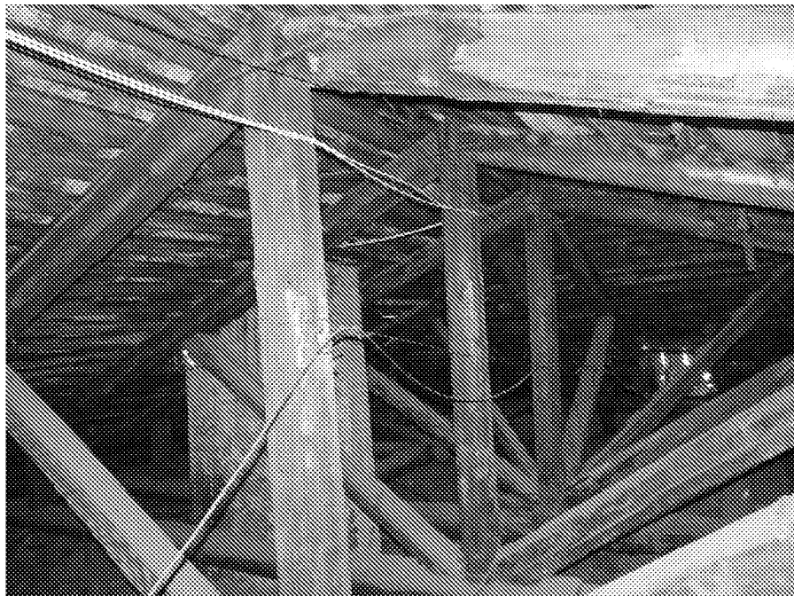
Фотофиксация кровельной системы. 2017г.
