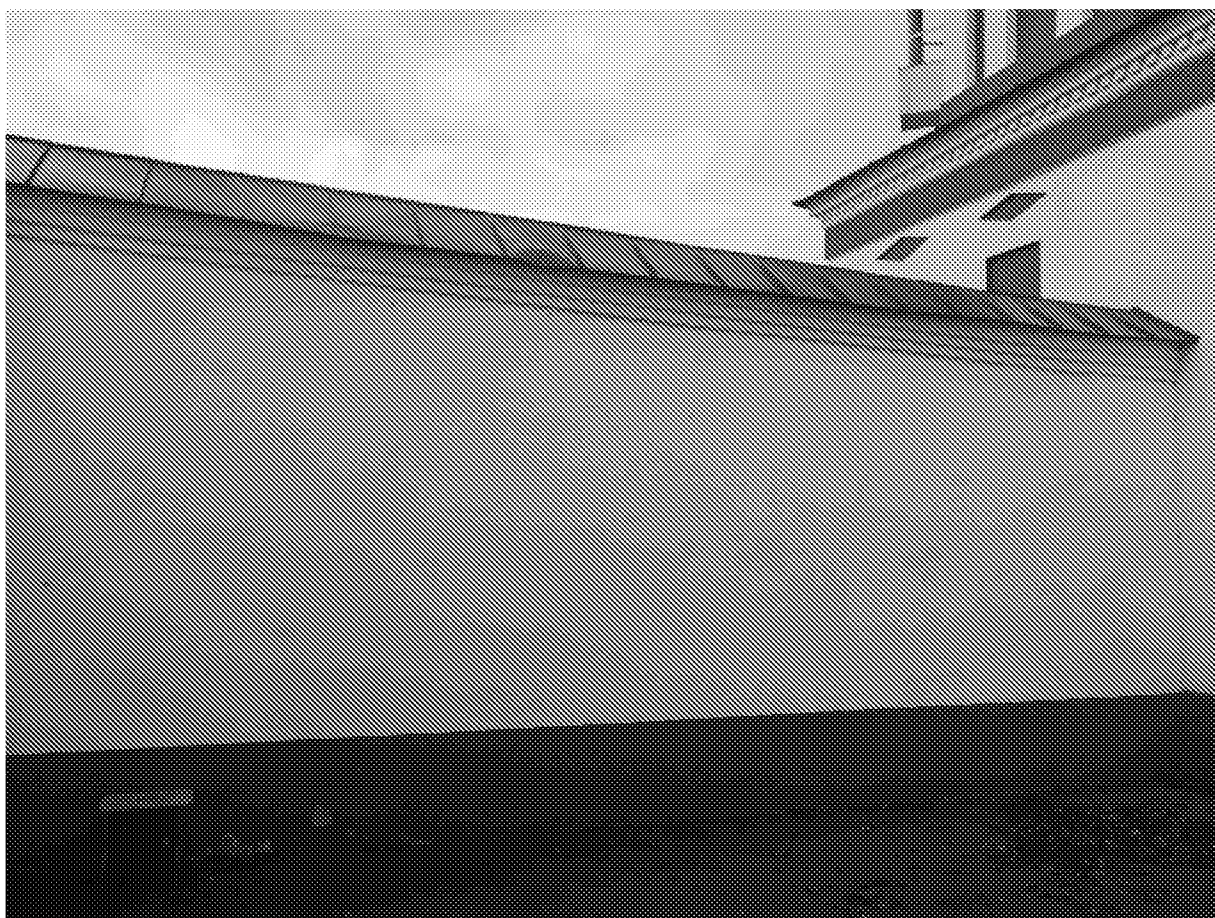
Фрагмент северной стены (20.11.2025)
