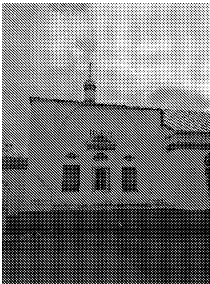
Северо-западный фасад (20.11.2025 г.)
