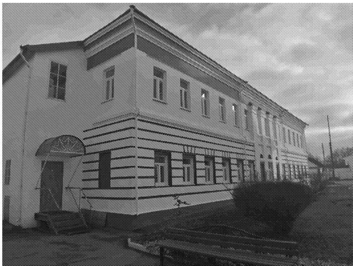
Западный фасад (20.11.2025 г.)
