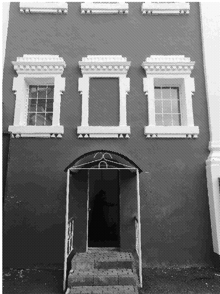
Западный фасад (20.11.2025 г.)
