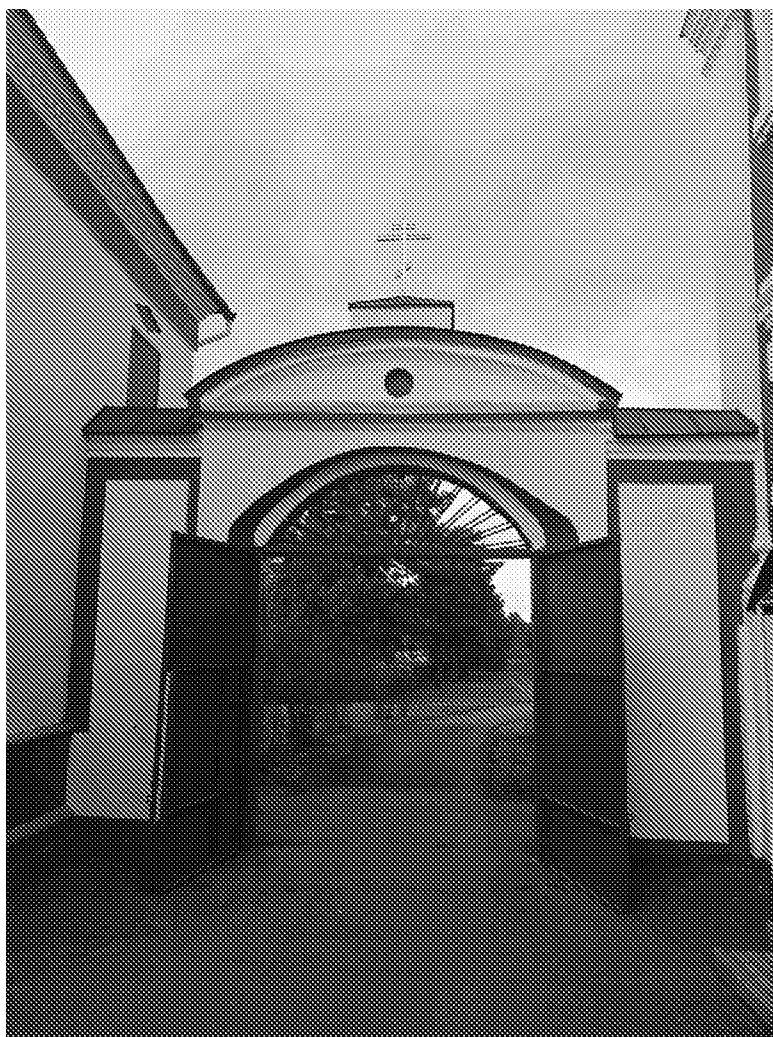
Фрагмент северной стены. Вид с юга (20.11.2025)
