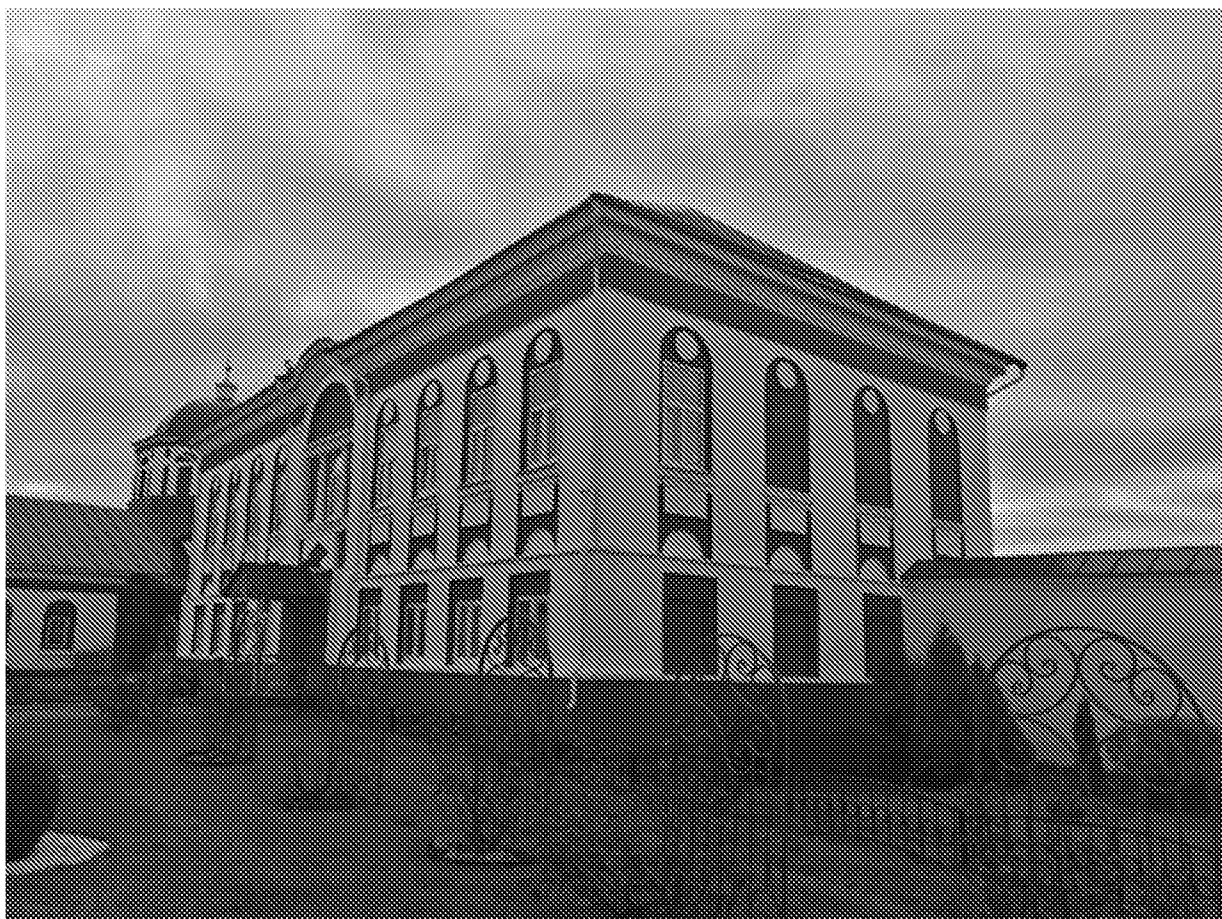
Северный фасад (20.11.2025 г.)
