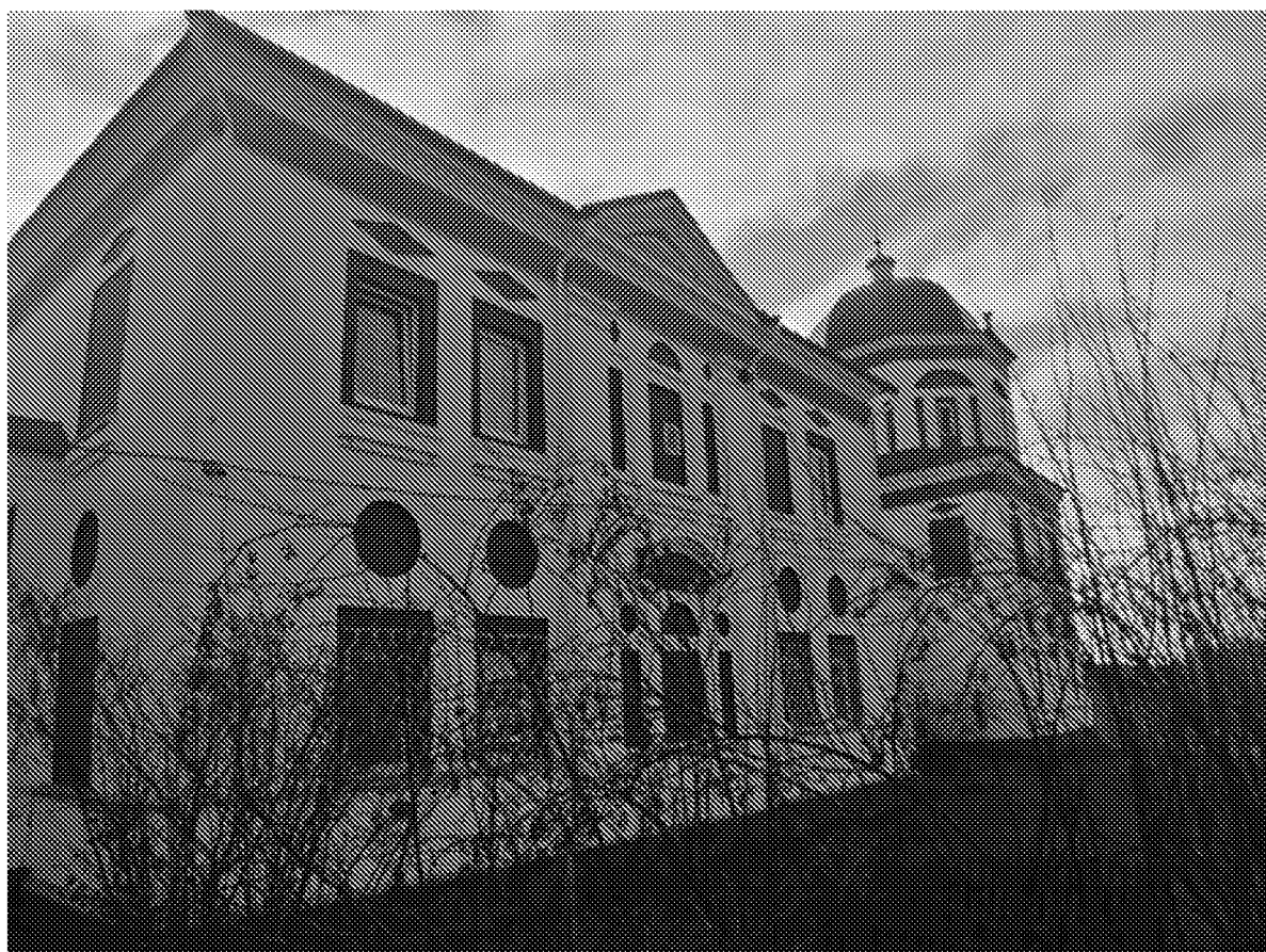
Северный фасад (20.11.2025 г.)
