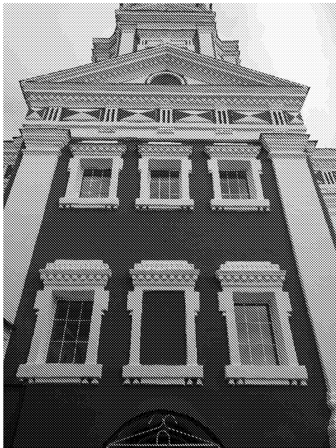
Западный фасад (20.11.2025 г.)
