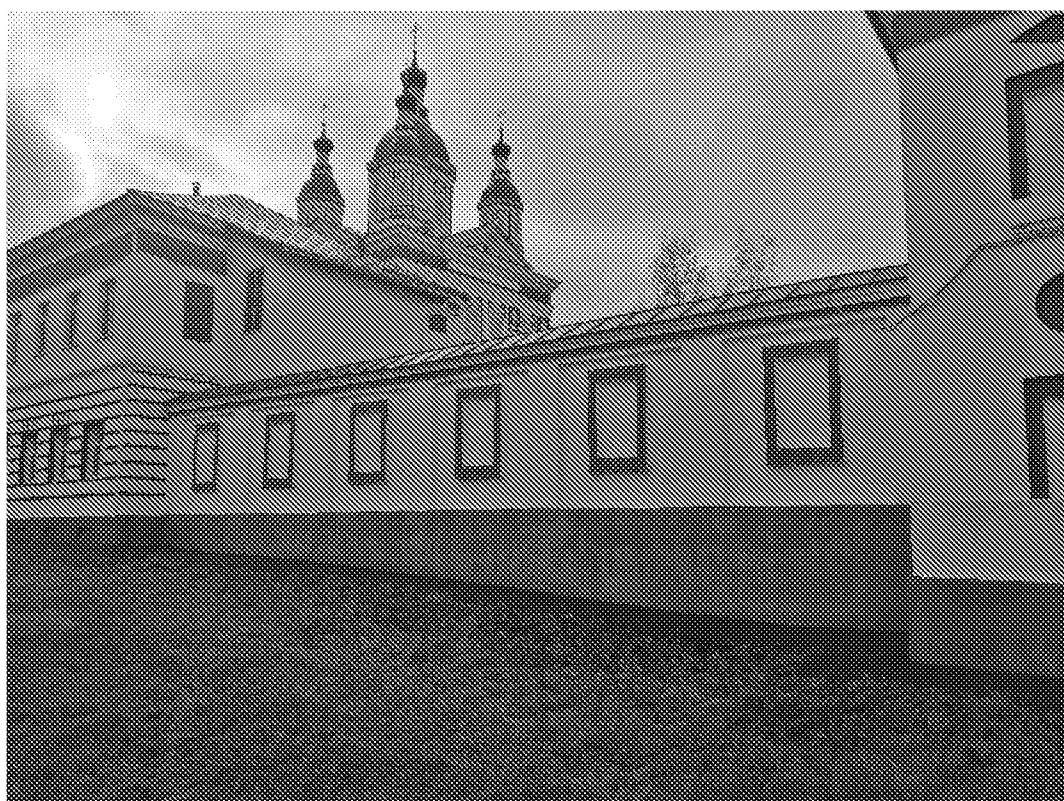
Фрагмент восточной стены. Вид с востока (20.11.2025 г.)
