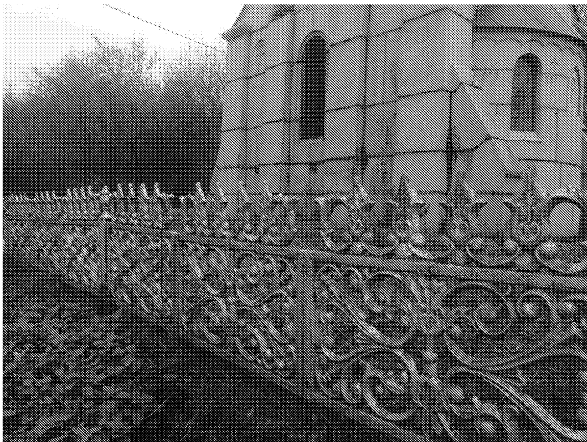
Фрагмент металлического ограждения объекта культурного наследия (02.12.2025 г.)
