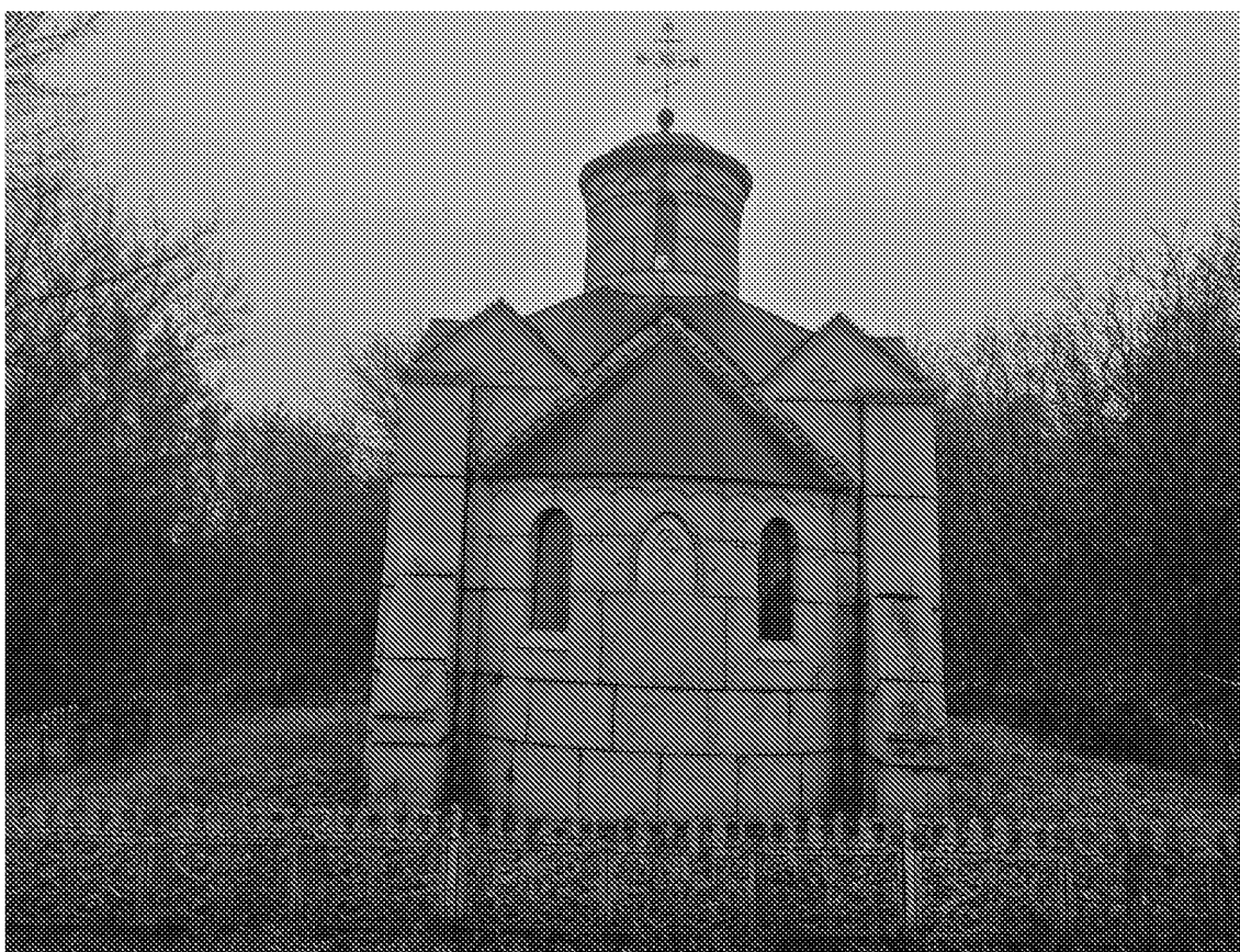
Восточный фасад объекта культурного наследия (02.12.2025 г.)
