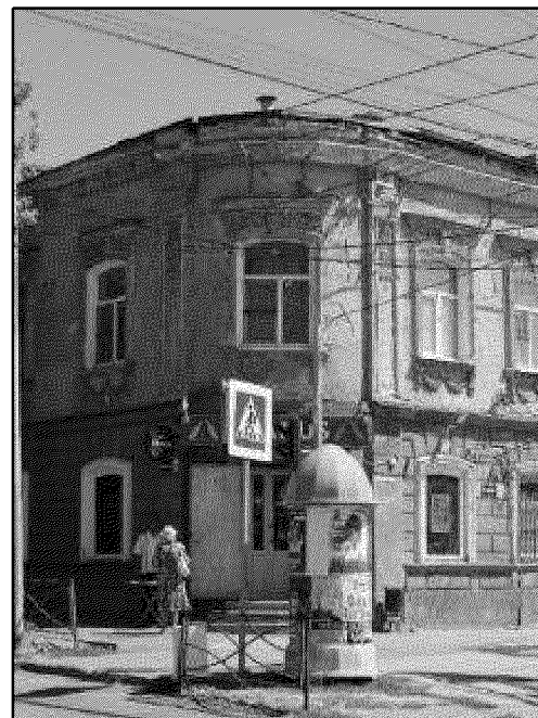
угловая закругленная западная часть объекта культурного наследия
