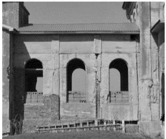
фрагмент южного фасада объекта культурного наследия (арочные оконные проемы трапезной, простеночные лопатки)
