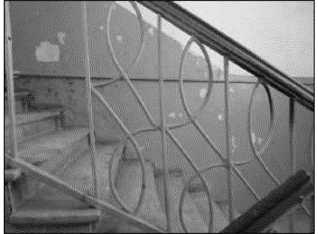
фрагмент металлического сварного ограждения междуэтажной деревянной двухмаршевой лестницы
