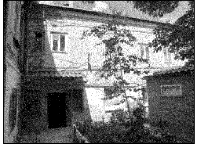
фрагмент юго-восточного дворового фасада литера А1 (кордон цоколя и профилированный карниз)
