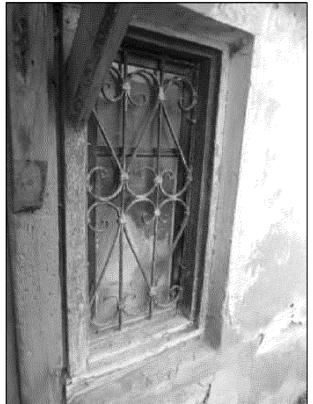
фрагмент юго-восточного дворового фасада литера А1 (первоначальная ажурная металлическая сварная и на хомутах решетка оконного проема первого этажа)
