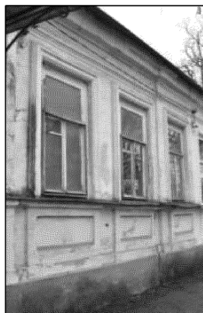
фрагмент парадного северо-восточного фасада объекта культурного наследия (ряд оконных
