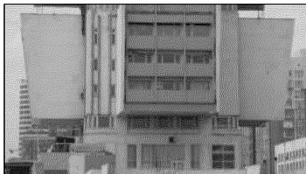
фрагмент восточного фасада (ограждение балконов и витражное остекление)
