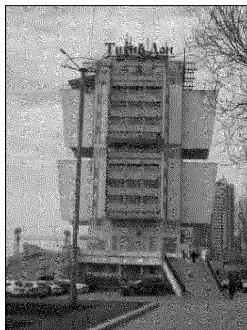
восточный фасад объекта культурного наследия
