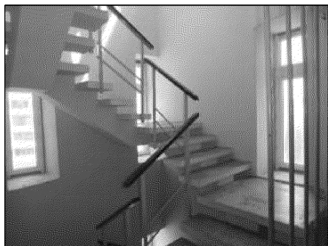
фрагмент внутренней межэтажной лестницы в северо-восточной части объекта культурного наследия
