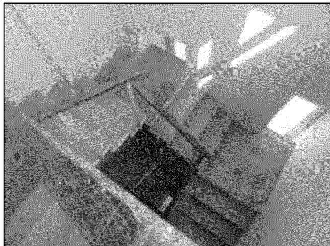
фрагмент внутренней межэтажной лестницы в северо-западной части объекта культурного наследия
