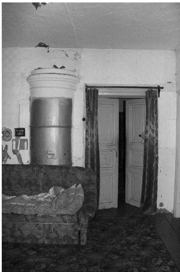
Видовая точка № 16. Голландская круглая печь в кожухе из металла
