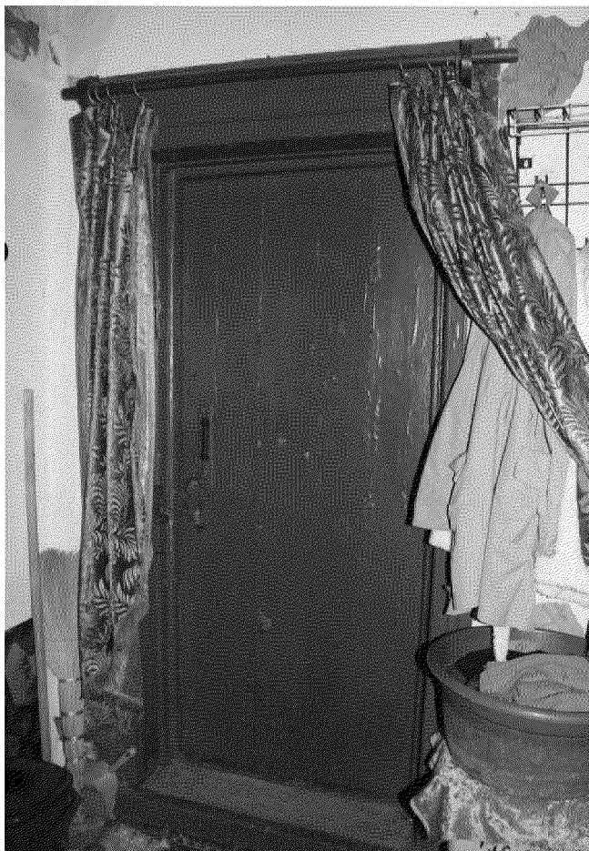
Видовая точка № 17. Дощатая на шпонках дверь в квартиру.
