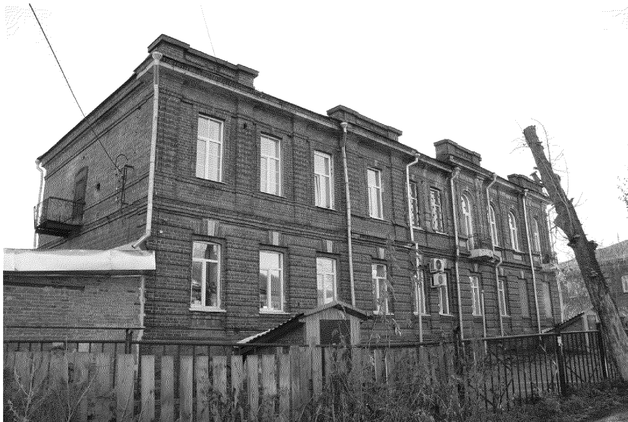
Видовая точка № 9. Северный фасад здания.
