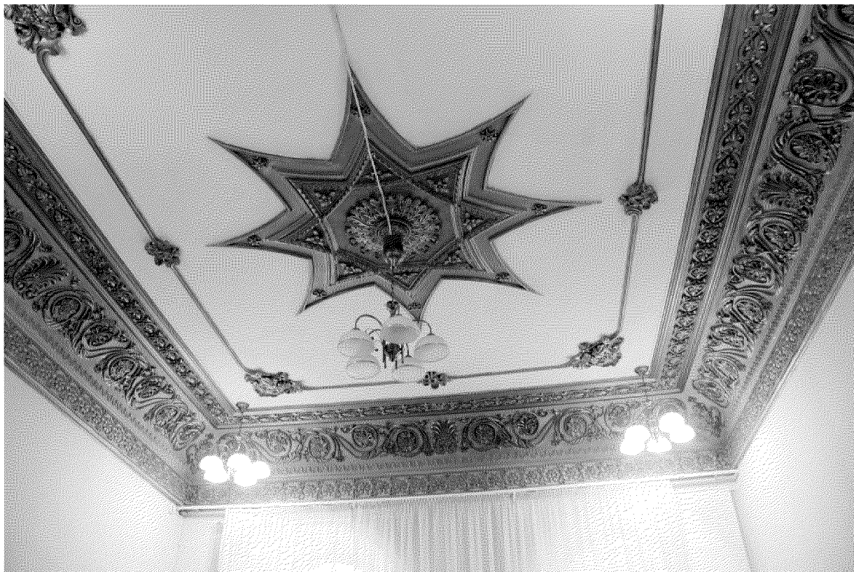
Видовая точка № 18. Декор потолка помещения 2 этажа.
