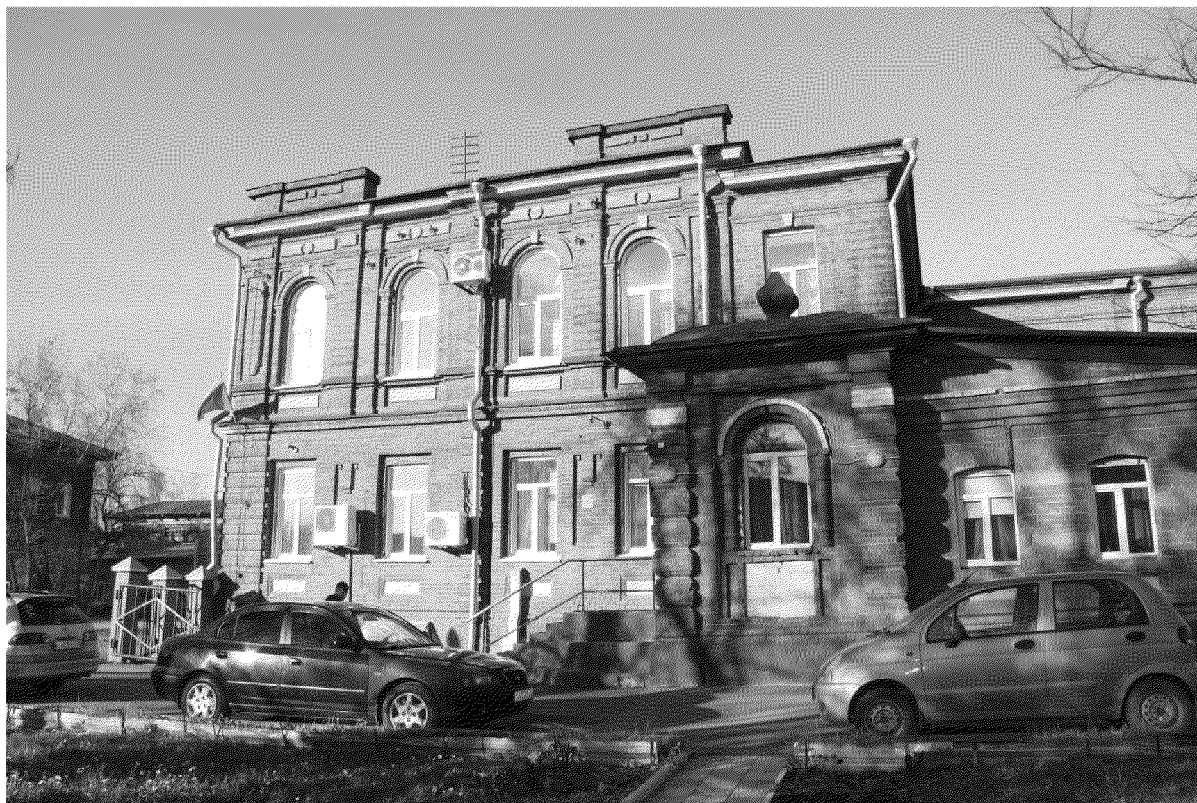
Видовая точка № 6. Южный фасад здания.
