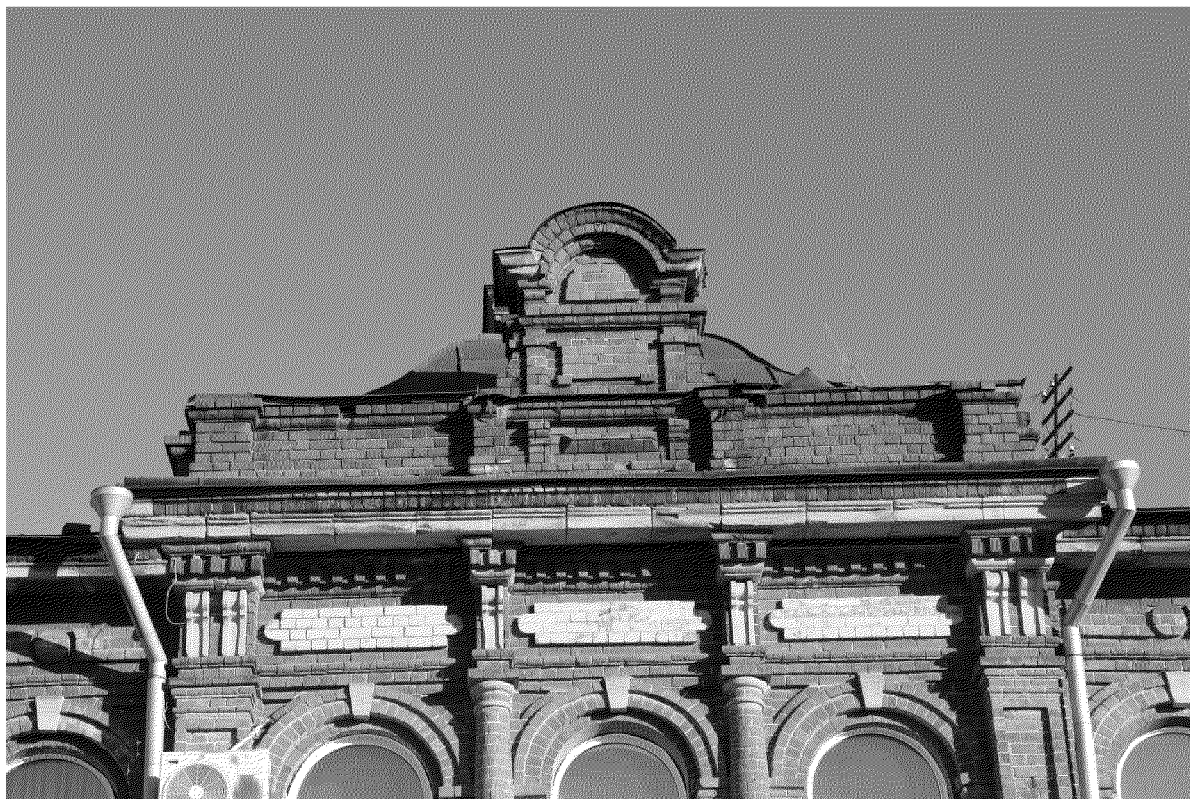
Видовая точка № 3. Аттик главного (западного) фасада
