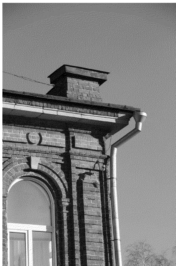
Видовая точка № 8. Фрагмент главного (западного) фасада.
