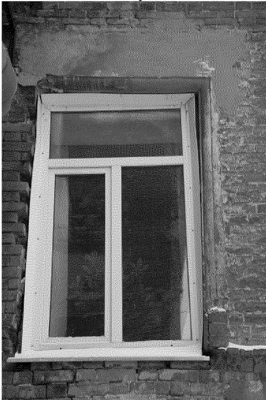
Видовая точка № 9 Штукатурное обрамление оконного проема 2-го этажа южного фасада
