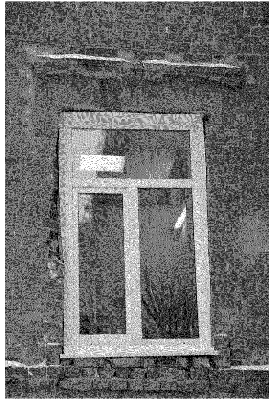
Видовая точка № 8 Оконный проём 2-го этажа с плитами песчаника для сандрика
