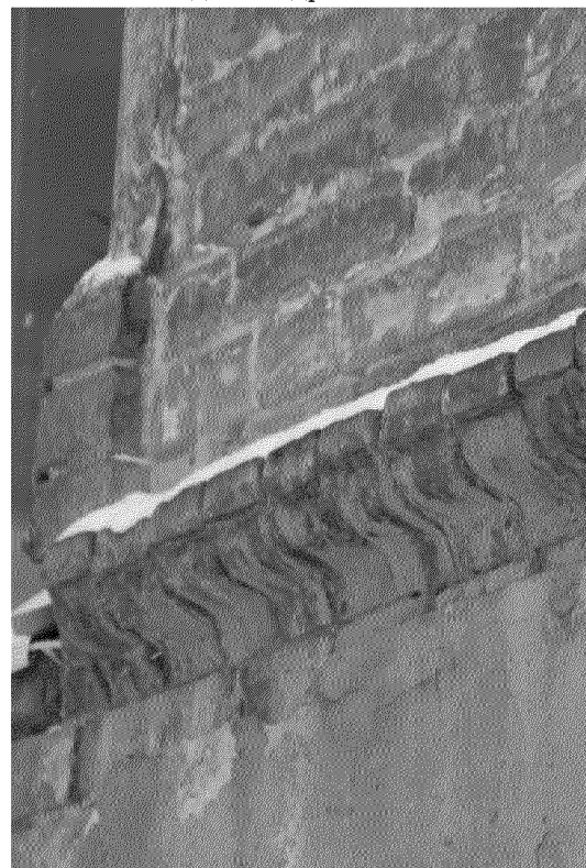
Видовая точка № 10 Профильный пояс под оконными проемами 2-го этажа южного фасада
