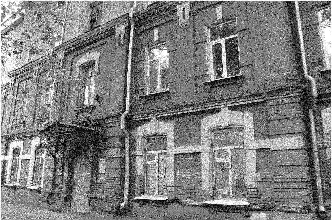
Видовая точка № 89. ул. Кулёва, 32. Фрагмент главного западного фасада здания
