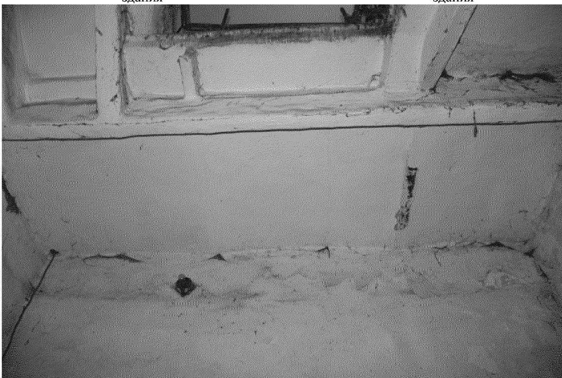
Видовая точка № 104. Междуэтажная площадка на кирпичных сводах по металлическим балкам трёхмаршевой лестницы
