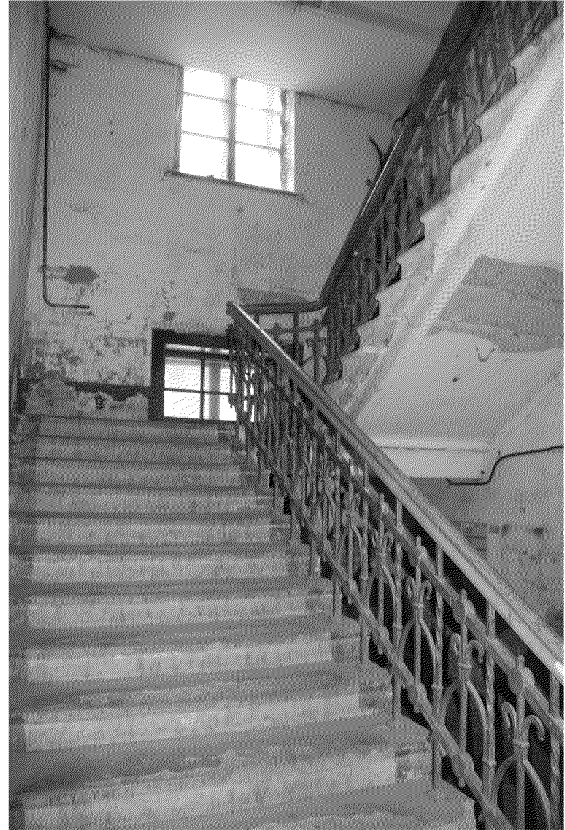
Видовая точка № 97. Фрагмент парадной лестницы со ступенями из песчаника и кованым ограждением
