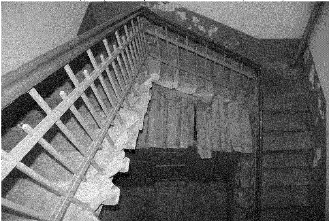
Видовая точка № 84. Трёхмаршевая лестница юго-восточной части здания (04.07.2025)
