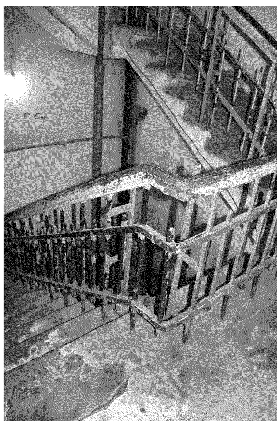
Видовая точка № 103. Трёхмаршевая лестница юго-восточной части здания
