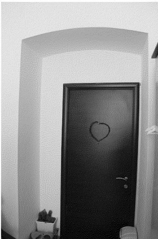
Видовая точка № 107. Лучковый дверной проём в помещении 1-го этажа южной части здания
