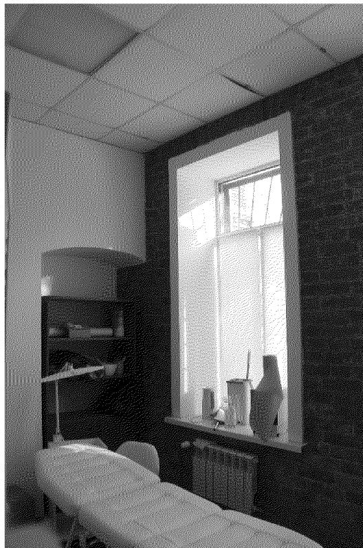
Видовая точка № 108. Лучковый дверной проём в помещении 1-го этажа восточной части здания
