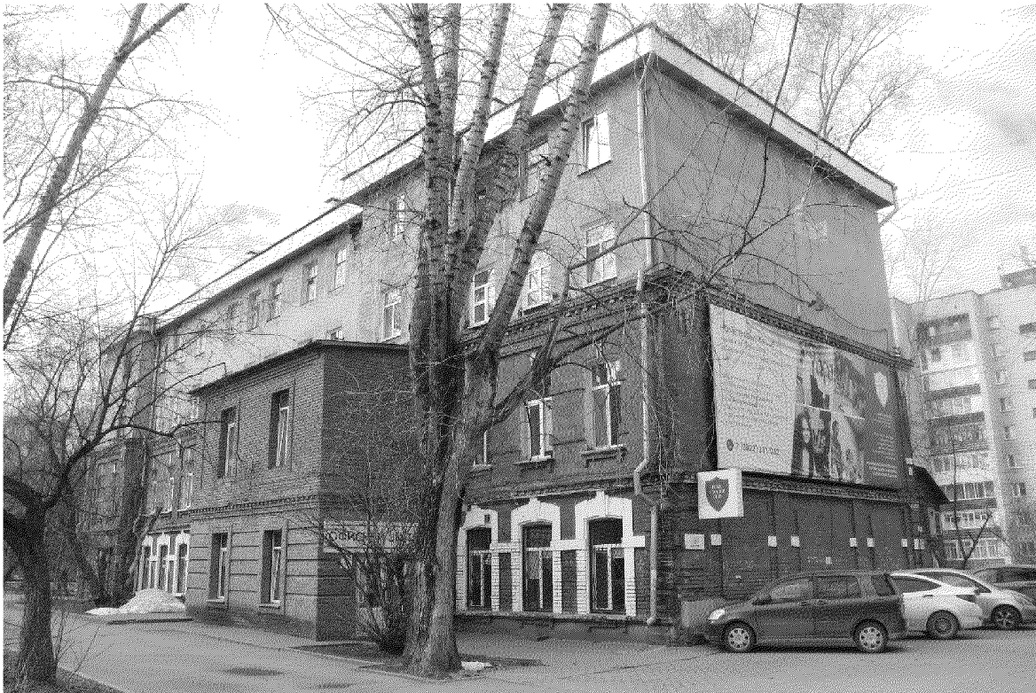
Видовая точка № 88. ул. Кулёва, 32. Общий вид здания с северо-восточной стороны
