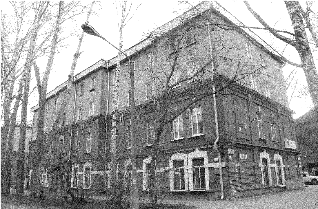
Видовая точка № 85. ул. Кулёва, 32. Общий вид здания с юго-западной стороны
