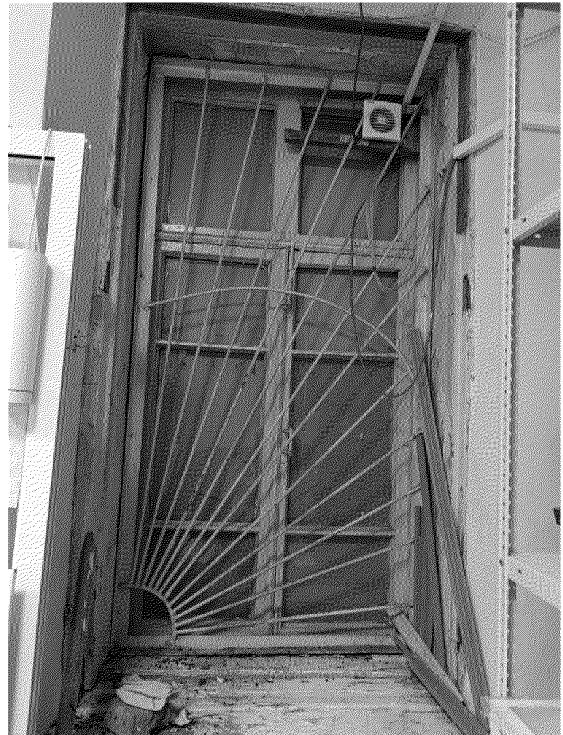
Видовая точка № 106. Исторический оконный блок 1-го этажа (в месте пристройки)
