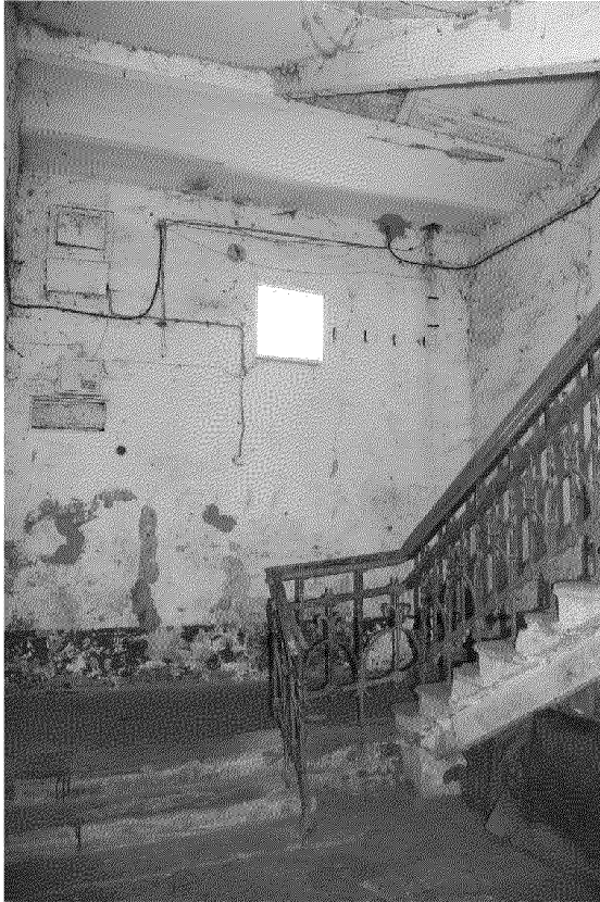
Видовая точка № 96. Фрагмент парадной лестницы со ступенями из песчаника и кованым ограждением (1 этаж)
