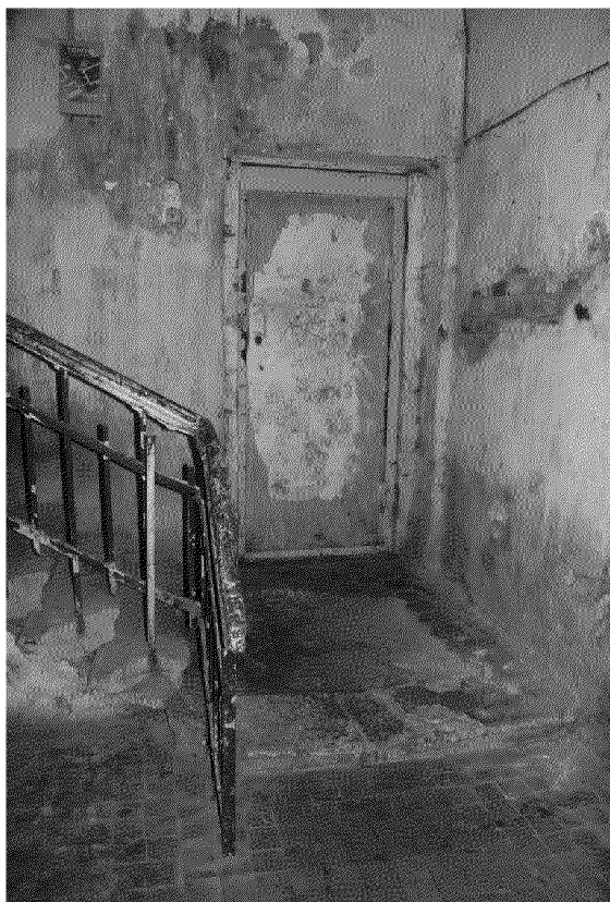
Видовая точка № 102. Трёхмаршевая лестница юго-восточной части здания
