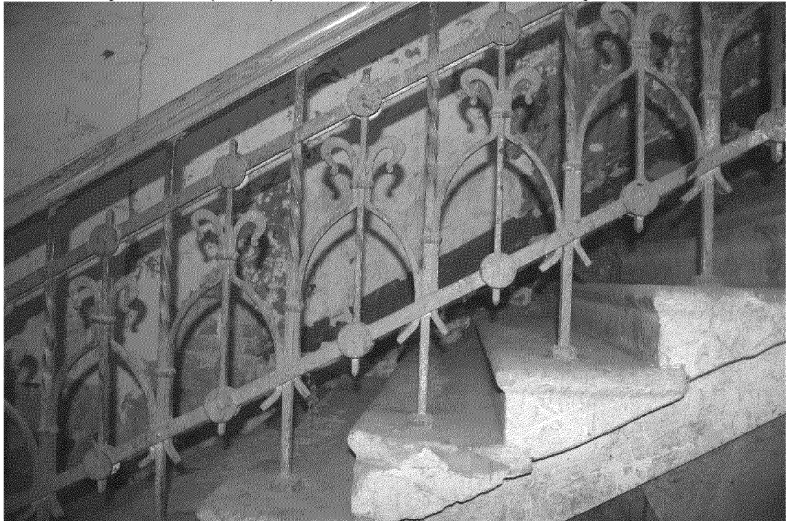
Видовая точка № 98. Фрагмент кованого ограждения парадной лестницы
