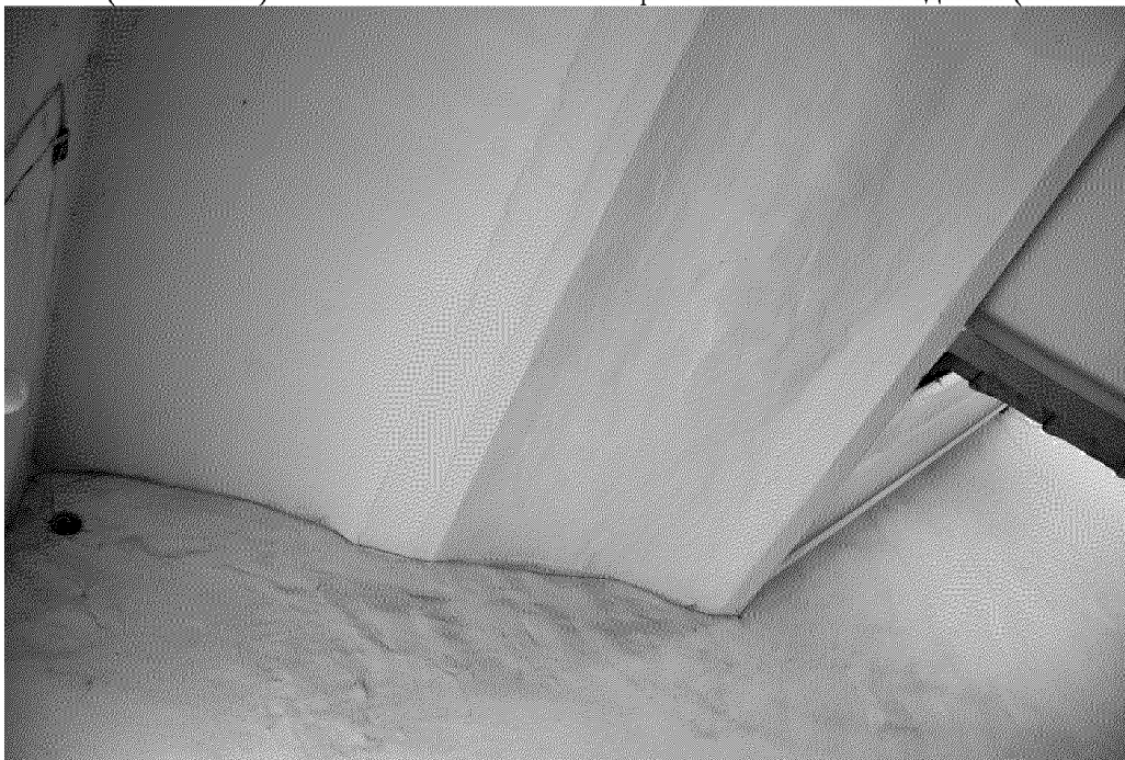
Видовая точка № 81. Кирпичные своды по металлическим балкам междуэтажной лестничной площадки (04.07.2025)
