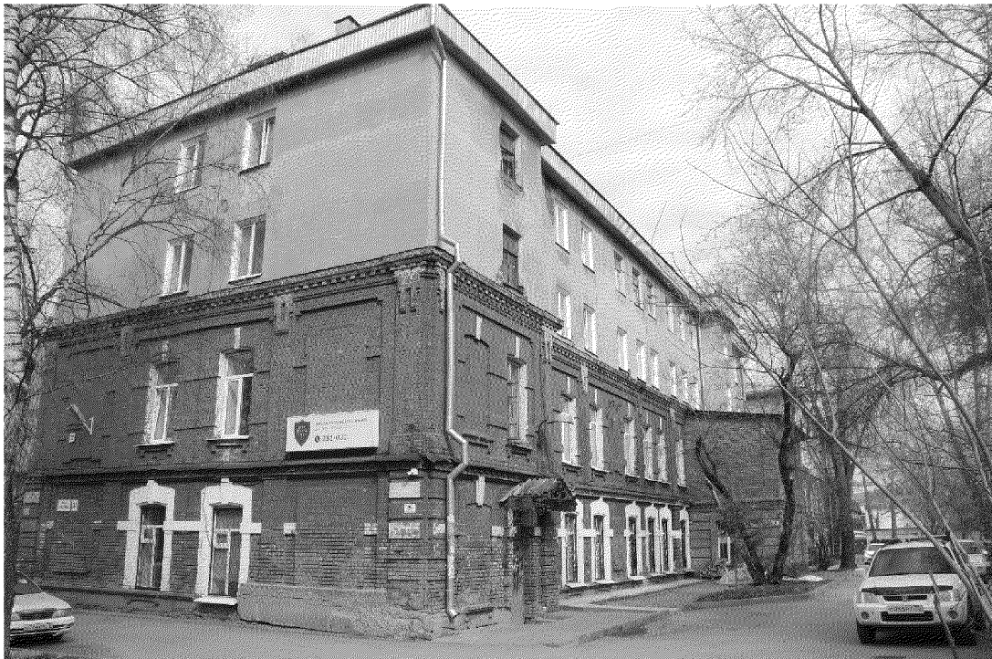
Видовая точка № 86. ул. Кулёва, 32. Общий вид здания с юго-восточной стороны
