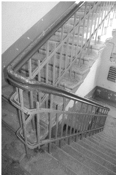
Видовая точка № 79. Двухмаршевая лестница северо-восточной части здания (04.07.2025)
