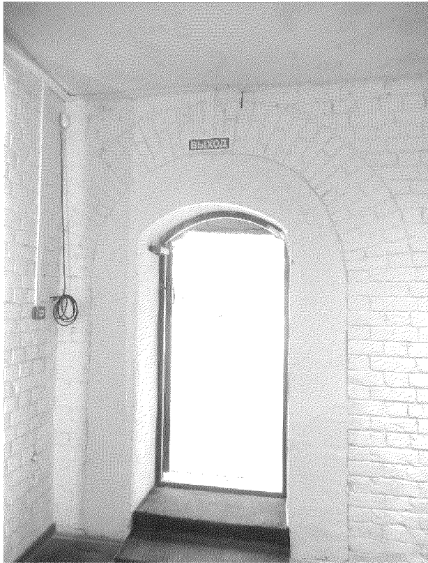
Видовая точка № 10. Дверной проём основного входа на 1-й этаж (Пчелинцева А.В., 2025)
