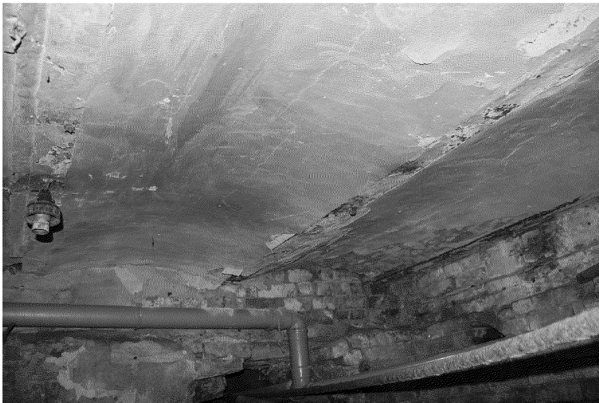
Видовая точка № 16. Кирпичные своды перекрытия в помещении подвала
