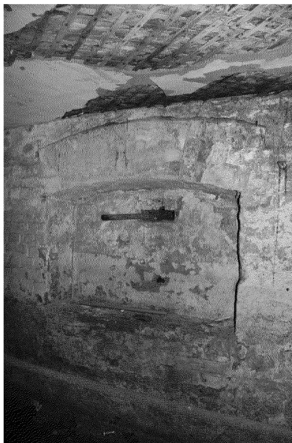
Видовая точка № 15. Оконный проём в помещении подвала
