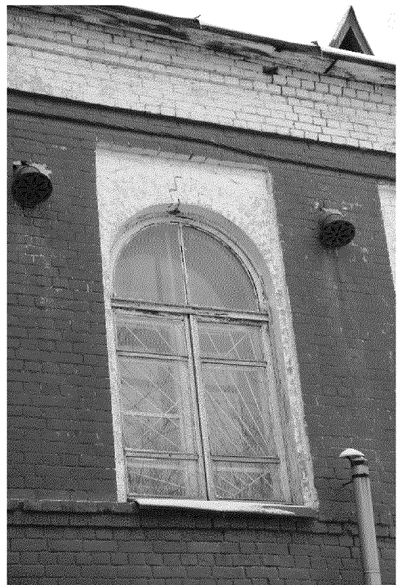
Видовая точка № 6. Окно 2 этажа северного фасада с обрамлением в виде ниши
