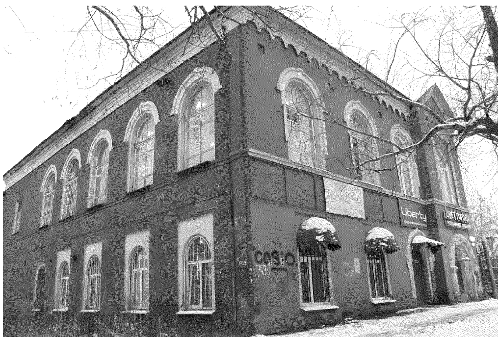
Видовая точка № 2. Общий вид здания с юго-восточной стороны
