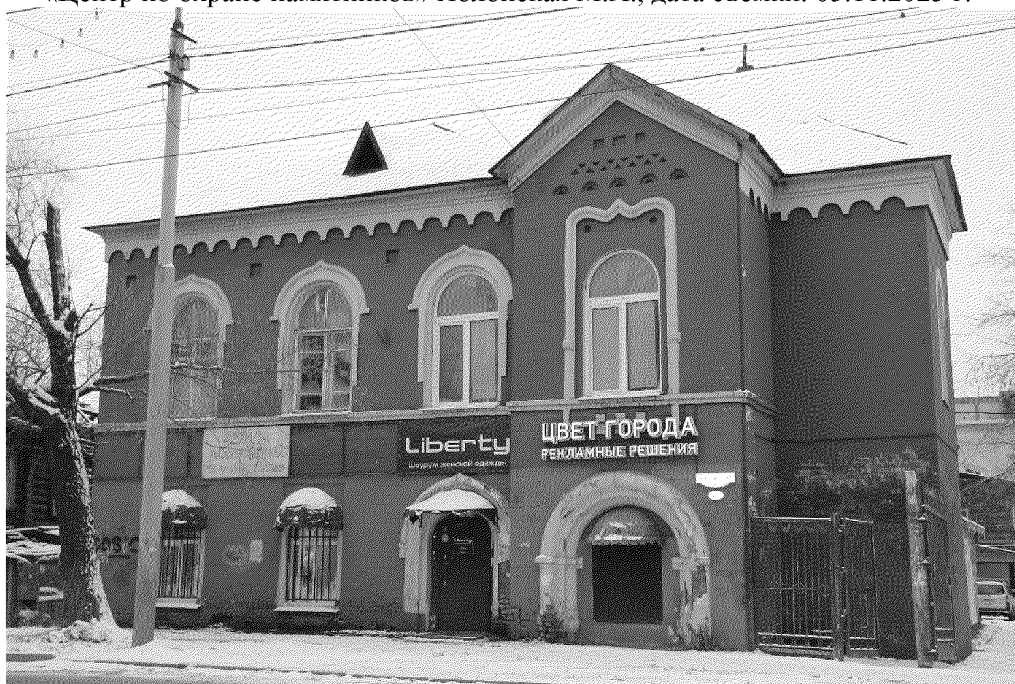
Видовая точка № 1. Главный восточный фасад здания
