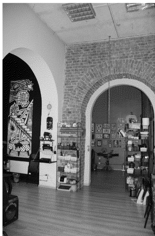
Видовая точка № 9. Арочные проёмы в помещении лестницы (2-й этаж)
