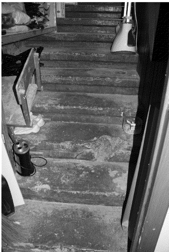
Видовая точка № 14. Бетонная двухмаршевая лестница северной части здания
